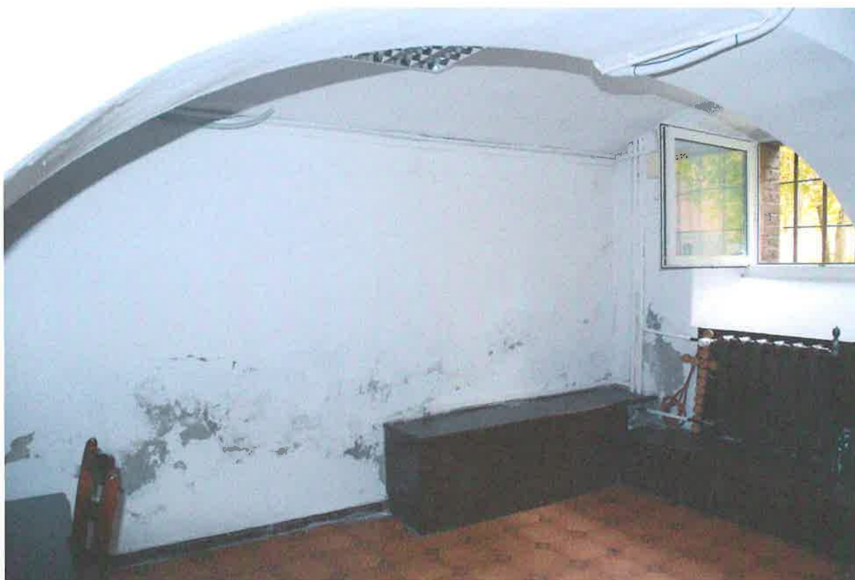
Zawilgocenia ścian pomieszczeń kondygnacji podziemnej,
