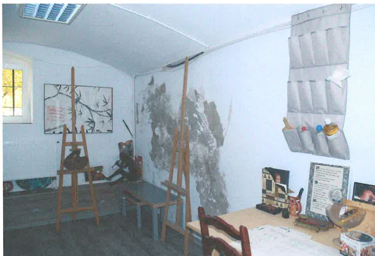
Zawilgocenia ścian pomieszczeń kondygnacji podziemnej,
