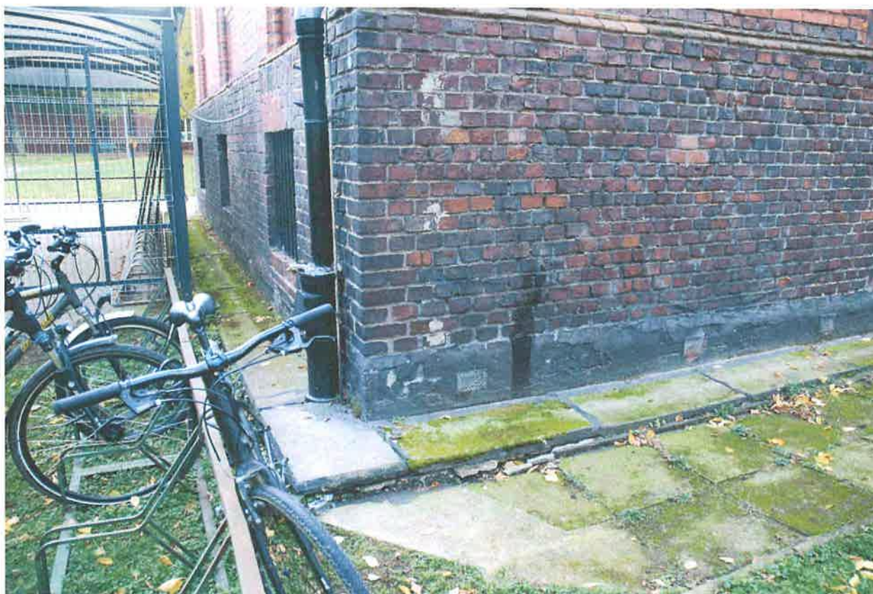
Pn-wsch narożnik bocznego skrzydła budynku, widoczna uszkodzona izolacja zewnętrzna i opaska betonowa wzdłuż ściany
