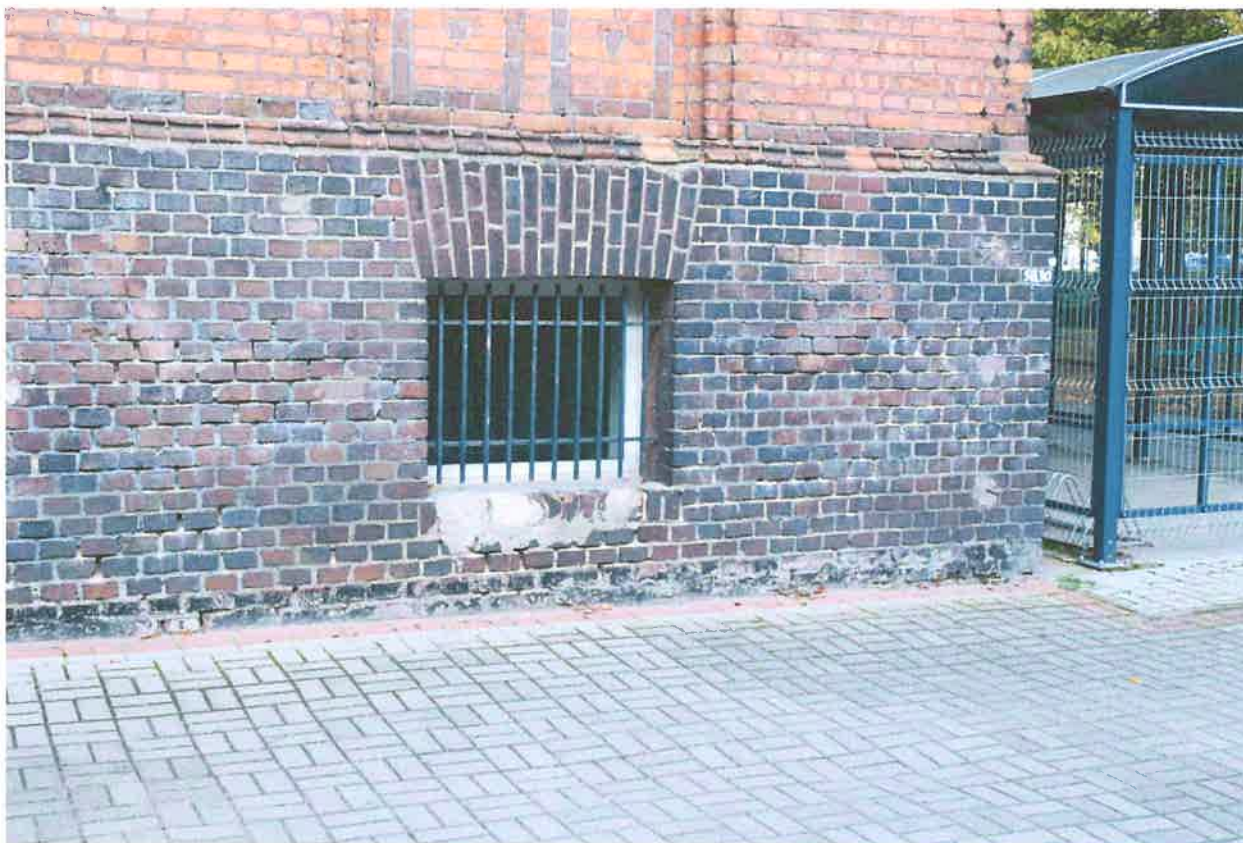
Cokół od strony południowej, u dołu widoczna pozostałość izolacji zewnętrznej ściany
