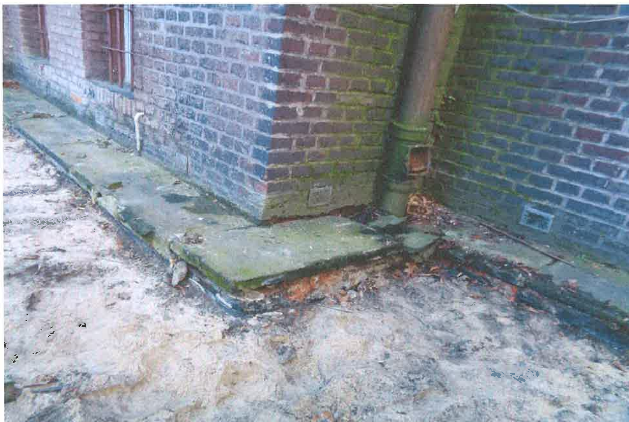
Uszkodzenia opaski betonowej w rejonie rury spustowej
