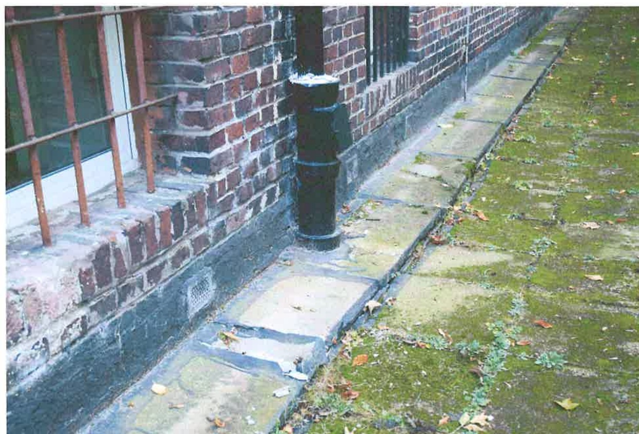
Widok cokotu z izolacją zewnętrzną i opaską betonową wzdłuż ściany
