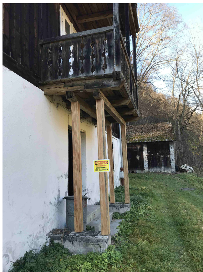
Fot. nr 6 Zabezpieczenie balkonów przed zawaleniem
