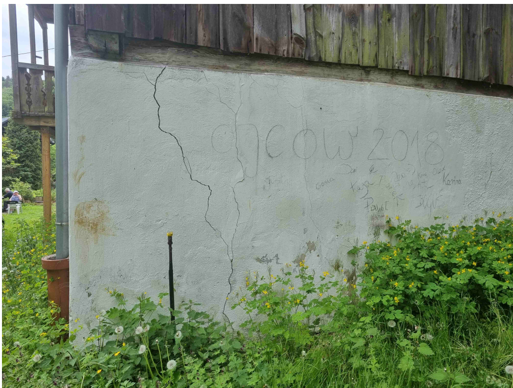
Fot. nr 7 Pęknięcie na ścianie narożnika północno-wschodniego widok z zewnątrz
