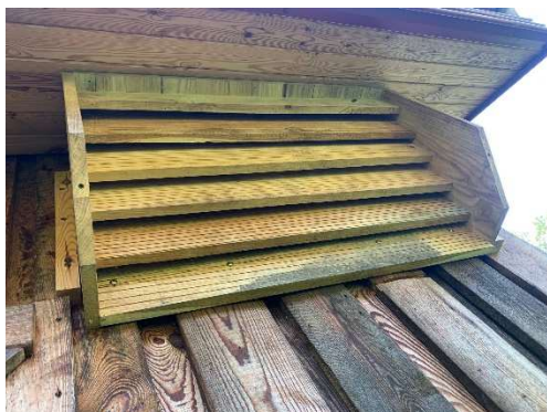
Zdj 2. Element drewniany umożliwiający nietoperzom zakładanie kolonii
