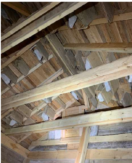
Zdj 4. Widok przykładowej więźby z elementami umożliwiającymi nietoperzom zaczepienie się.
