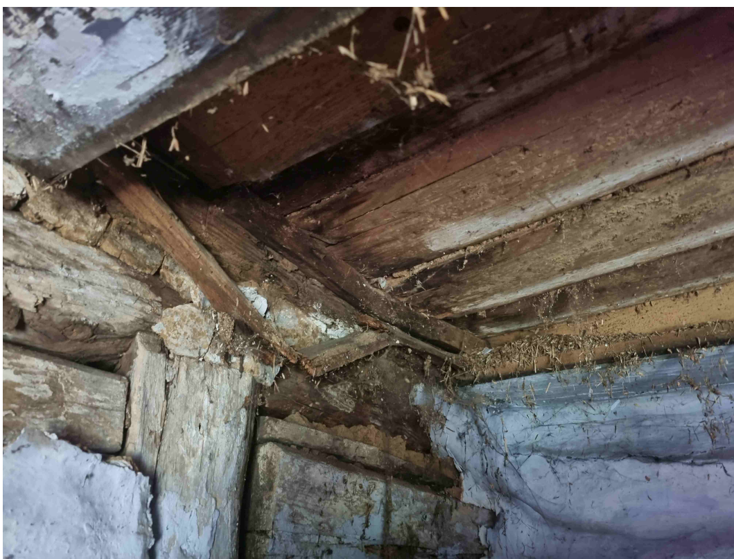
Fot. nr 14 Zawalony strop nad przyziemiem – zbutwiałe belki stropowe
