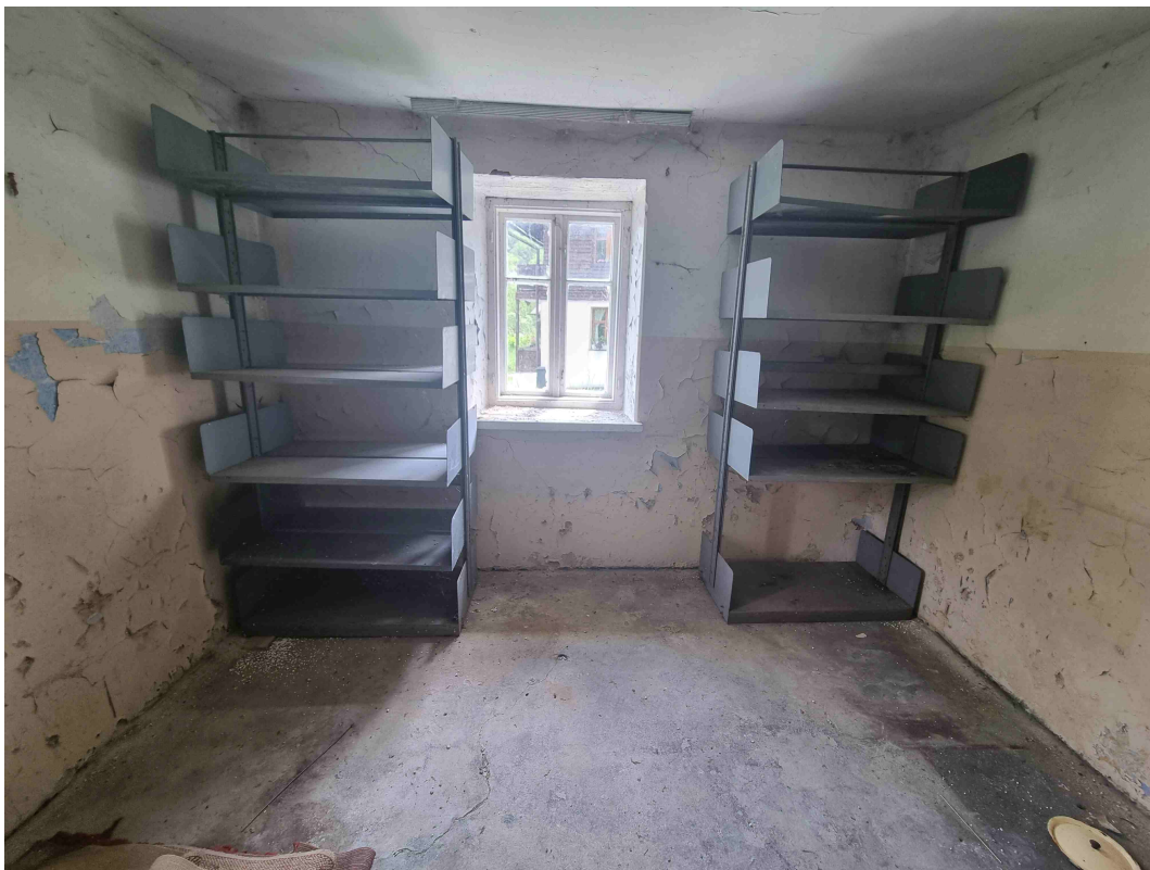
Fot. nr 21 Ściany przyziemia od środka, widoczne zawilgocenia
