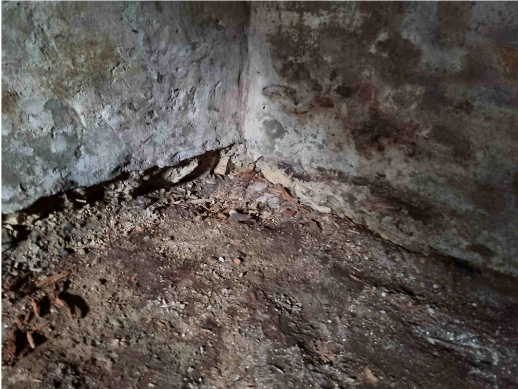
Fot. nr 11 Podkopana ściana zewnętrzna– widok od środka
