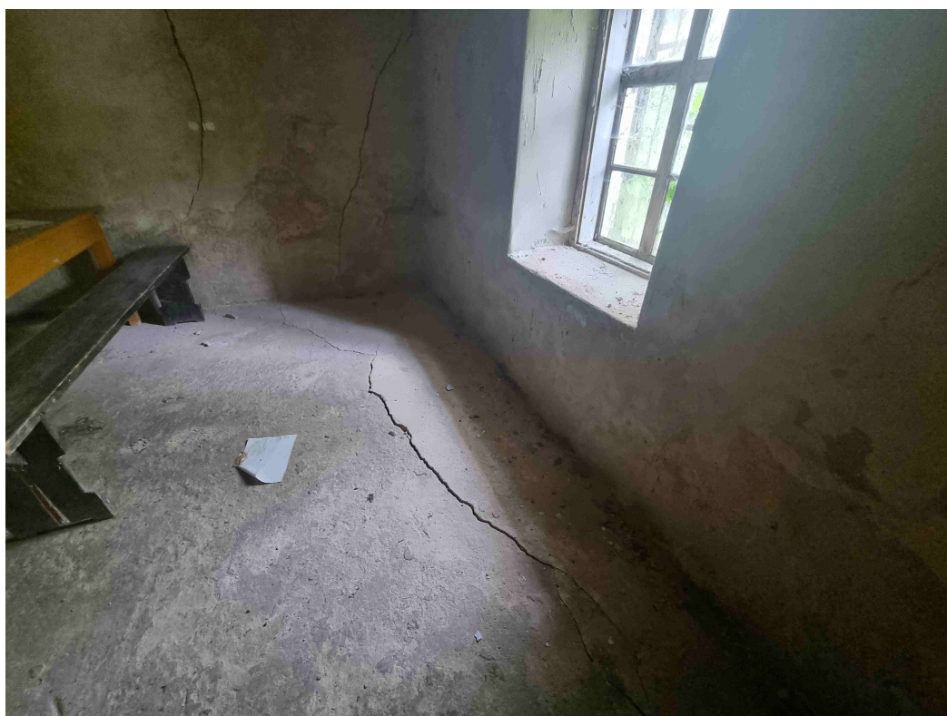
Fot. nr 8 Pęknięcie na ścianie narożnika północno-wschodniego oraz na wylewce widok z wewnątrz. Wylewka zapadnięta
