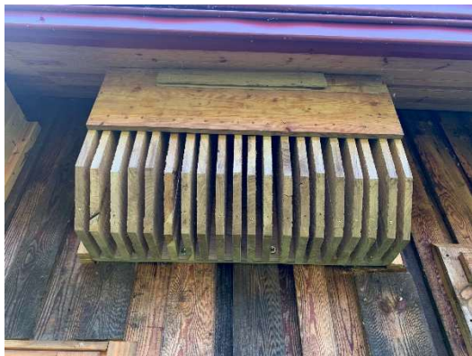
Zdj 1. Element drewniany umożliwiający nietoperzom zakładanie kolonii
