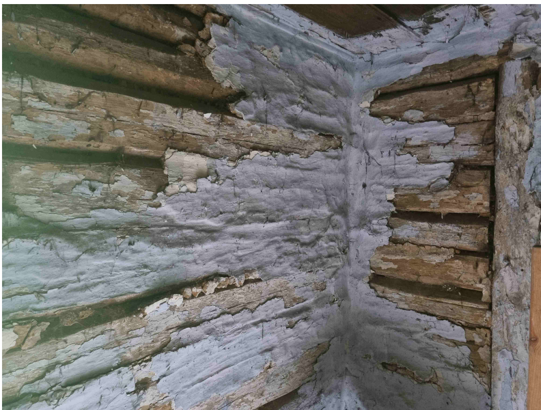
Fot. nr 17 Ściana wewnętrzna – ubytki tynków, brak pakułów
