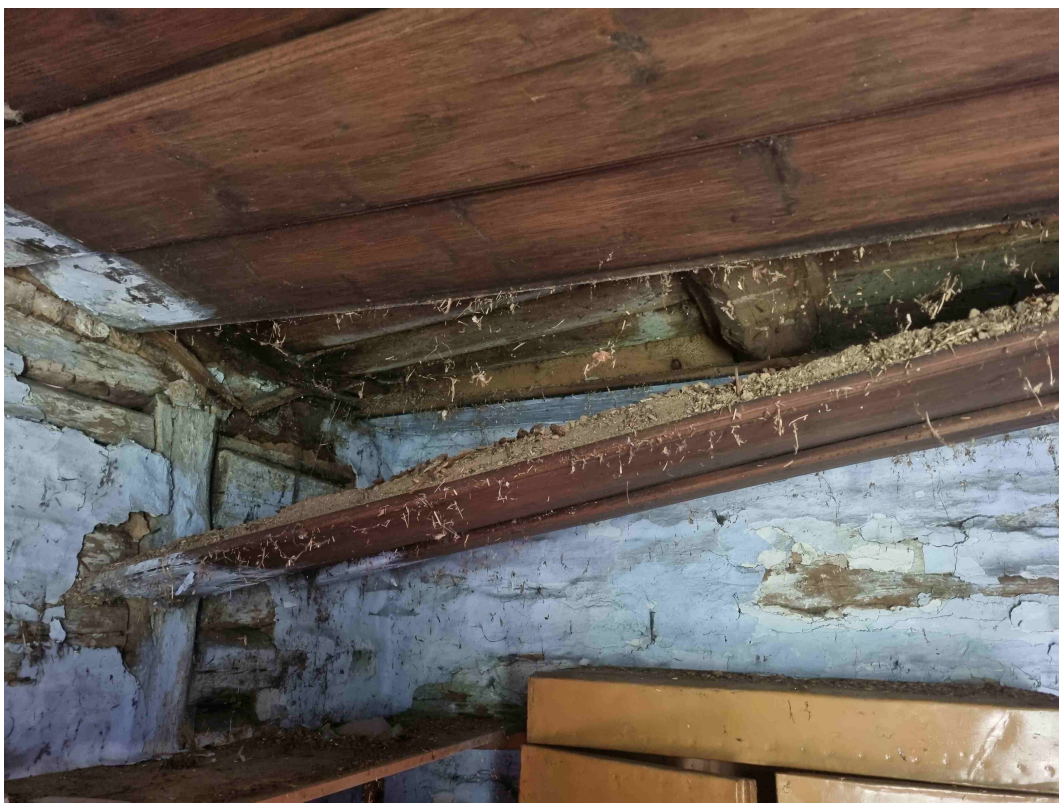
Fot. nr 13 Zawalony strop nad przyziemiem
