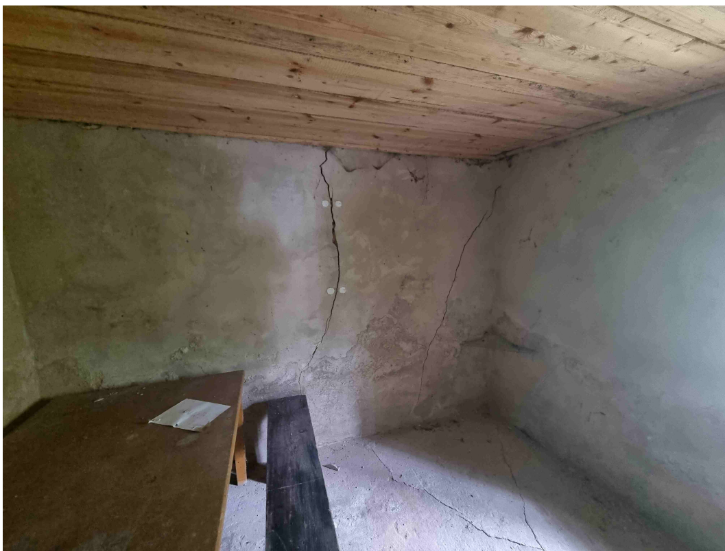
Fot. nr 9 Pęknięcie ściany przyziemia
