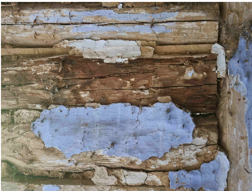
Fot. nr 19 Ściana wewnętrzna – widoczna korozja biologiczna elementów drewnianych
