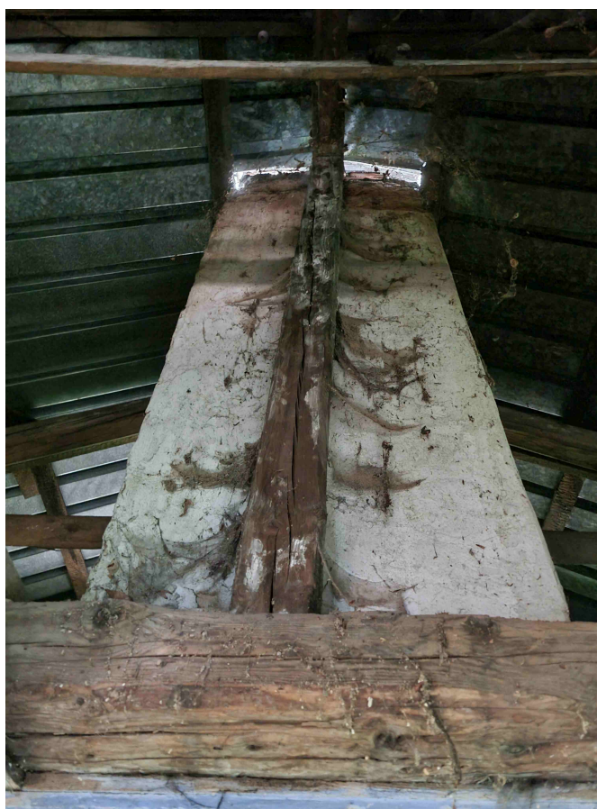
Fot. nr 20 Nieszczelności połączeń dachowych
