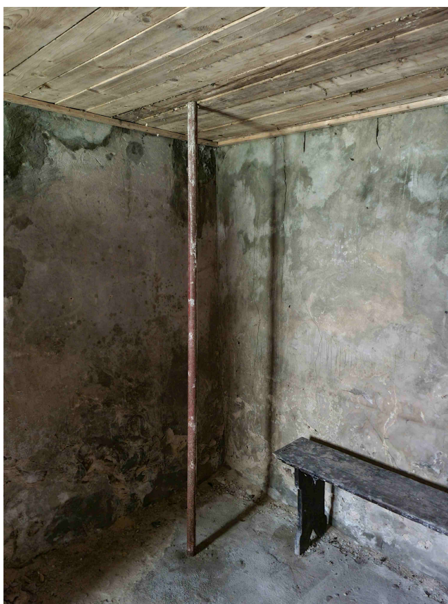
Fot. nr 10 Zabezpieczenie stropu nad przyziemem przed zawaleniem
