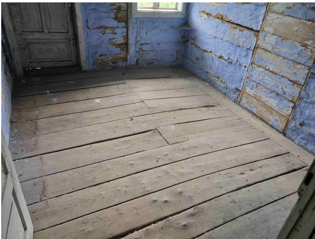
Fot. nr 15 Ugięcia i deformacje stropu nad parterem
