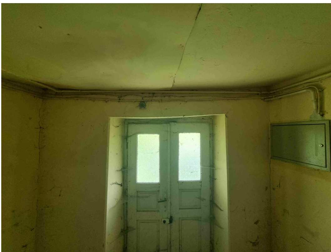
Fot. nr 16 Ugięcia i deformacje stropu nad przyziemiem.
