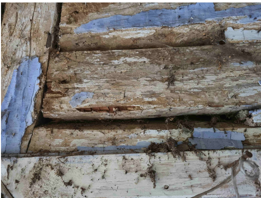
Fot. nr 18 Ściana wewnętrzna – widoczna korozja biologiczna elementów drewnianych
