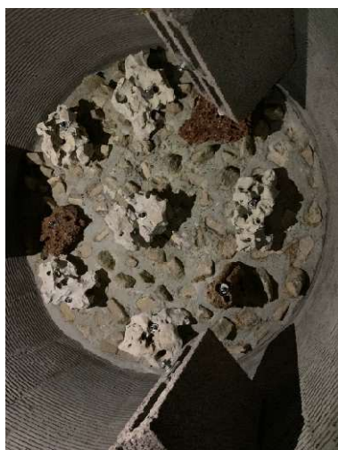
Zdj 3. Przykładowe wnętrze szachtu z elementami ułatwiającymi nietoperzom zaczepienie się.
