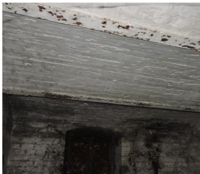
Foto nr OT.P-2,3 – Widok na ściany i strop piwnicy. Widoczne zalegające liście. Stan techniczny stropu Kleina dostateczny, widoczna korozja belek stalowych. Brak spękań na ścianach.
