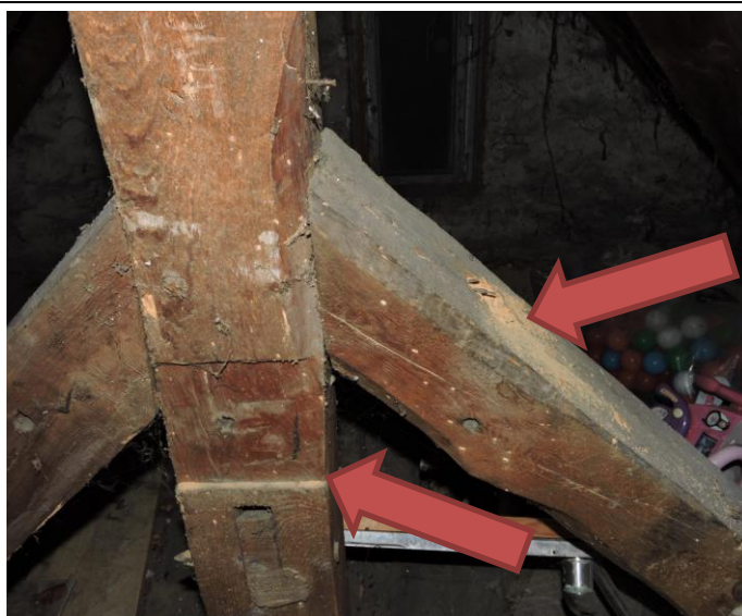
Foto nr OT.2-9– Widoczna degradacja przekroju elementu drewnianego. Oceniono ok.15% ubytku przekroju. Widoczny brak elementu konstrukcyjnego usztywniającego ustrój nośny.
