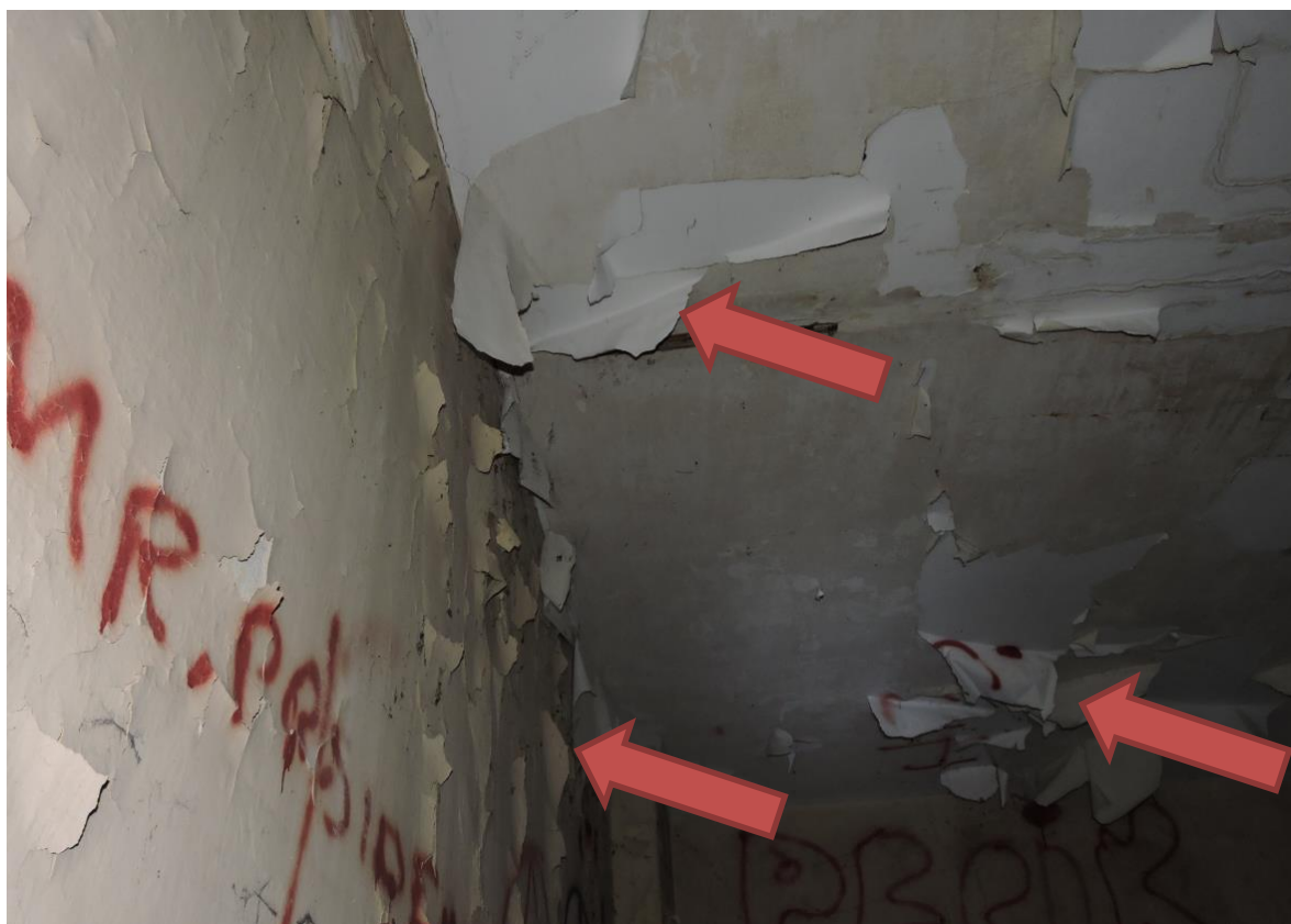
Foto nr OT.0-4 – Widok na okładziny ścienne i sufitowe Stan techniczny wykazujące nadmierne uszkodzenie.
