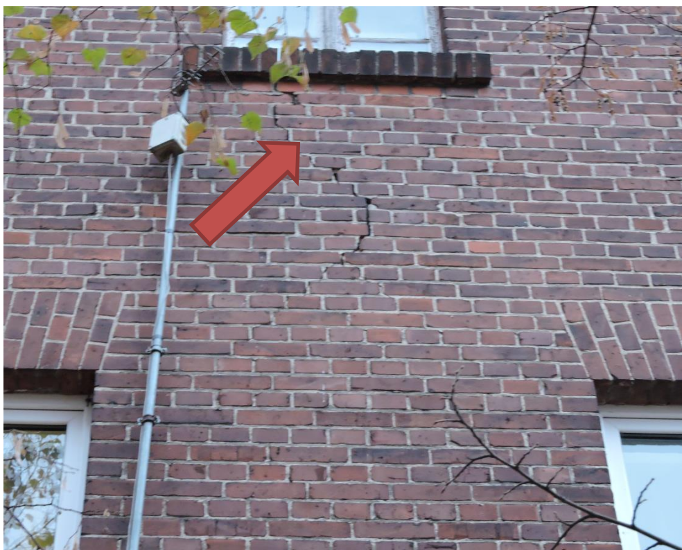
Foto nr OT.E-6– Widoczne spękania elewacji wschodniej – ściany nośnej.
