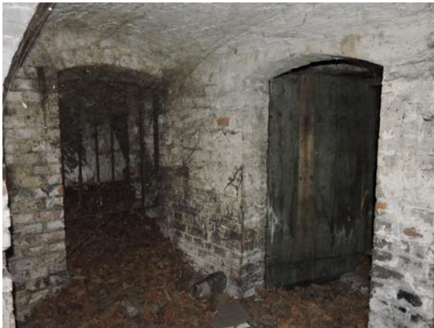
Foto nr OT.P-1 – Widok na ściany piwnicy, brak spękań i śladów zawilgocenia. Widoczne znaczne ilości zalegających liści.
