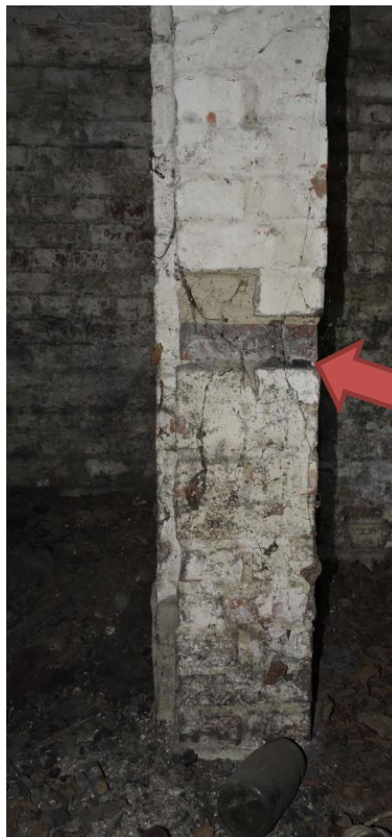
Foto nr OT.P-6 – Widoczny ubytek cegły w ścianie fundamentowej, nie wpływa to na nośność ściany.
