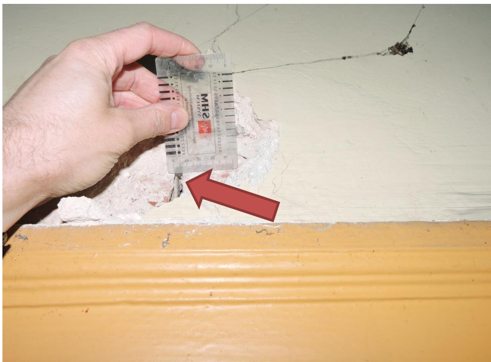
Foto nr OT.0-7 – Widok na rysę nadproża, szerokość rysy ok 7 mm.
