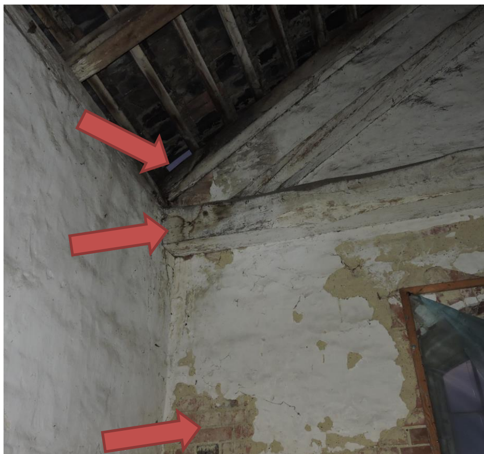
Foto nr OT.0-14– Widok na dźwigar dachowy, szczytowy w części magazynowej. Widoczne zawilgocenie konstrukcji spowodowane ubytkiem w pokryciu dachowym. Dodatkowo widoczny stan techniczny okładzin ściennych.
