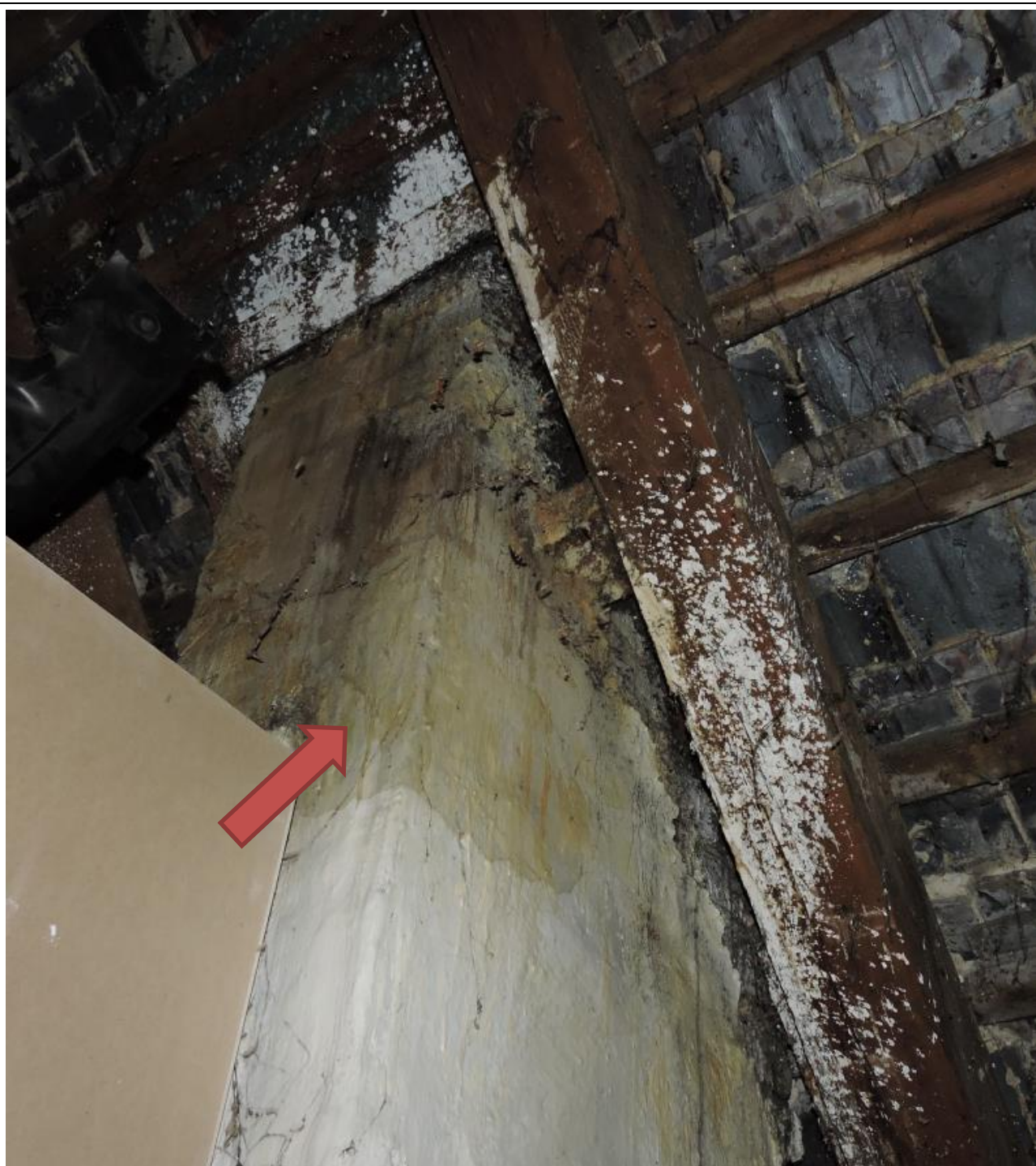
Foto nr OT.2-11– Widoczne zawilgocenie komina, co świadczy o braku szczelności pokrycia dachowego oraz okucia przejść dachowych (okiennych i kominowych).
