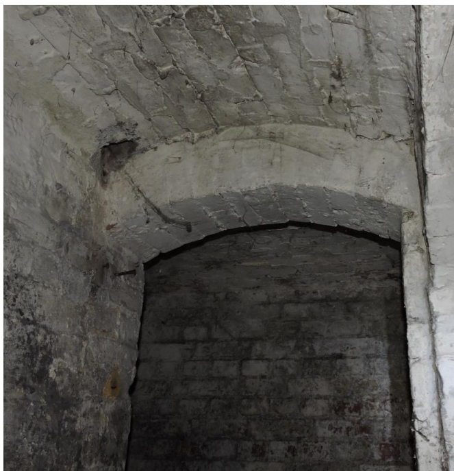
Foto nr OT.P-4 – Widok na nadproże ceglane w piwnicy- brak spękań oraz uszkodzeń.
