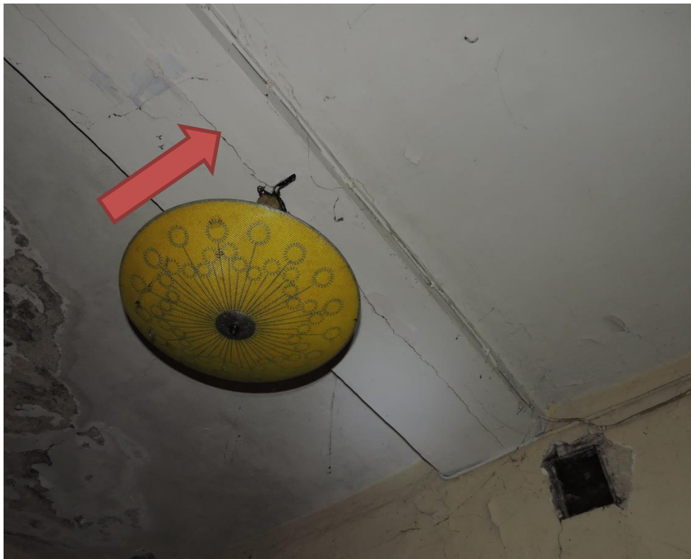
Foto nr OT.0-1 – Wido na drewnianą belkę stropową. Widoczne odspokojenia i odparzenia oraz zarysowania.
