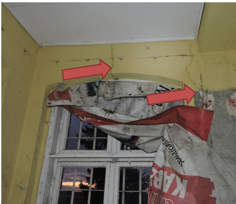
Foto nr OT.0-12– Widok na nadproże części wystającej z elewacji budynku. Widoczne spękanie nadproża oraz rysa wzdłuż połączenia z całym budynkiem.
