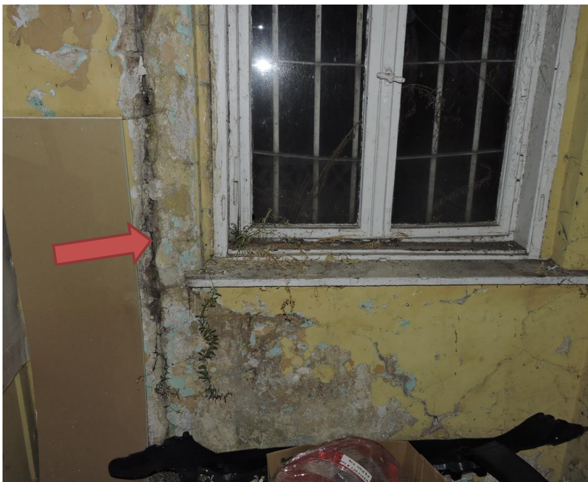
Foto nr OT.0-10 – Widoczne spękanie ściany na całej jej wysokości. Spękanie oddziela część wystającą z elewacji budynku. Prawdopodobnie spękanie występuje również na fundamencie.
