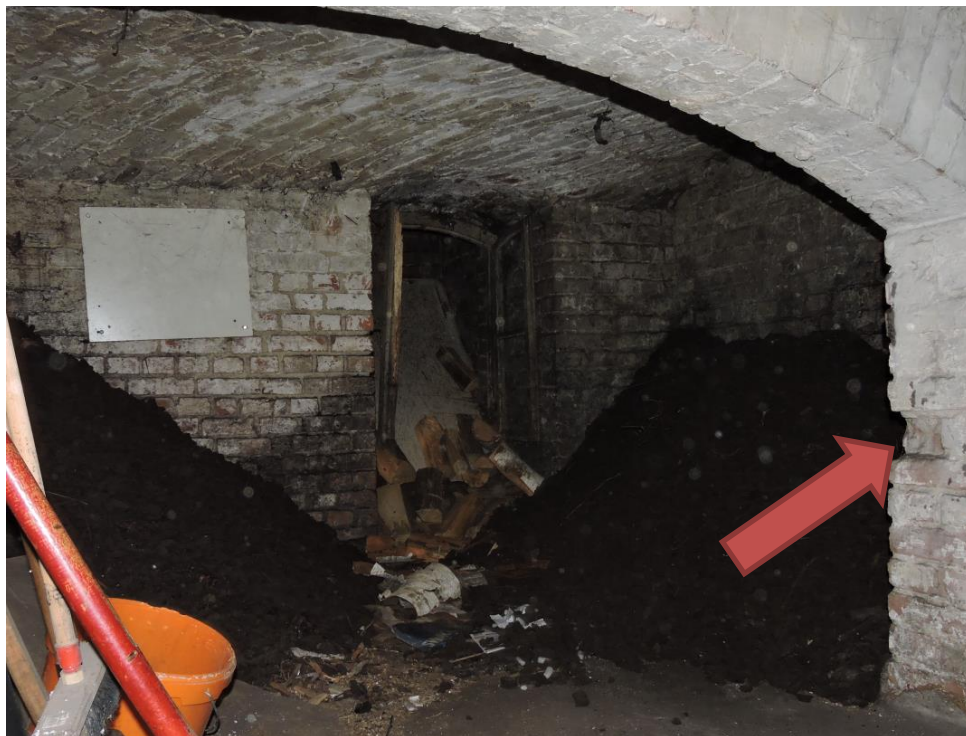
Foto nr OT.P-11 – Widok na konstrukcje ścian, nadproże ceglane oraz strop. Widoczne ubytki cegieł w murze.
