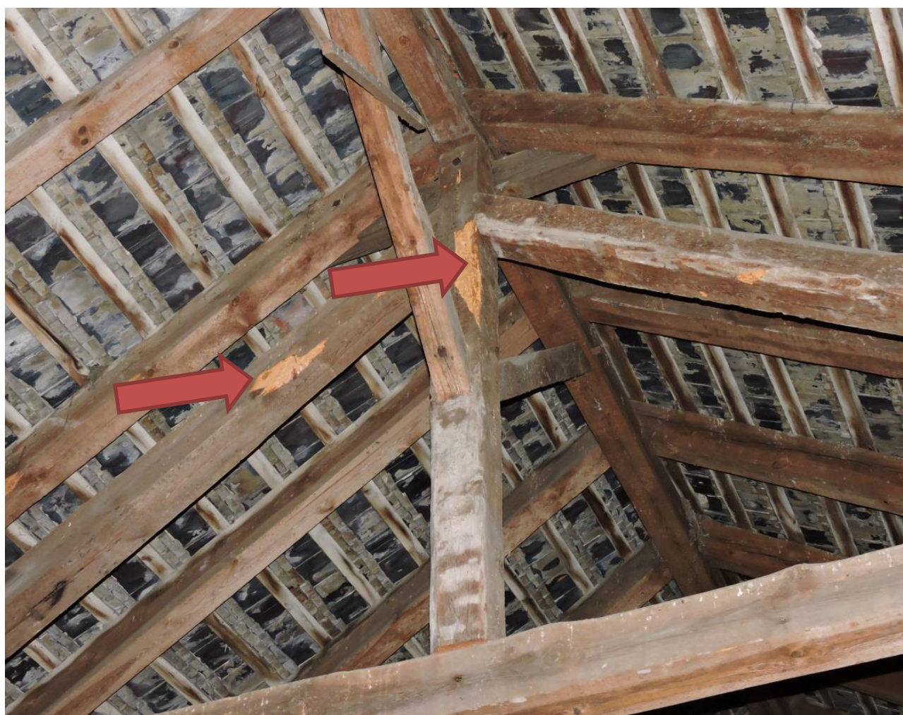
Foto nr OT.0-15– Widok na konstrukcje dachu magazynu. Widoczne uszkodzenia mechaniczne.
