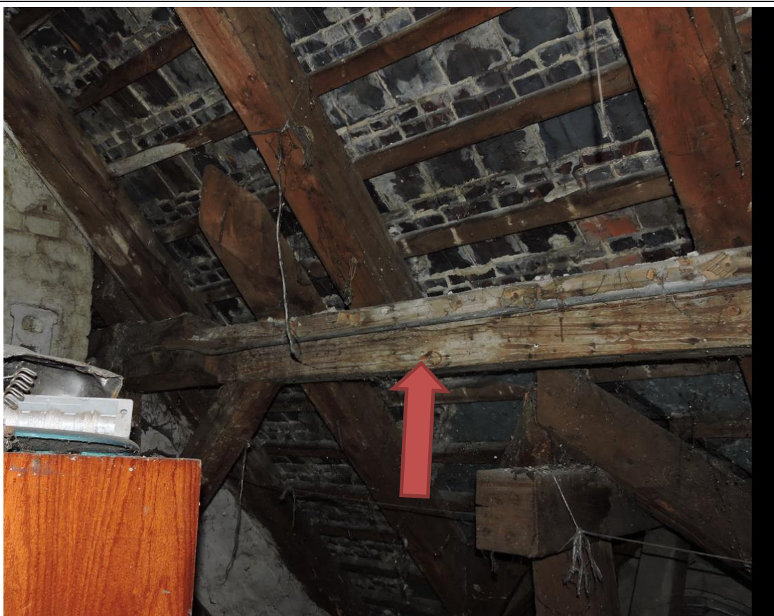
Foto nr OT.2-7 – Widok na konstrukcje wykusza dachowego. Widoczna korozja biologiczna elementów drewnianych..
