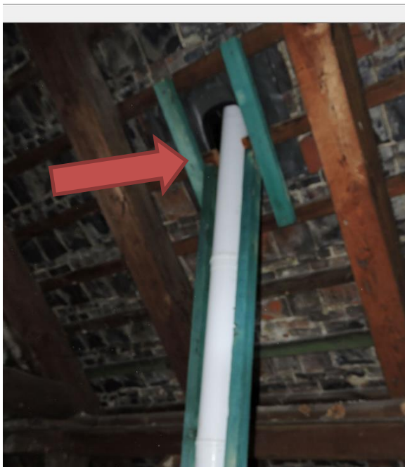
Foto nr OT.2-6 – Widok na wykonany pion wentylacyjny komina spalinowego, który spowodował przeciek pokrycia dachowego. Widoczne zawilgocenie łat i konstrukcji dachu.
