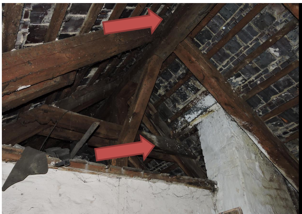
Foto nr OT.2-2 – Widok na konstrukcję dachu. Widoczna korozja biologiczna elementów drewnianych, Zawilgocenie w obrębie komina
