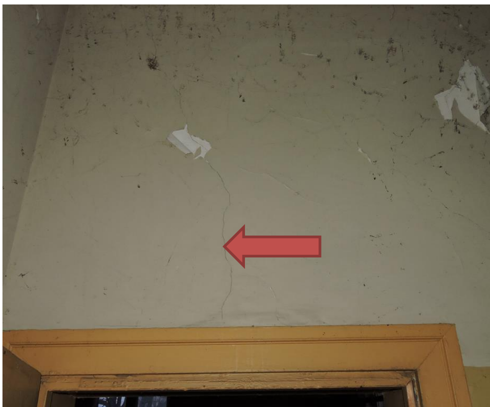
Foto nr OT.0-6 – Widok na zarysowanie nadproża drzwiowego, wewnętrznego
