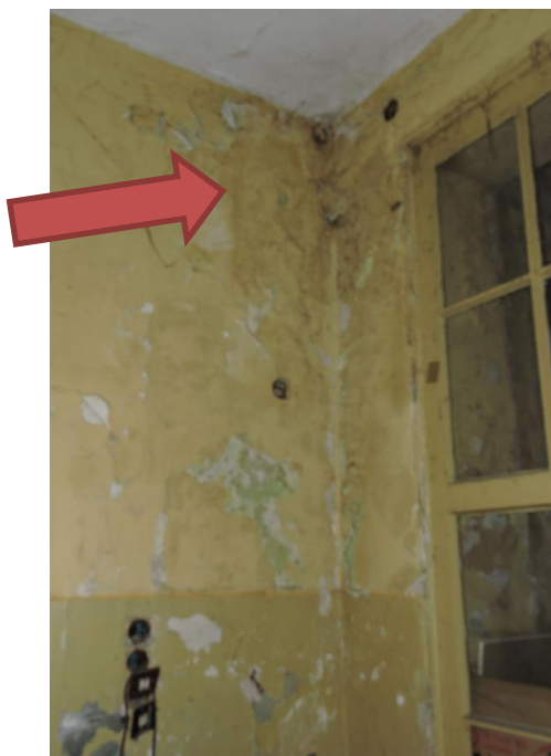
Foto nr OT.0-11– Widoczne zawilgocenie ścian zewnętrznych.
