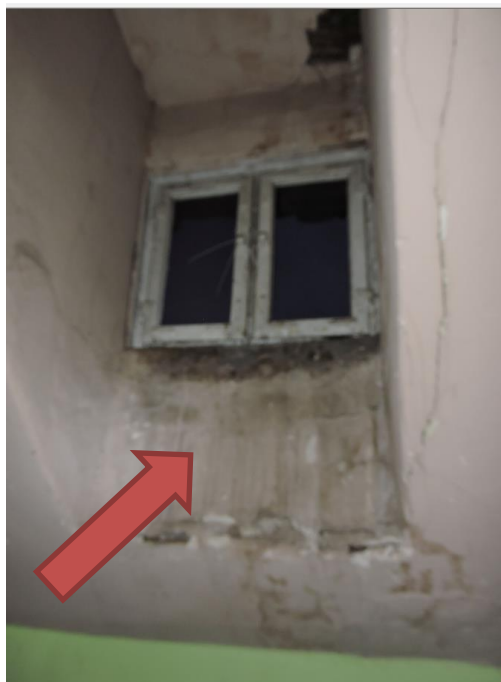
Foto nr OT.2-12– Widok na stolarkę okienną na korytarzu 1 piętra. Widoczne zawilgocenie okładzin ściennych.
