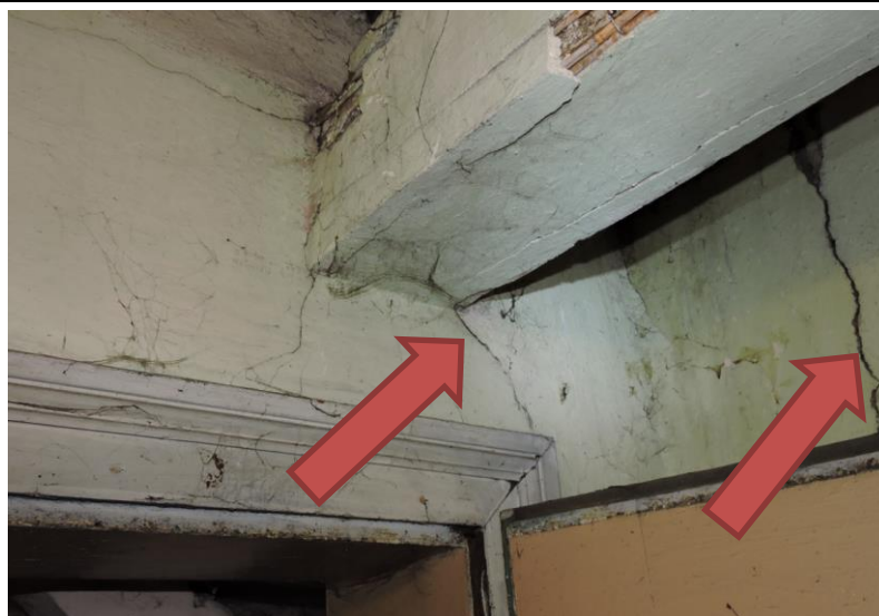
Foto nr OT.2-8 – Widoczne liczne spękania w miejscu oparcia belki konstrukcyjnej na poddaszu.
