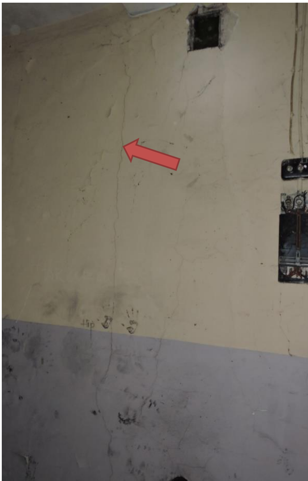
Foto nr OT.0-3 – Widoczne spękania konstrukcyjne ściany nośnej od belki stropowej.
