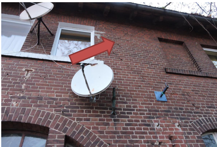
Foto nr OT.E-7– Widok na elewację południową. Widoczne spękania ściany nośnej. Spowodowane dodatkowymi siłami poziomymi od nadmiernej deformacji konstrukcji dachowej.
