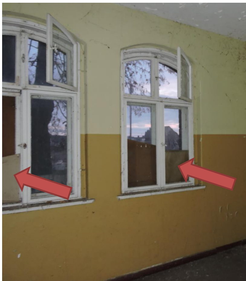
Foto nr OT.0-8 – Widoczny stan techniczny stolarki okiennej – liczne uszkodzenia mechaniczne.
