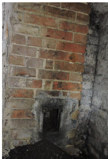
Foto nr OT.P-7 – Widok na fragment murowy komina. Widoczne lokalne uszkodzenia okładzin.
