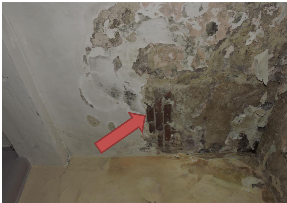
Foto nr OT.0-2 – WIdok na narożnik ściany na parterze. Widoczny zły stan techniczny ścian, i stropu. Liczne zawilgocenie, odspojenie i ubytki okładzin.
