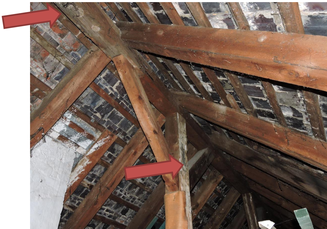
Foto nr OT.2-1 – Widok na konstrukcję dachu. Widoczne zawilgocenia i pleśń na elementach konstrukcyjnych
