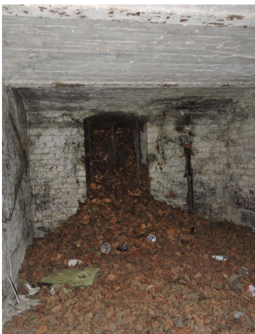
Foto nr OT.P-2,3 – Widok na ściany i strop piwnicy. Widoczne zalegające liście. Stan techniczny stropu Kleina dostateczny, widoczna korozja belek stalowych. Brak spękań na ścianach.
