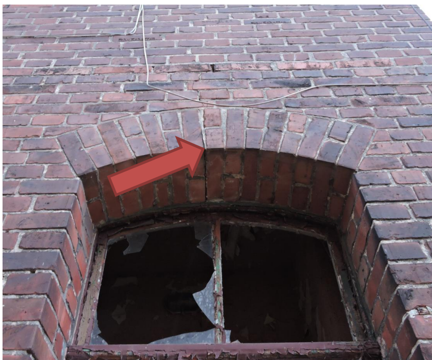
Foto nr OT.E-7– Widok na nadproże drzwiowe. Widoczna rysa. Spowodowana rozporowym charakterem nadproża przy niedostatecznej sztywności ścian zewnętrznych.
