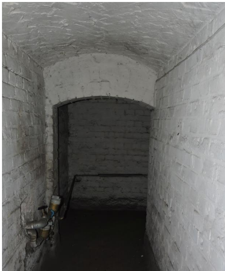
Foto nr OT.P-8 – Widok na korytarz piwnicy pod częścią użytkowaną. Stan ścian, nadprożu i stropu dobry.
