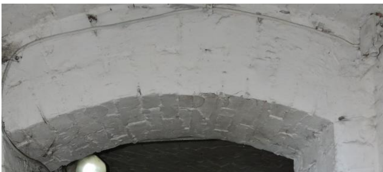
Foto nr OT.P-9 – Widok na nadproże ceglane, łukowe w piwnicy. Widoczny dobry stan techniczny.
