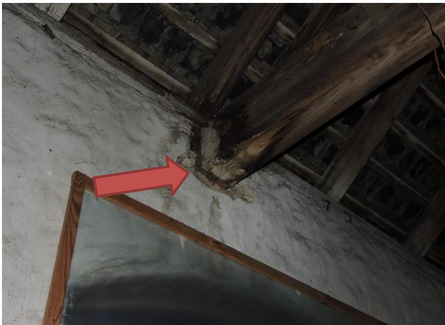
Foto nr OT.0-13– Widok na oparcie dźwigara dachowego w części magazynowej. Widoczne zawilgocenie drewna oraz pleśń,
