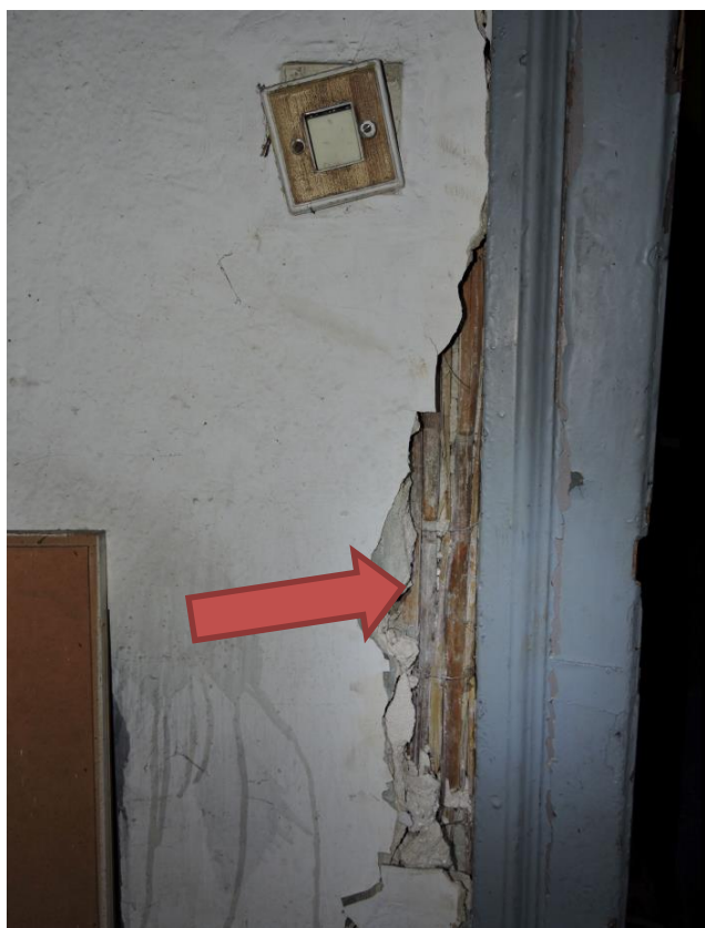
Foto nr OT.0-13– Widok na okładziny ścian. Widoczne uszkodzenie mechaniczne oraz zalanie
