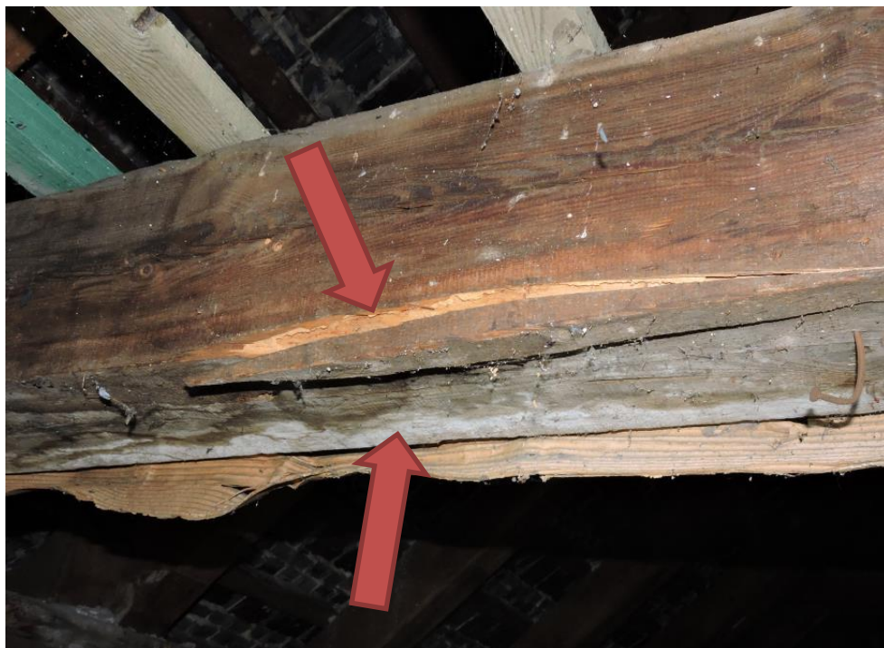
Foto nr OT.2-4 – Widok na kleszcze konstrukcji dachowej. Widoczne spękanie, pleśń i wilgoć.
