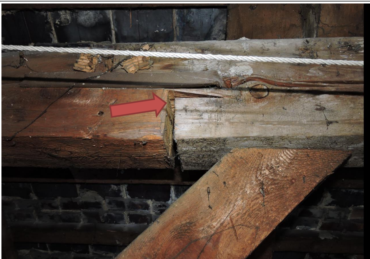
Foto nr OT.2-3 – Widok na węzeł konstrukcyjny dachu. Widoczne spękanie i deformacja.
