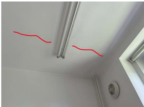
Rys. 7. Rysy na suficie w pomieszczeniu nr 4
