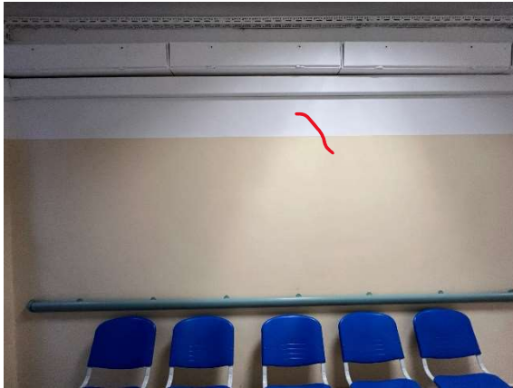
Rys. 10. Rysy na ścianie pomieszczenia nr 8 (od strony korytarza)
