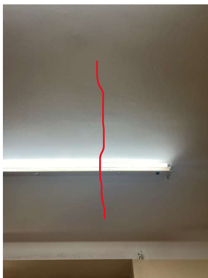
Rys. 8. Rysy na suficie w pomieszczeniu nr 6
