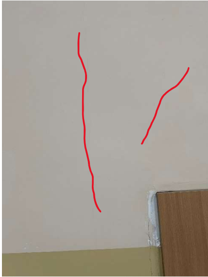
Rys. 9. Rysy na ścianie w pomieszczeniu nr 6
