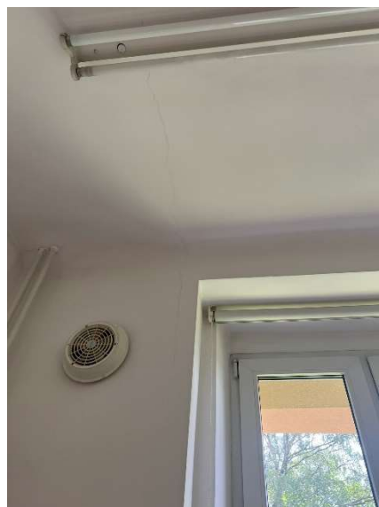
Rys. 7. Rysy na suficie w pomieszczeniu nr 4
