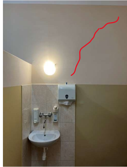
Rys. 9. Rysy na ścianie w pomieszczeniu nr 6
