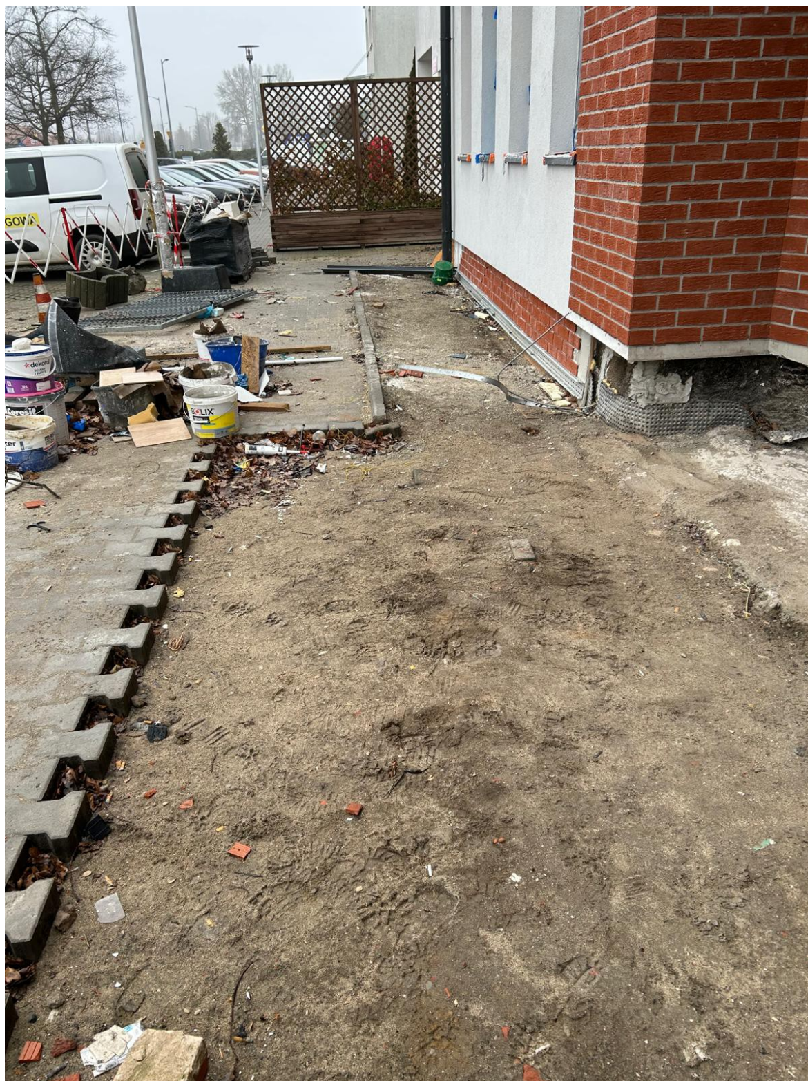
Niedokończone elementy zewnętrzne (schody, utwardzenie z kostki betonowej, opaska wokół budynku, trawnik) oraz pozostawione odpady na terenie budowy.
