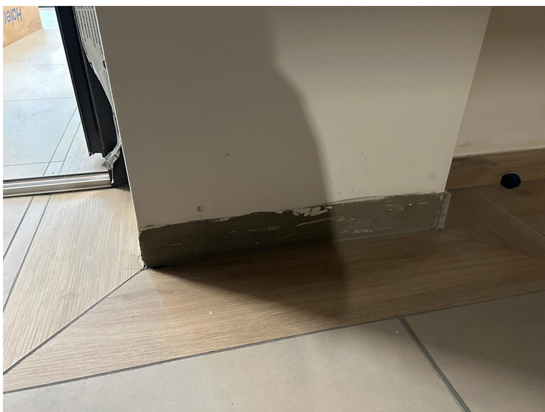
Niedokończone cokoły z płytek ceramicznych.
