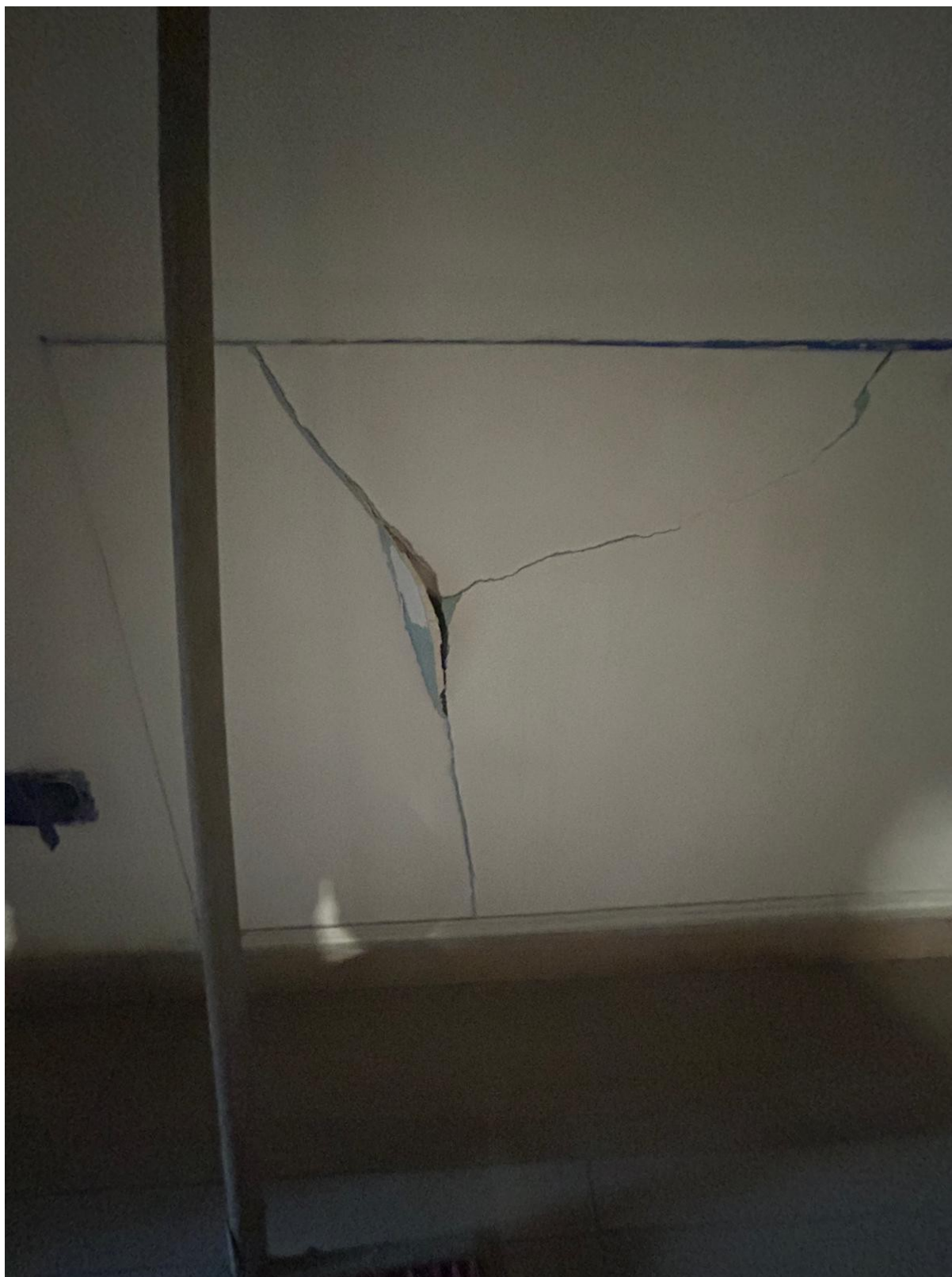
Uszkodzona rewizja z płyt kartonowo-gipsowych na sali widowiskowej.
