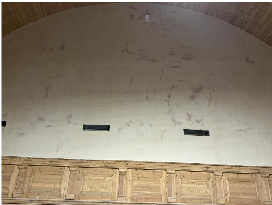
Ściana z płyt gkf widoczna z sali widowiskowej w sposób niechlujny zagruntowana.
