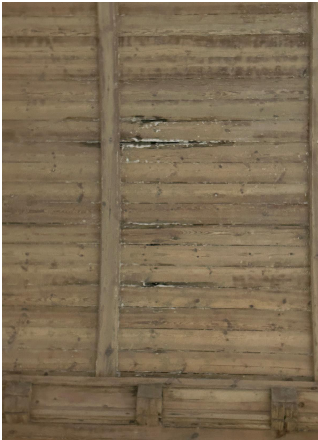
Widoczne zawilgocone deski w suficie sali widowiskowej do wymiany lub oczyszczenia.
