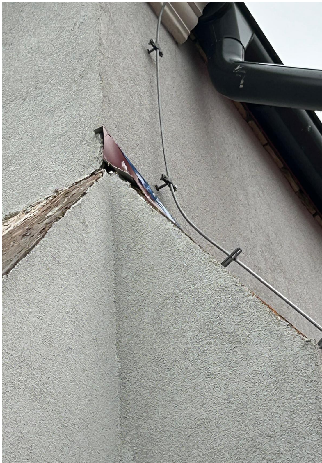
Braki wykończeniu opierzenia i przekrycia, brak estetyki.
