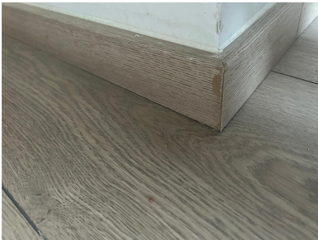
Uszkodzone narożniki listew wykończeniowych przy panelach podłogowych.
