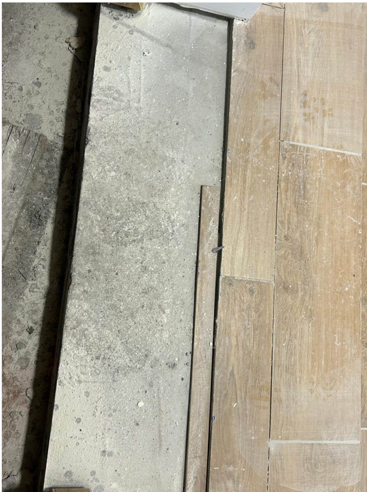
Niedokończone spoiny i stopnie przewidziane do wykończenia płytkami ceramicznymi.
