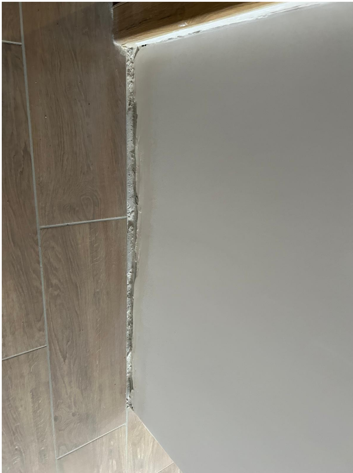
Niewykończone fragmenty posadzki przy ścianie.
