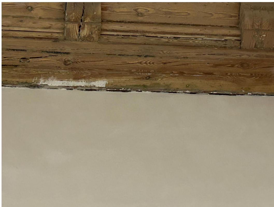
Niedokładnie oczyszczony sufit z niewypełnionymi ubytkami.
