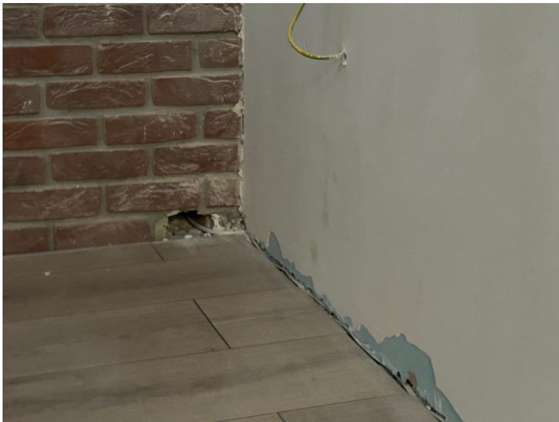
Pozostawione otwory, wymagające uzupełnienia, wadliwie wykończona ściana gładzią gipsową oraz zanieczyszczona ściana z płytki klinkierowej.
