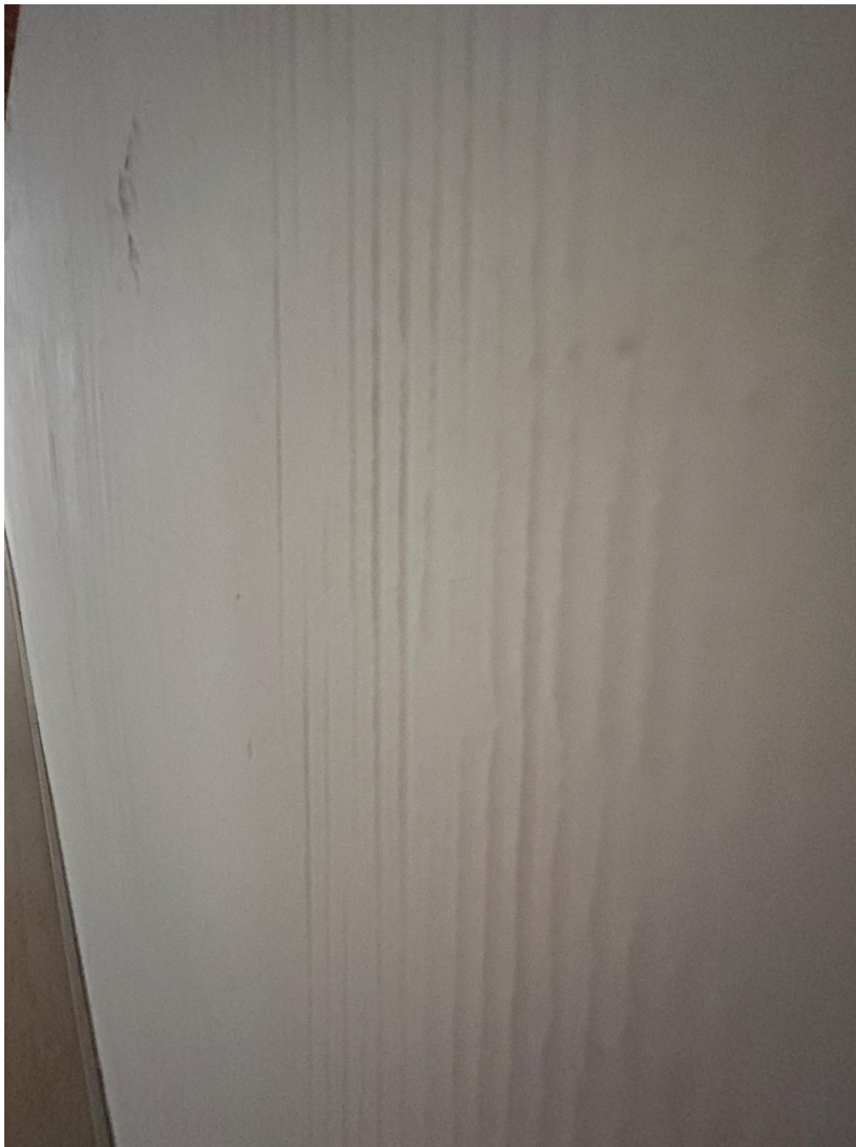
Wadliwie wykonana gładź gipsowa.
