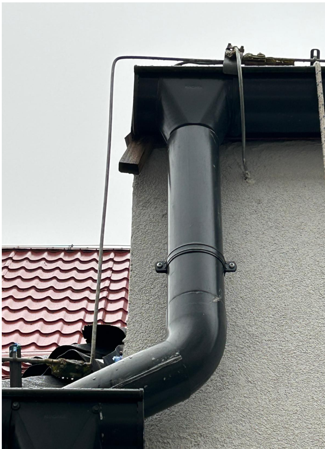
Braki w wykończeniu pokrycia, tymczasowy element mocujący.
