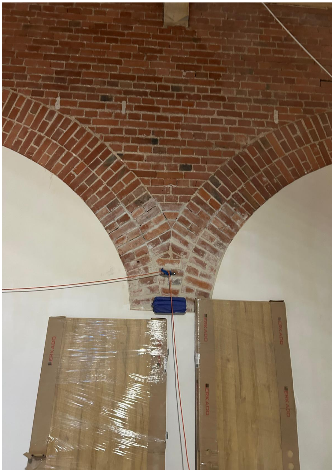
Widoczne ubytki w ścianie z cegły pełnej oraz niedokończone oczyszczenie odsłoniętych cegieł, brak estetyki.
