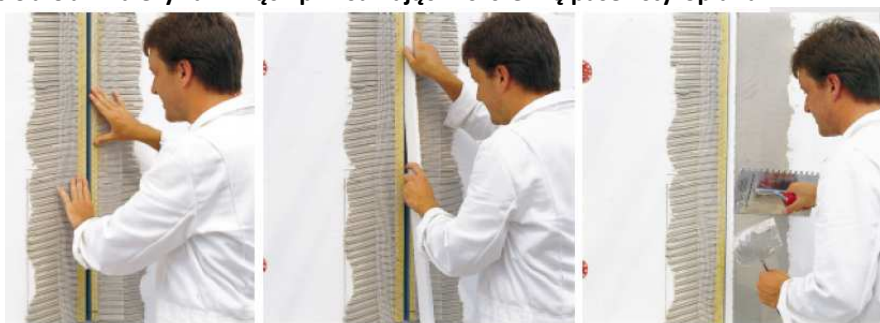
Rys. 29. Schemat układania profilu dylatacyjnego
