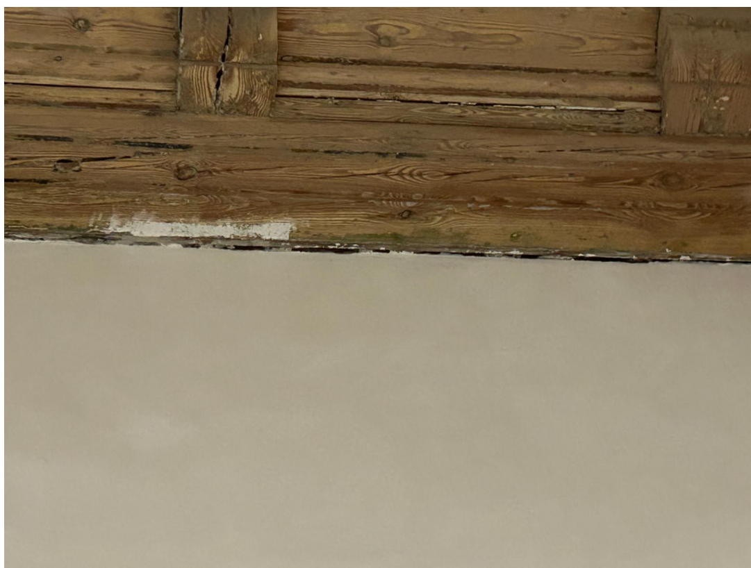
Widoczne szpary w miejscu styku ściany i drewnianej konstrukcji dachu, brak estetyki wykończenia.
