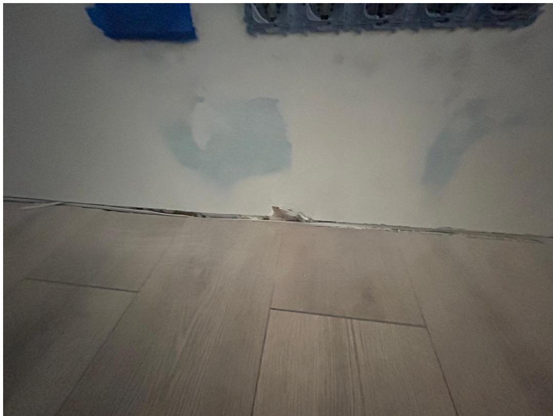
Ściany zabrudzone i z widocznymi niedoróbkami/uszkodzeniami przy posadzce.
