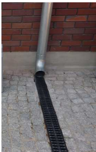
Zdj.1. Schemat odprowadzenia wody opadowej przez chodnik
