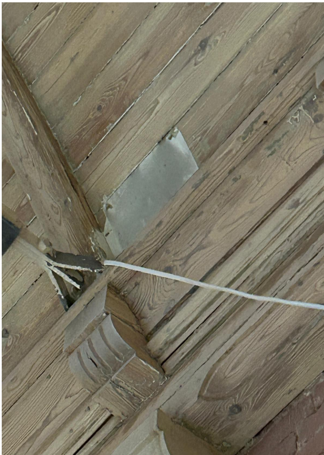
Pozostawione nieestetyczne detale sufitu drewnianego. Brak impregnacji środkiem ogniochronnym.
