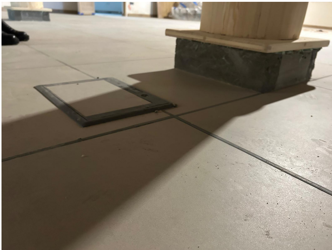
Wystające ponad płaszczyznę posadzki dylatacje oraz rewizja. Brak obróbki przy podstawach słupów.
