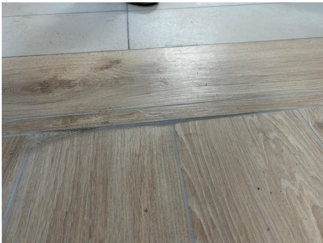
Zapadnięte płytki ceramiczne w świetle otworu drzwiowego.
