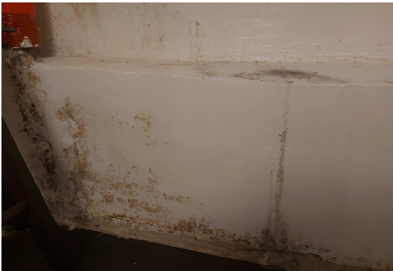
Fot.30 Pomieszczenie półpiętra schodów zejściowych do piwnicy, - widoczny początek rozwoju grzybów pleśniowych
