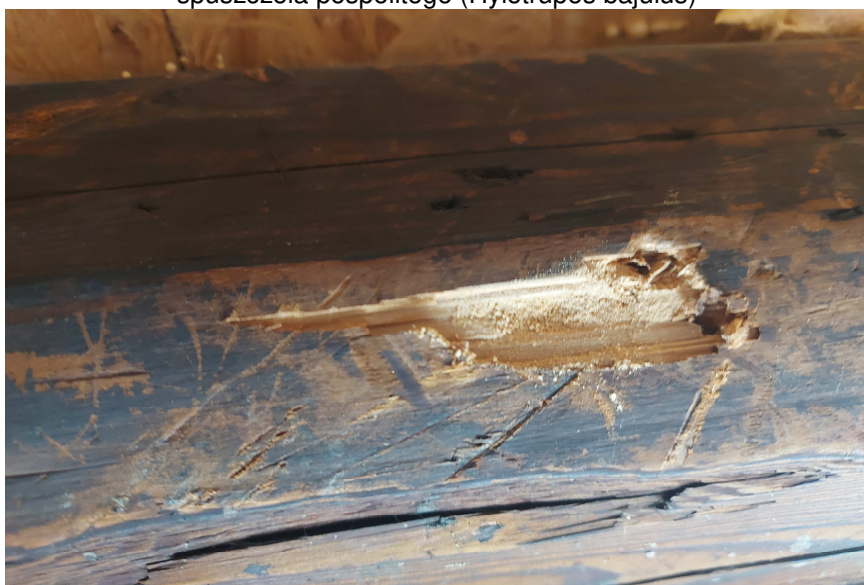
Fot.8 Strych górny widok fragmentu krokwi z wysypującą się mączką drzewną oraz korytarze spuszczała pospolitego ( Hylotrupes bajulus )
