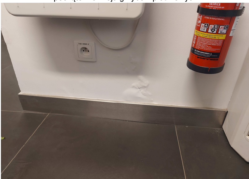
Fot.32 Pom parteru w lokalu użytkowym – widoczne odspojenia tynków , powłok malarskich na ścianach wewnętrznych
