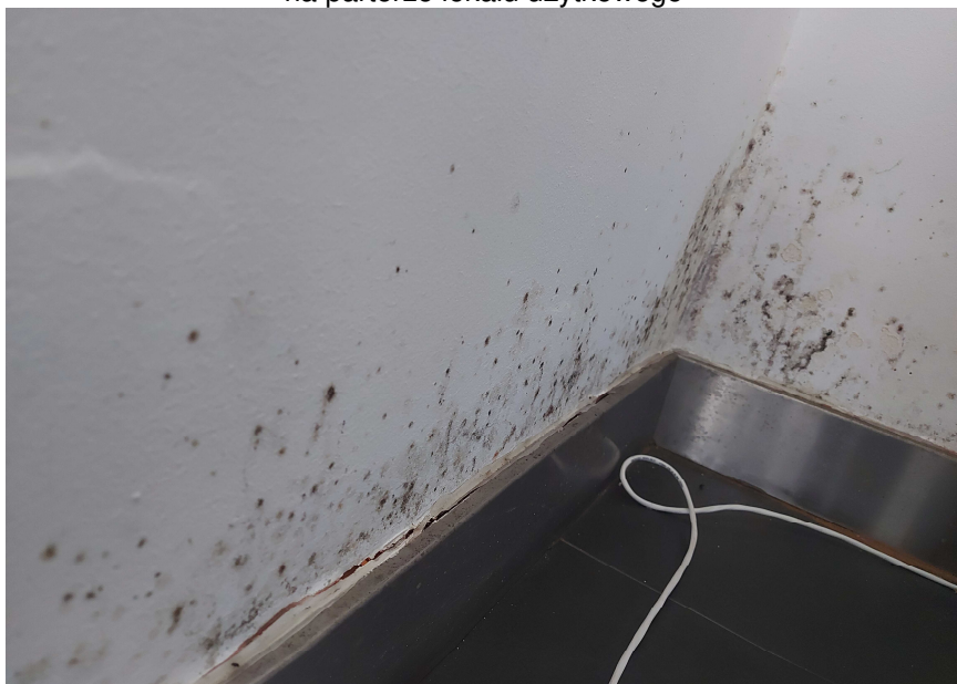
Fot.16 Widoczne liczne ślady rozwoju grzybów pleśniowych – ściana zewnętrzna na parterze lokalu użytkowego
