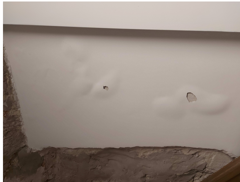
Fot.27 Ściana zewnętrzna w pom piwnicy – widoczne wykwity solne, zawilgocenia ścian, złuszczenia tynków i powłok
