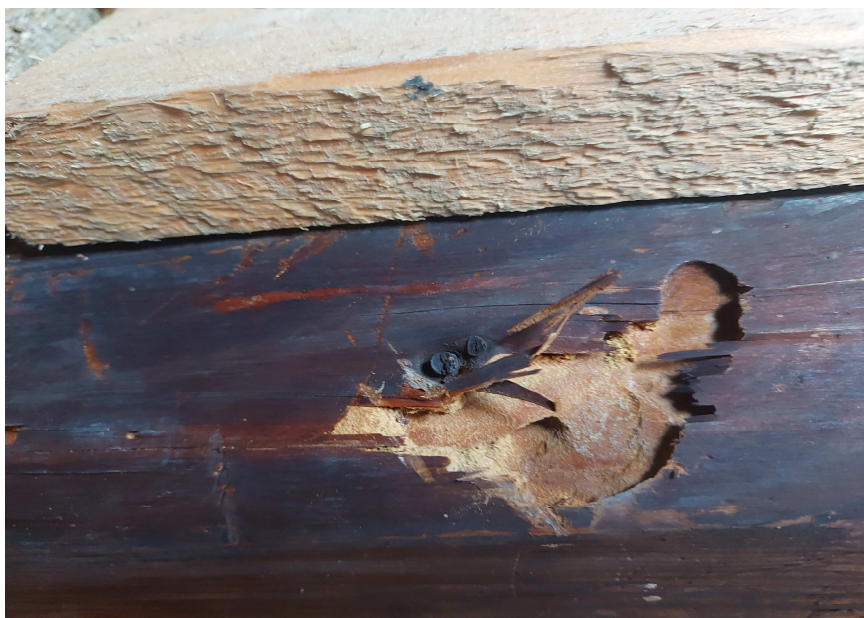
Fot.6 Strych górny widok fragmentu krokwi z wysypującą się mączką drzewną oraz korytarze spuszczała pospolitego ( Hylotrupes bajulus )
