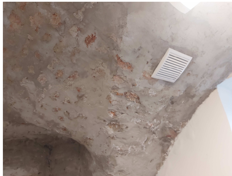
Fot.21 Widok na wykwity solne na stropie sklepieniowym w pom piwnicy
