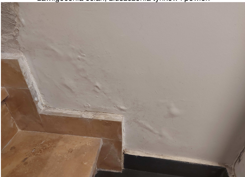
Fot.28 Schody zejściowe w piwnicy – widoczne zawilgocenia , odspajanie się tynków i powłok malarskich
