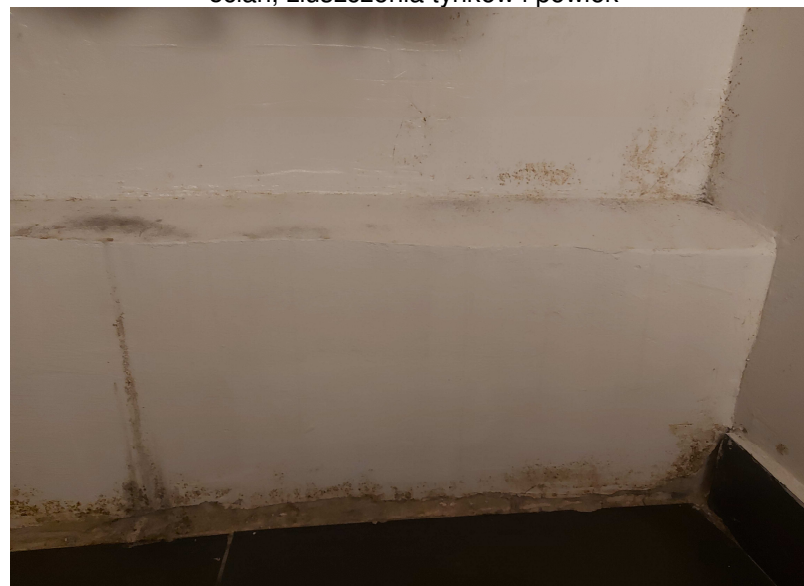
Fot.29 Pomieszczenie półpiętra schodów zejściowych do piwnicy, - widoczny początek rozwoju grzybów pleśniowych
