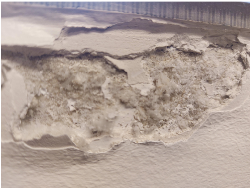
Fot.26 Ściana zewnętrzna w pom piwnicy – widoczne wykwity solne, zawilgocenia ścian, złuszczenia tynków i powłok
