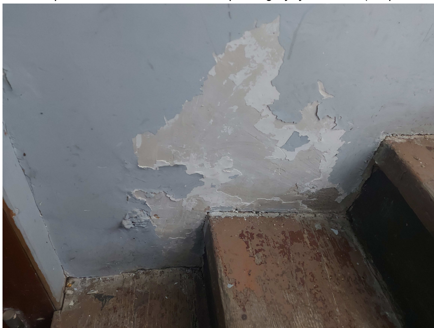
Fot.13 Zawilgocona ściana zewnętrzna klatki schodowej, złuszczenia tynków powłok malarskich
