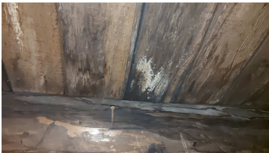
Fot.12 Lokalne porażone deskowanie dachu przez grzyby domowe ( Serpula lacrymans )
