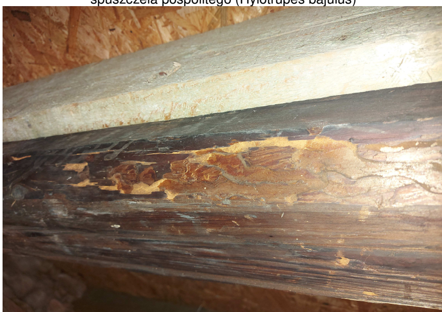
Fot.7 Strych górny widok fragmentu krokwi z wysypującą się mączką drzewną oraz korytarze spuszczała pospolitego ( Hylotrupes bajulus )
