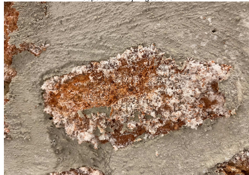
Fot.33 Wykwity solne na stropie sklepieniowym w pom piwnicznych
