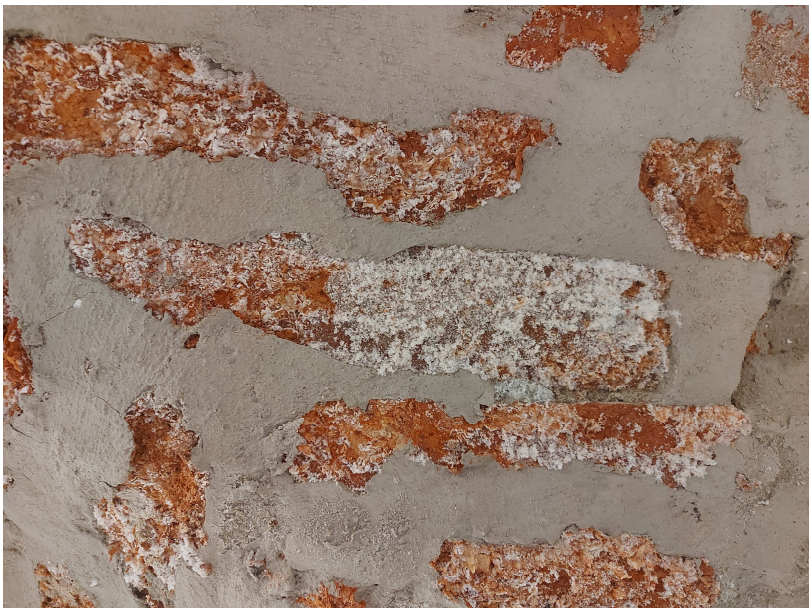
Fot.18 Wykwity solne na stropie sklepieniowym w pomieszczeniu piwnicy
