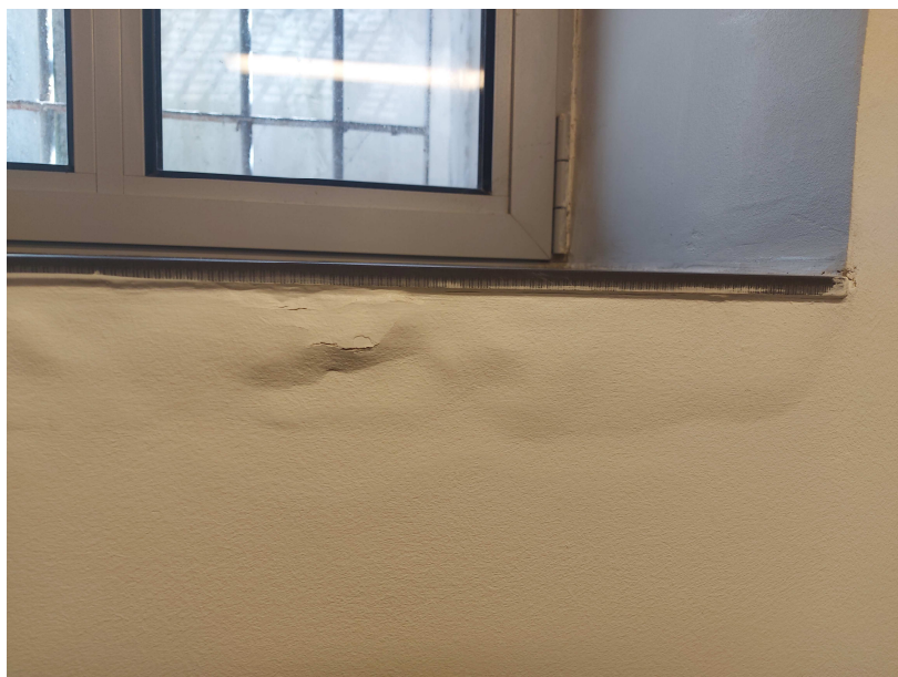
Fot.24 Ściana zewn. pom piwnicy – widoczne złuszczenia powłok malarskich, odspojenia tynków
