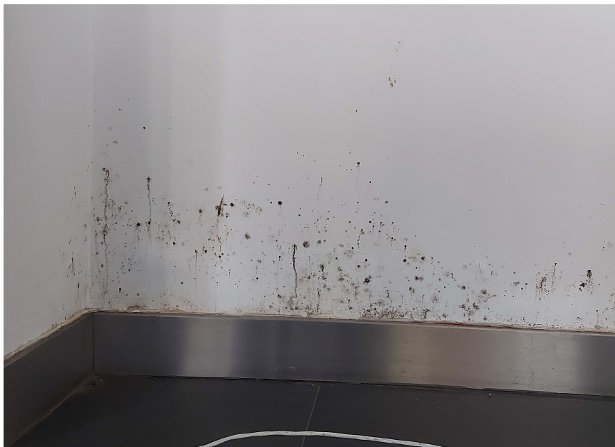
Fot.15 Widoczne liczne ślady rozwoju grzybów pleśniowych – ściana zewnętrzna na parterze lokalu użytkowego
