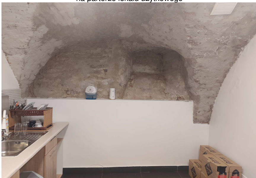
Fot.17 Pomieszczenie piwnicy w lokalu użytkowym – widoczne wysolenia i wykwyty na stropie
