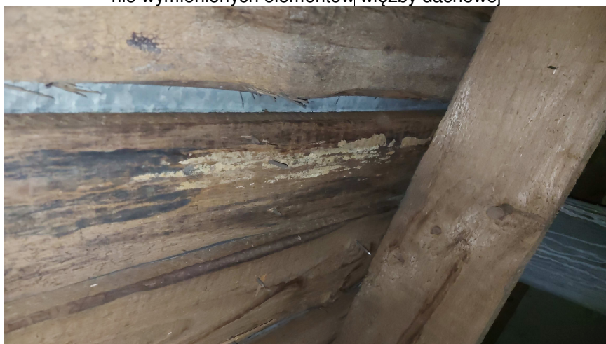
Fot.11 Lokalne porażone deskowanie dachu przez grzyby domowe ( Serpula lacrymans )
