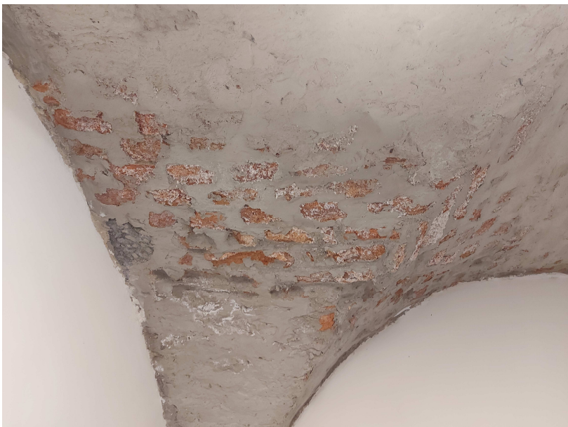
Fot.20 Widok na wykwity solne na stropie sklepieniowym w pom piwnicy
