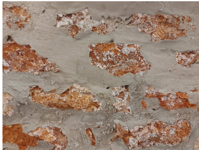
Fot.19 Wykwity solne na stropie sklepieniowym w pomieszczeniu piwnicy.
