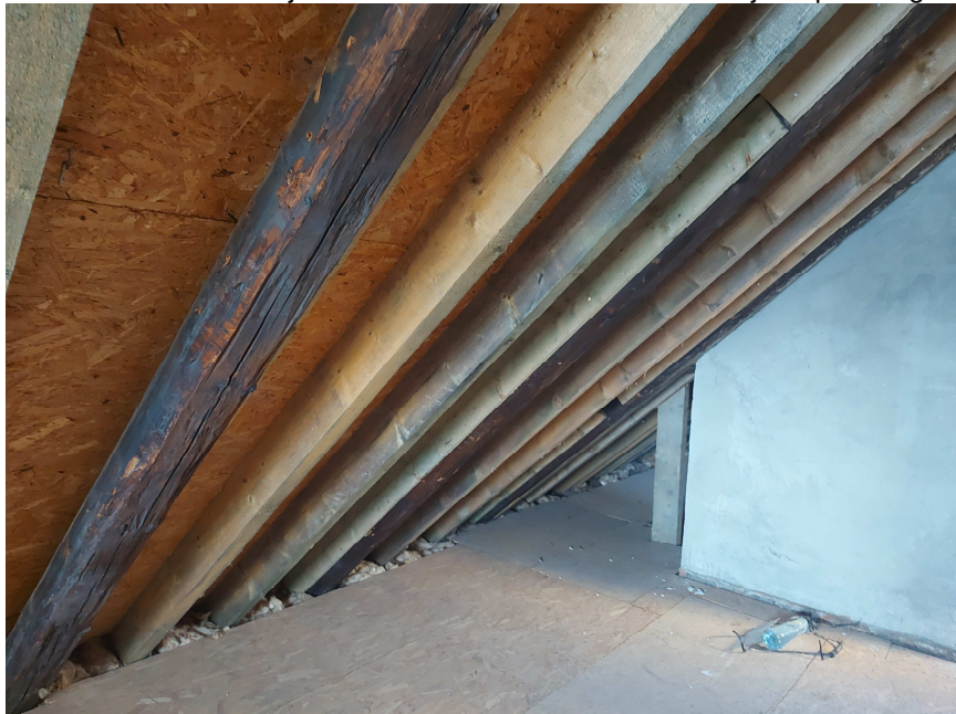
Fot.5 Strych górny – widok na niewymienione elementy krokwi zaatakowane przez owady
