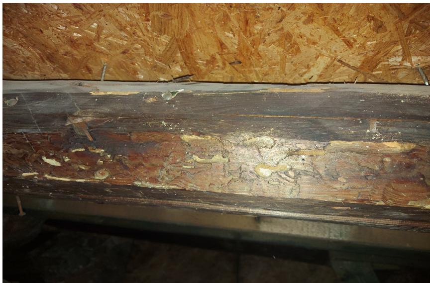
Fot.9 Widoczne korytarze i wysypująca się mączka drzewna z starych nie wymienionych elementów więźby dachowej
