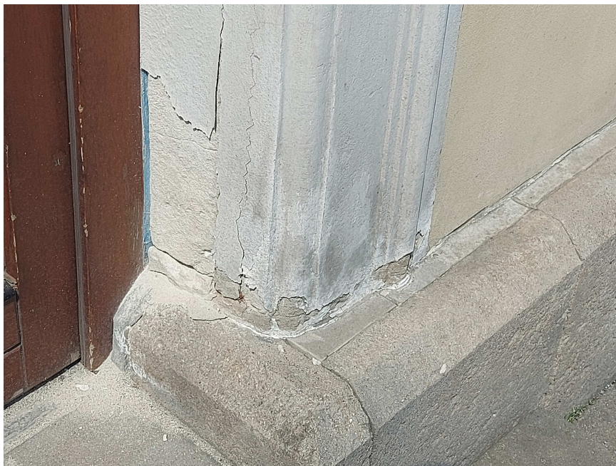
Fot.3 Widoczne odspojenia tynków i wysolenia przy wejściu do lokalu użytkowego
