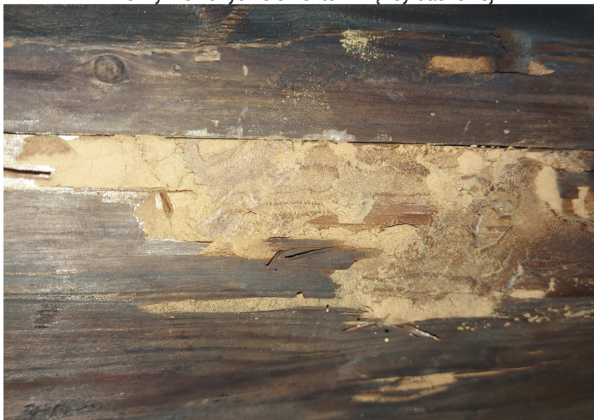
Fot.10 Widoczne korytarze i wysypująca się mączka drzewna z starych nie wymienionych elementów więźby dachowej
