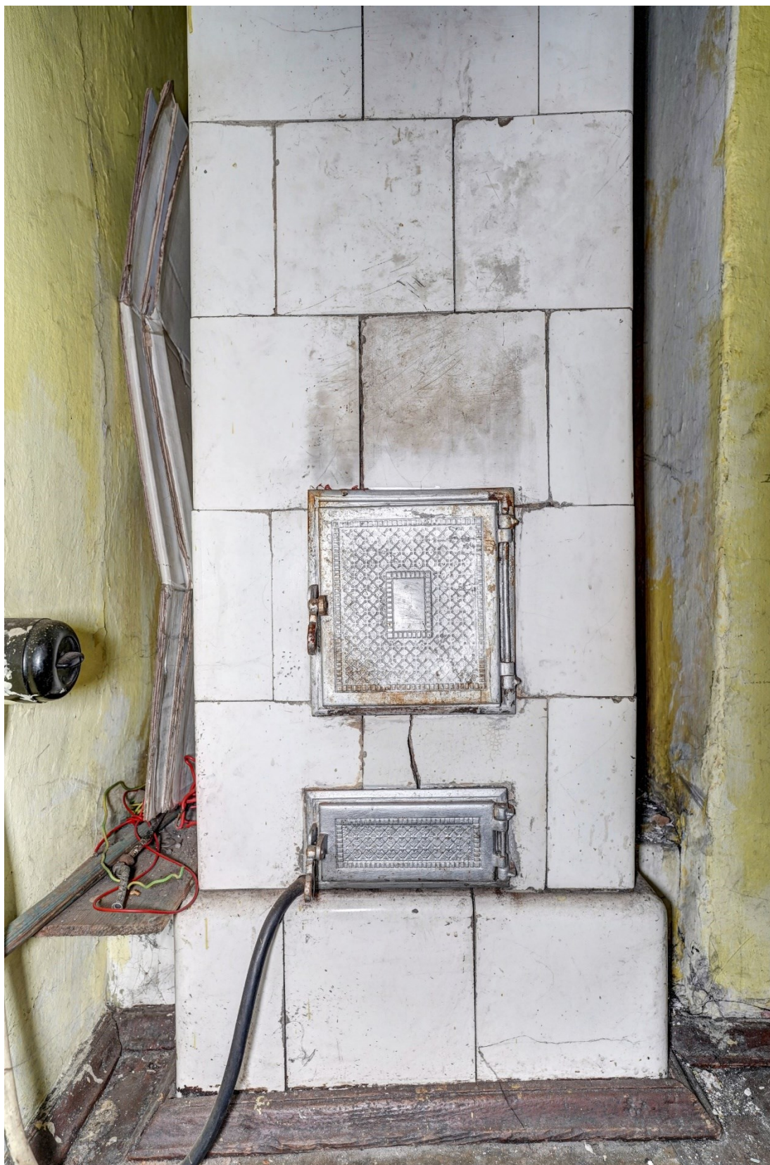
Fot. 61. Przykład zachowanych drzwiczek pieca, Fot. Anna Łopuska, 2023
