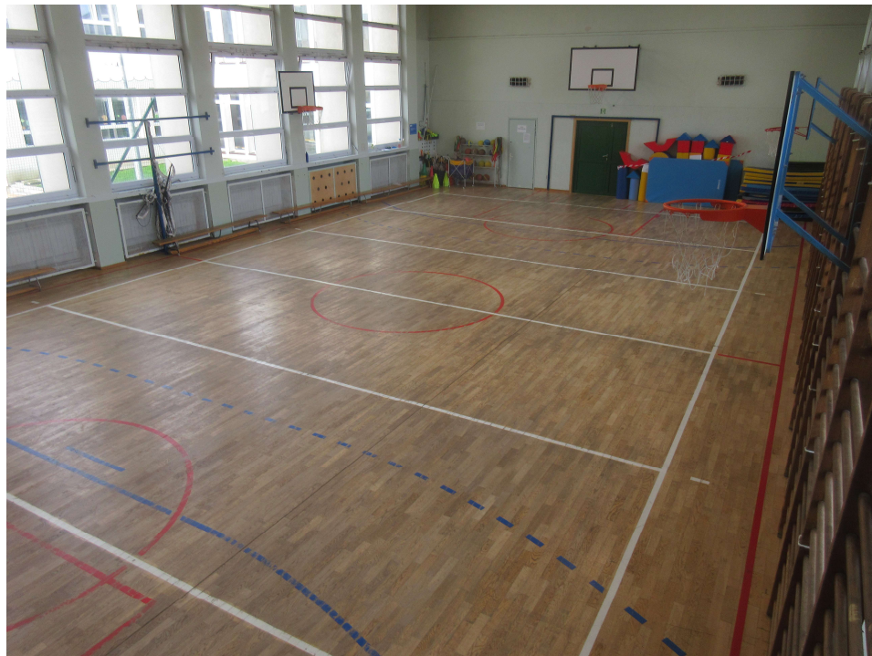
Fot. 1 – zniszczony parkiet – widoczne wybrzuszenie i pęknięcie biegnące wzdłuż Sali.
