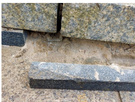
Zdj.27 Schody SCH.3 – luźne elementy podstopnic
