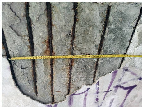
Zdj.11 Wejście główne SCH.1 – odsłonięte zbrojenie
