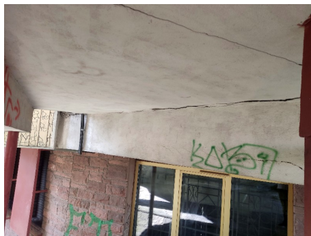
Zdj.9 Wejście główne SCH.1 – płyta schodowa, łączenie z budynkiem
