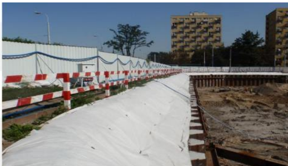
Rys. 14. Zaleca się stosowanie zabezpieczanie powierzchniowe skarpy za pomocą folii lub geowłókniny
