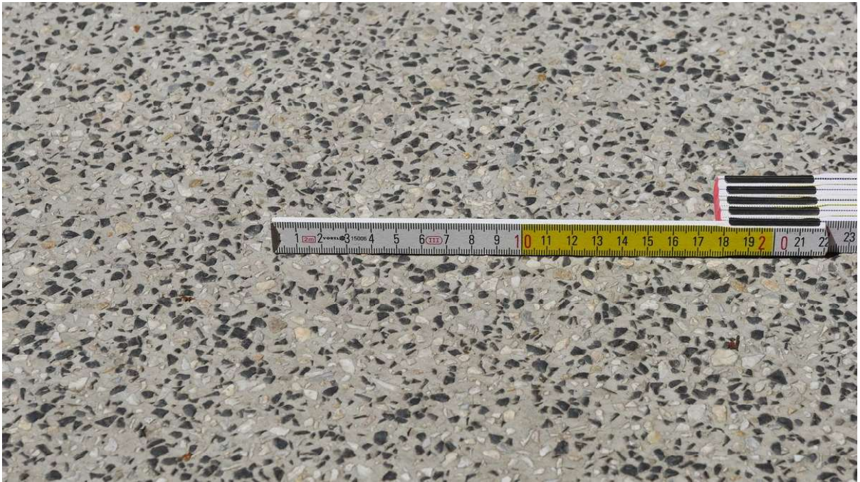
Istniejąca nawierzchnia lastrykowa na tarasie i schodach zewnętrznych od strony Alei Dygasińskiego
