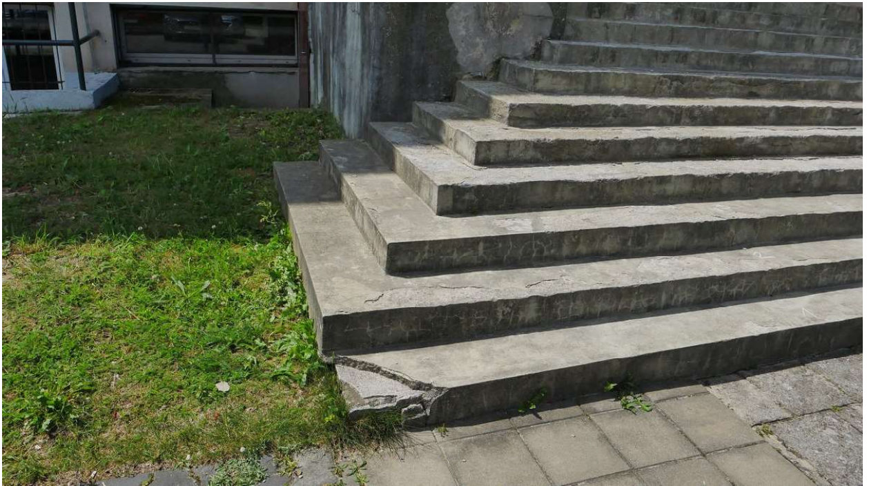
Uszkodzenie skrajnej części pierwszego stopnia
