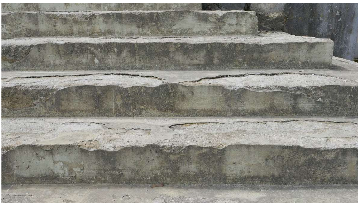
Przykład licznych braków cementowej okładziny schodów grubości ok. 1 cm
