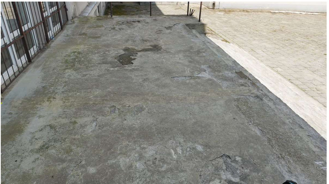
Uszkodzenia nawierzchni tarasu – ciemne plamy oznaczają stojącą w zagłębieniach (w ubytkach nawierzchni) wodę opadową
