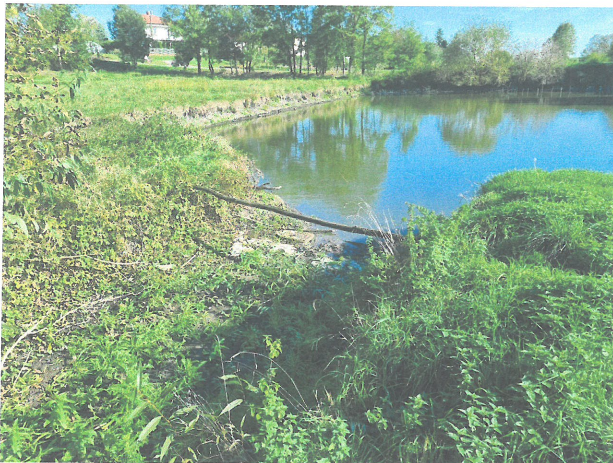
Zdj. 4: Rów doprowadzający wodę do zbiornika, wyerodowane skarpy, brak kładki lub przepustu na ujściu rowu uniemożliwia komunikację pieszą wokół zbiornika
