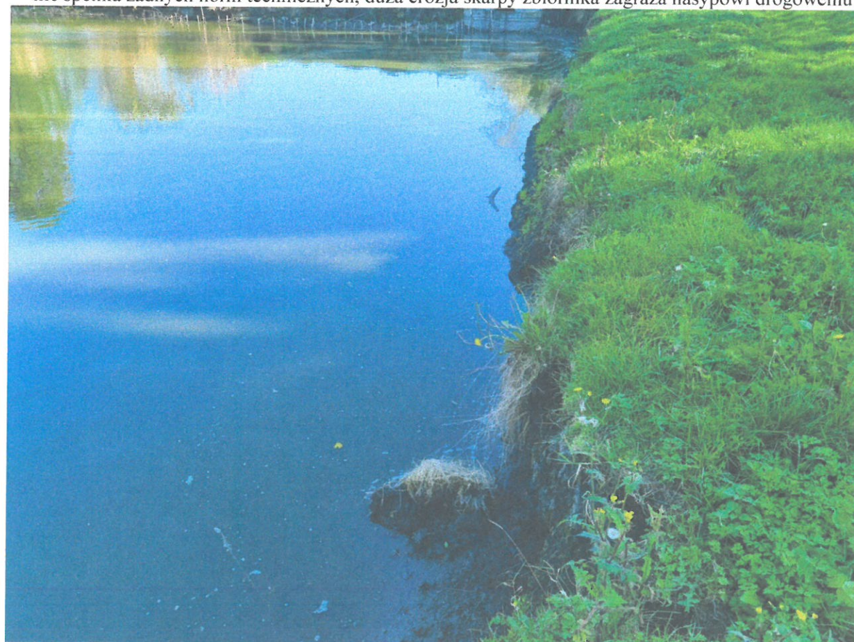
Zdj. 3: Duża erozja skarp odwodnych zbiornika praktycznie na całym jego obwodzie
