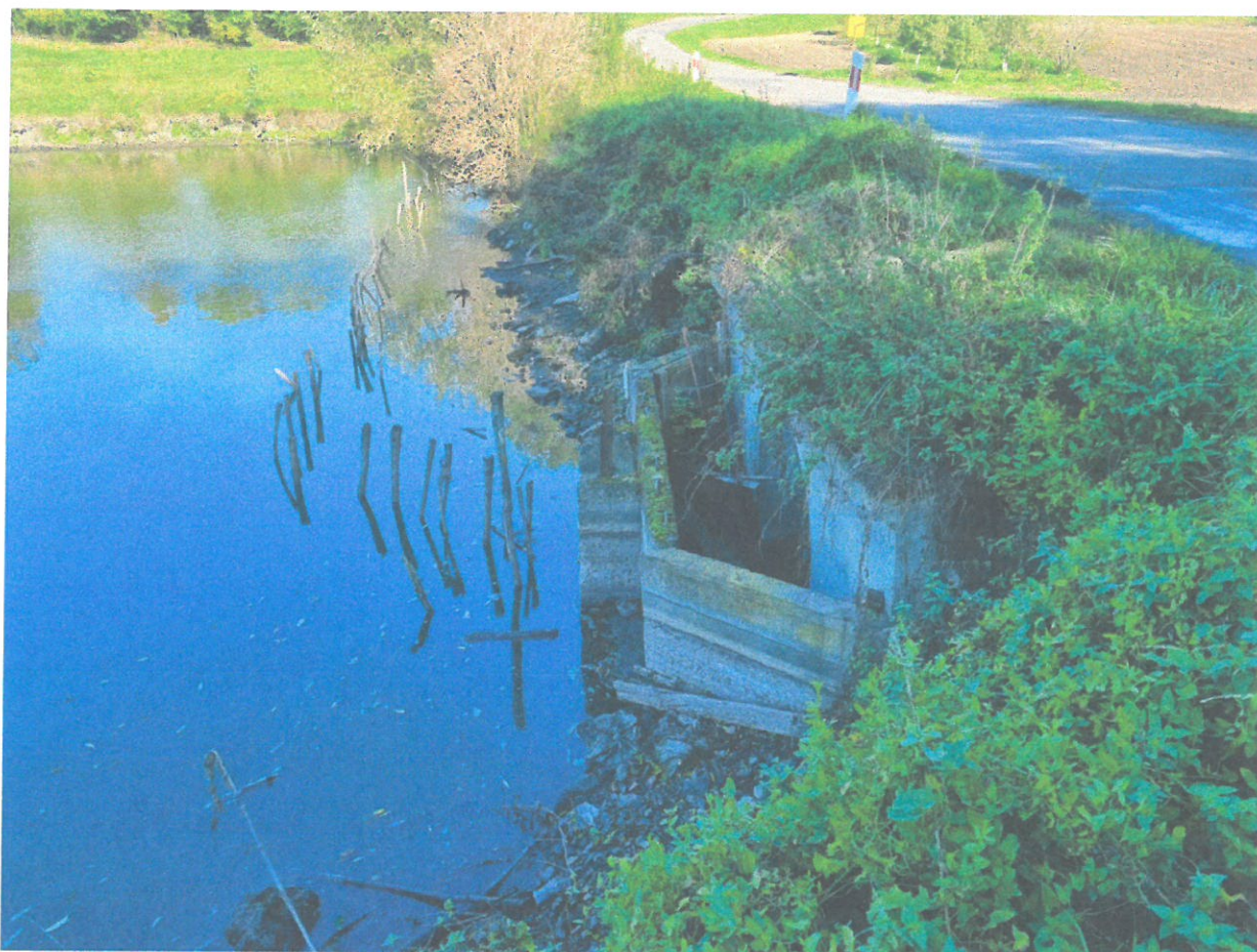
Zdj. 2: Budowla do regulacji poziomu wody wykonana bezpośrednio przed przepustem drogowym nie spełnia żadnych norm technicznych, duża erozja skarpy zbiornika zagraża nasypowi drogowemu
