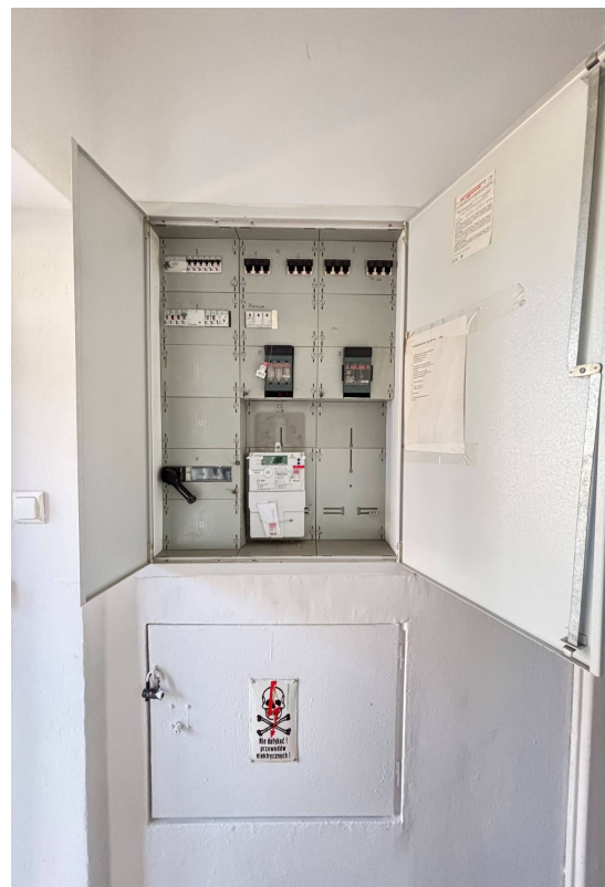
Zdjęcie 7 – rozdzielnia elektryczna
