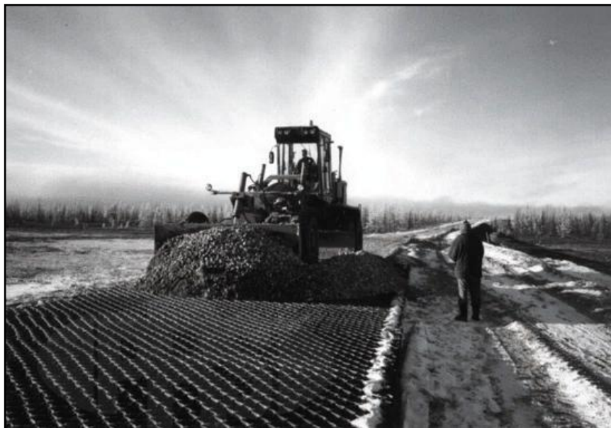
Rys. 8. Zasypywanie kruszywem komórek geokraty za pomocą ładowarki
