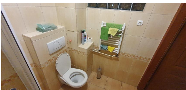
Zdjęcie nr 14. Pomieszczenie nr B11b łazienka – zabudowany stelaż WC, szacht instalacyjny oraz istniejący grzejnik drabinkowy pod naświetlem z luksferów.
