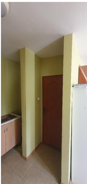
Zdjęcie nr 10. Drzwi płycinowe 60/186 z ościeżnicą typu MDF prowadzące do pom. łazienki pomiędzy ściankami.
