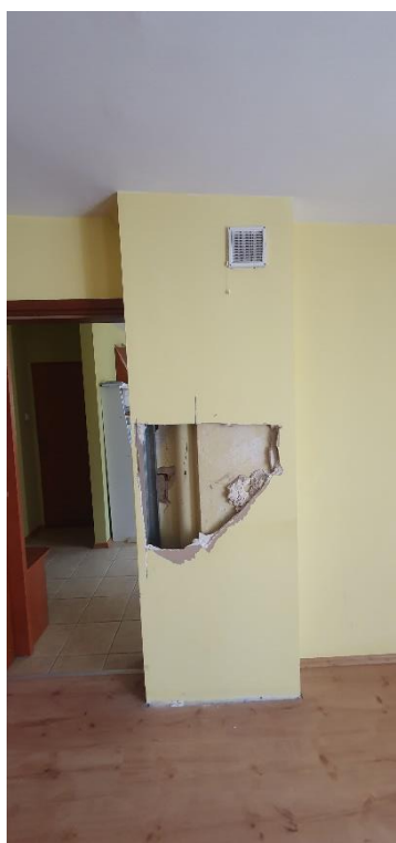
Zdjęcie nr 17. Pom. nr B11c Pokój – widok suchej zabudowy komina wentylacyjnego i pionu kanalizacji.
