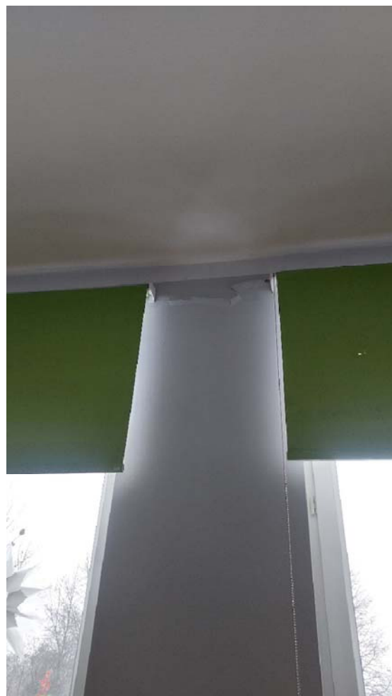
Rys. 7.7 Pęknięcie filarka między okiennego.
