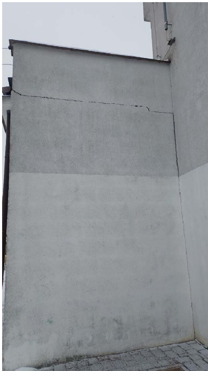
Rys. 7.11 Poziome pęknięcie ściany budynku.
