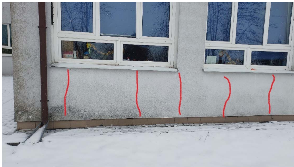
Rys. 7.8 Widoczne zarysowania w strefie podokiennej.
