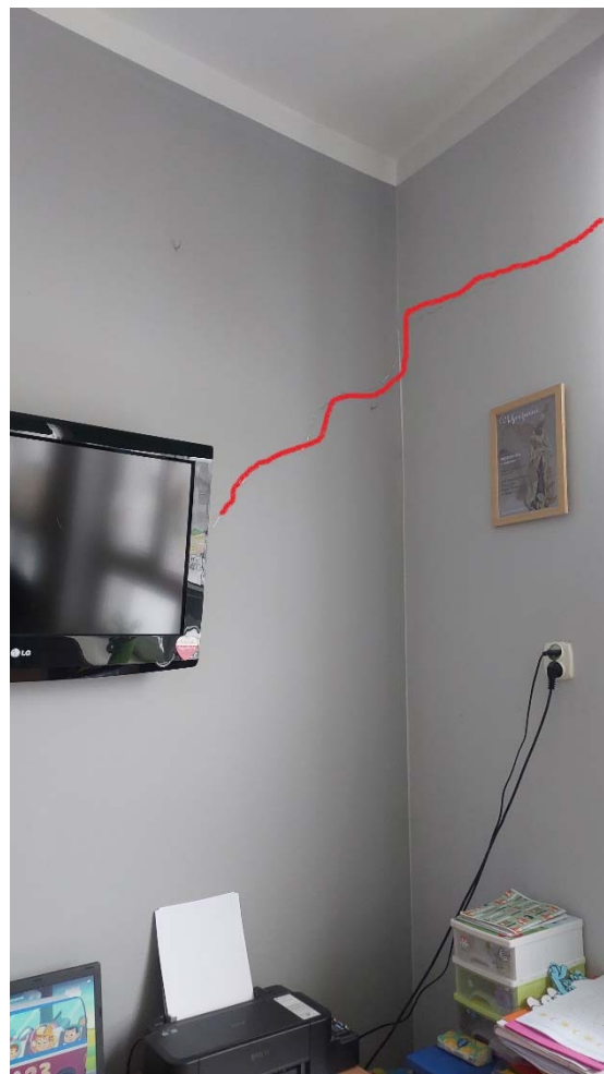
Rys. 7.3 Widoczne zarysowanie południowo-zachodniego naroża budynku.
