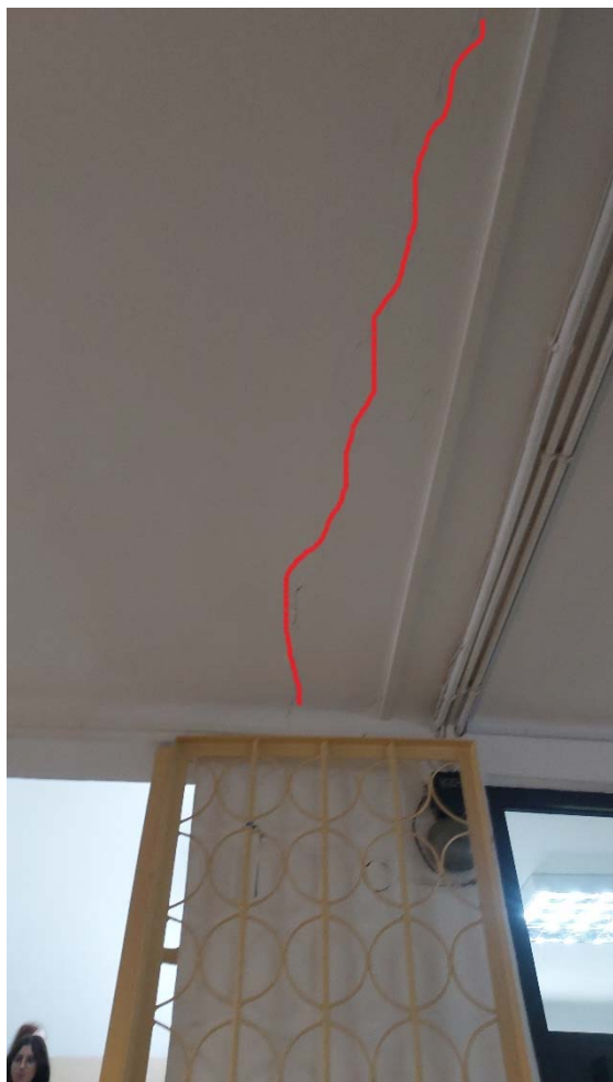
Rys. 7.6 Widoczne zarysowanie na stropie.
