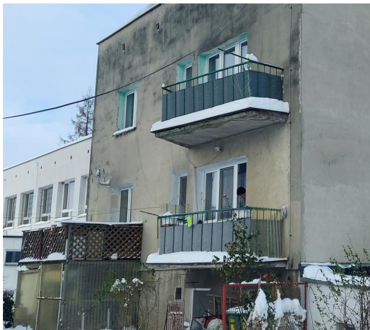
Rys. 4 Widoczne uszkodzenia żelbetowych płyt balkonowych.
