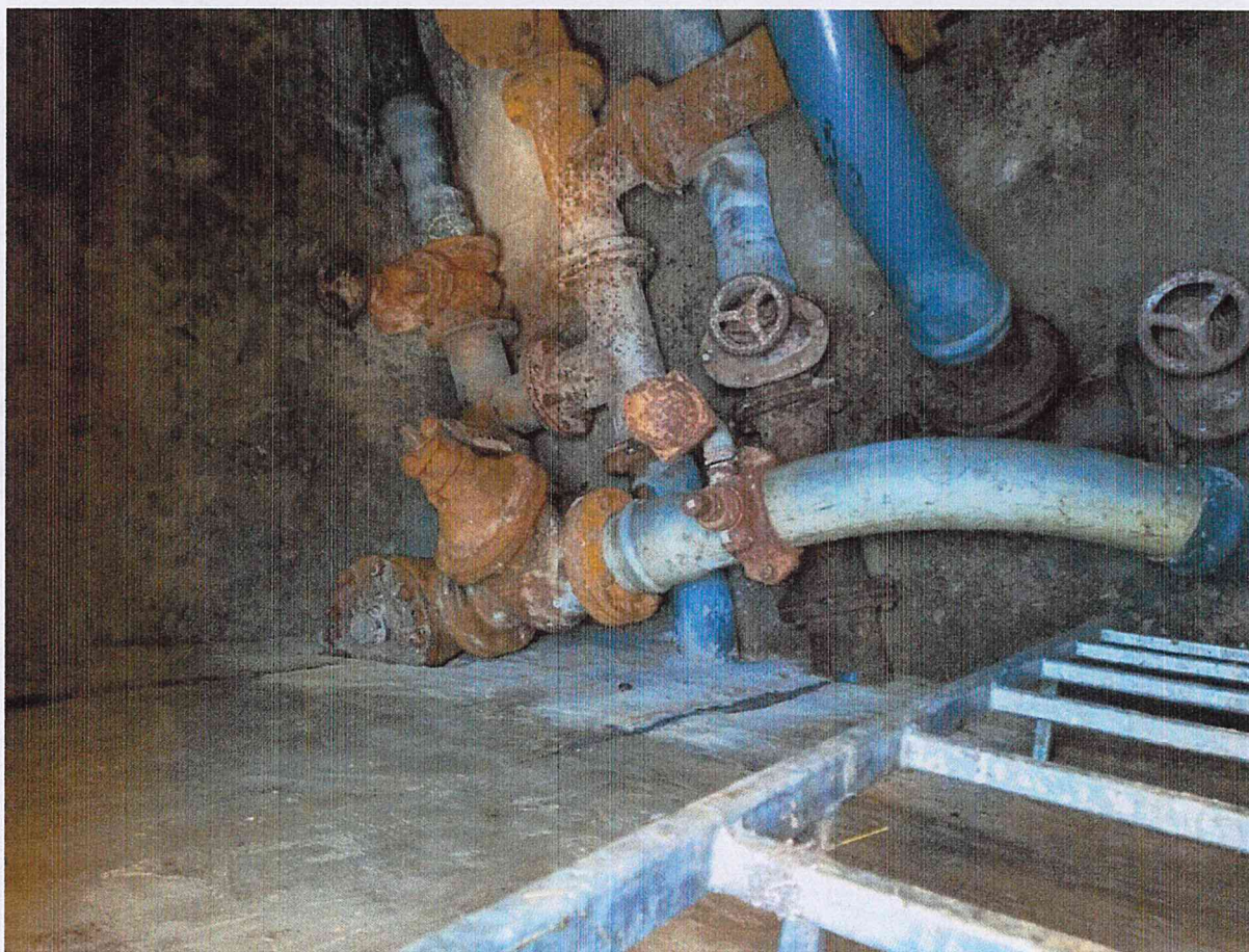
Komora zasuw przy zbiornikach żelbetowych 2*V-150 m 3 - DO WYMIANY
