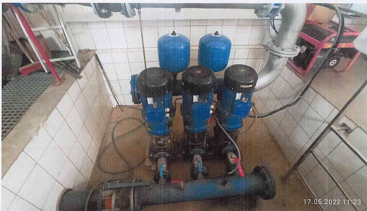
SUW Agregat pompowy –dostawienie jednej pompy
