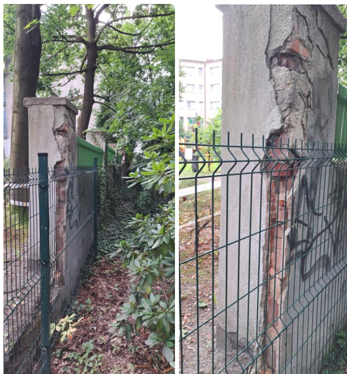
Zdjęcie nr 6. Tymczasowe ogrodzenie panelowe w miejscu rozebranego ogrodzenia stwarzającego zagrożenie
