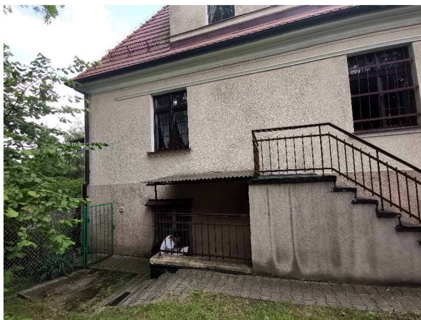
Fot. 7 – Elewacja budynku– zawilgocenia
