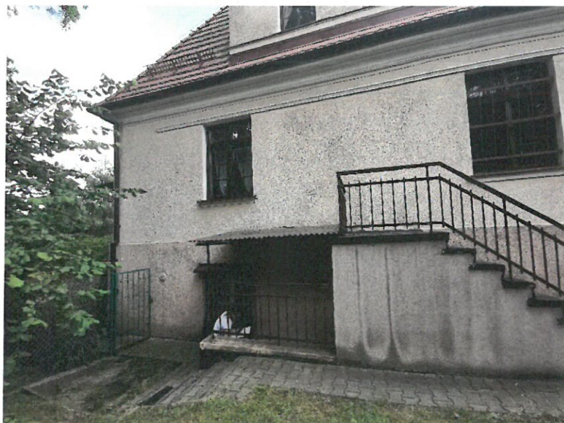
Fot. 7 – Elewacja budynku– zawilgocenia
