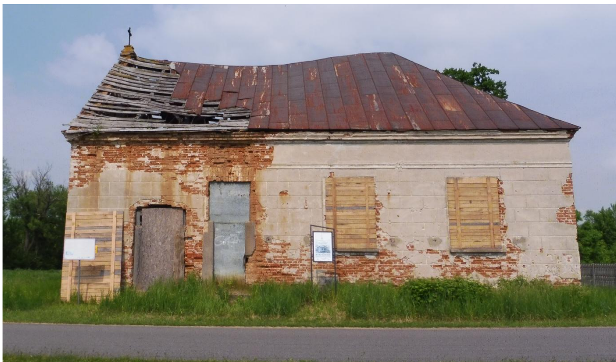
Fot. nr 13, Uszkodzona konstrukcja dachowa i pokrycie dachu, elewacja południowa, czerwiec 2023 r.
