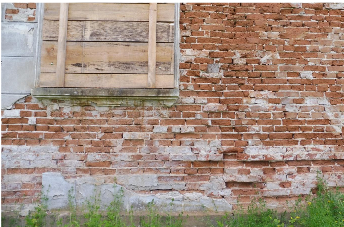
Fot. nr 9 , fragment elewacji północnej, widoczne odsłonięte i zdekonstruowane wązki ceglane, oraz pęknięcia ścian na prawo od otworu okiennego, czerwiec 2023 r.
