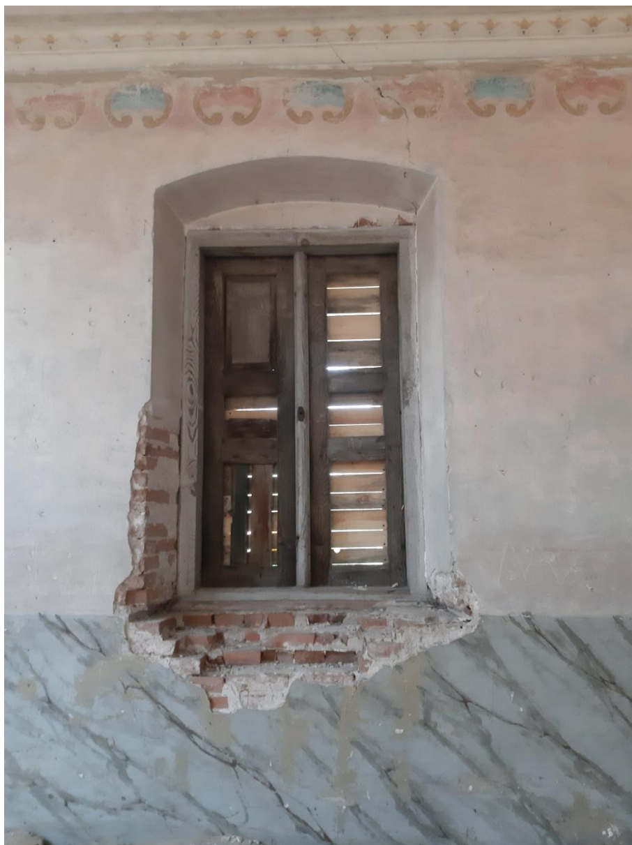
Fot. nr 22 , zachowana stolarka okienna otworu okiennego, ściana wschodnia, czerwiec 2023 r.
