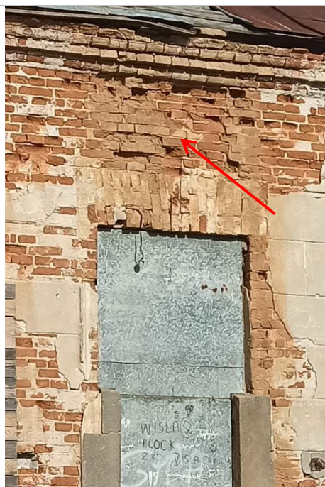
Rysunek 14 Zaawansowana korozja cegły elewacji
