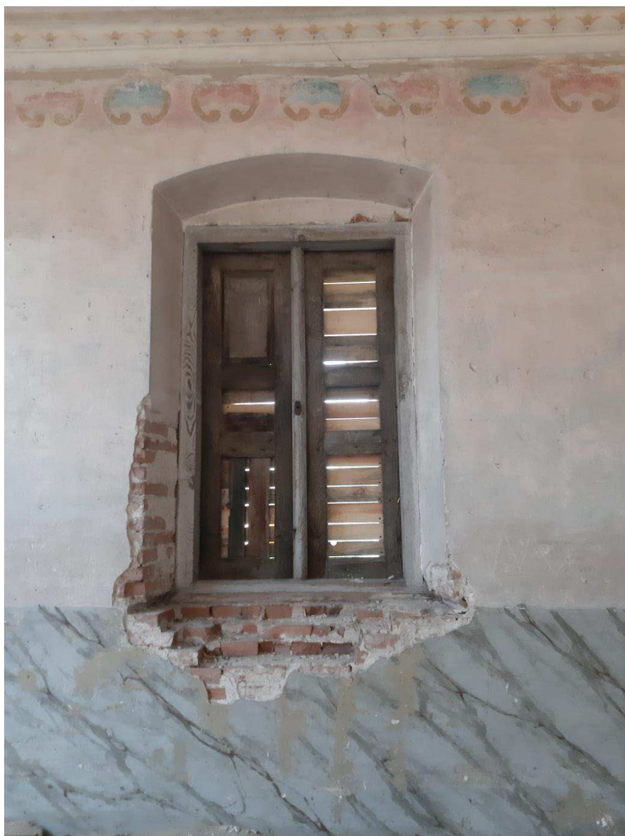
Fot. nr 22. Zachowana stolarka okienna otworu okiennego, ściana wschodnia, lipiec 2023 r
