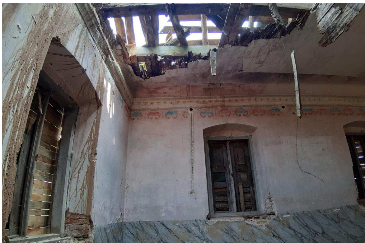
Fot. nr 18. Fragment polichromii na ścianie wschodniej i brakujące fragmenty sufitu, lipiec 2023 r.
