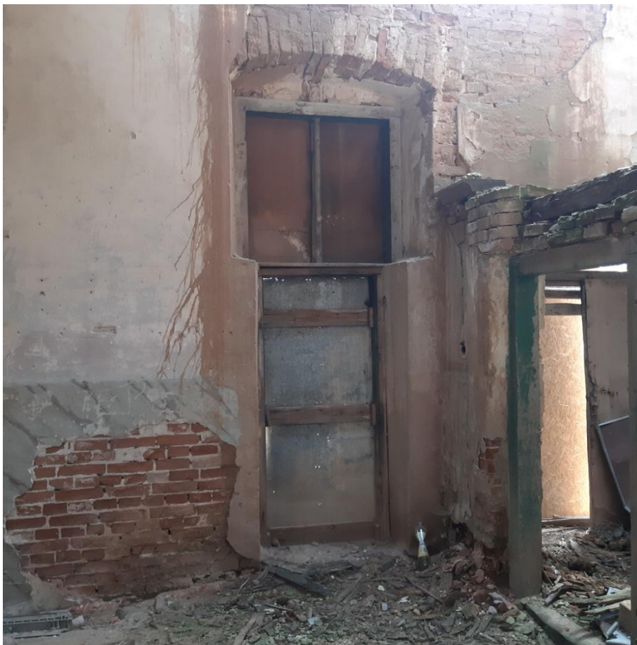
Fot. nr 19 , ściana południowa, wtórne wejście do budynku powstałe po 1945 r., czerwiec 2023 r.
