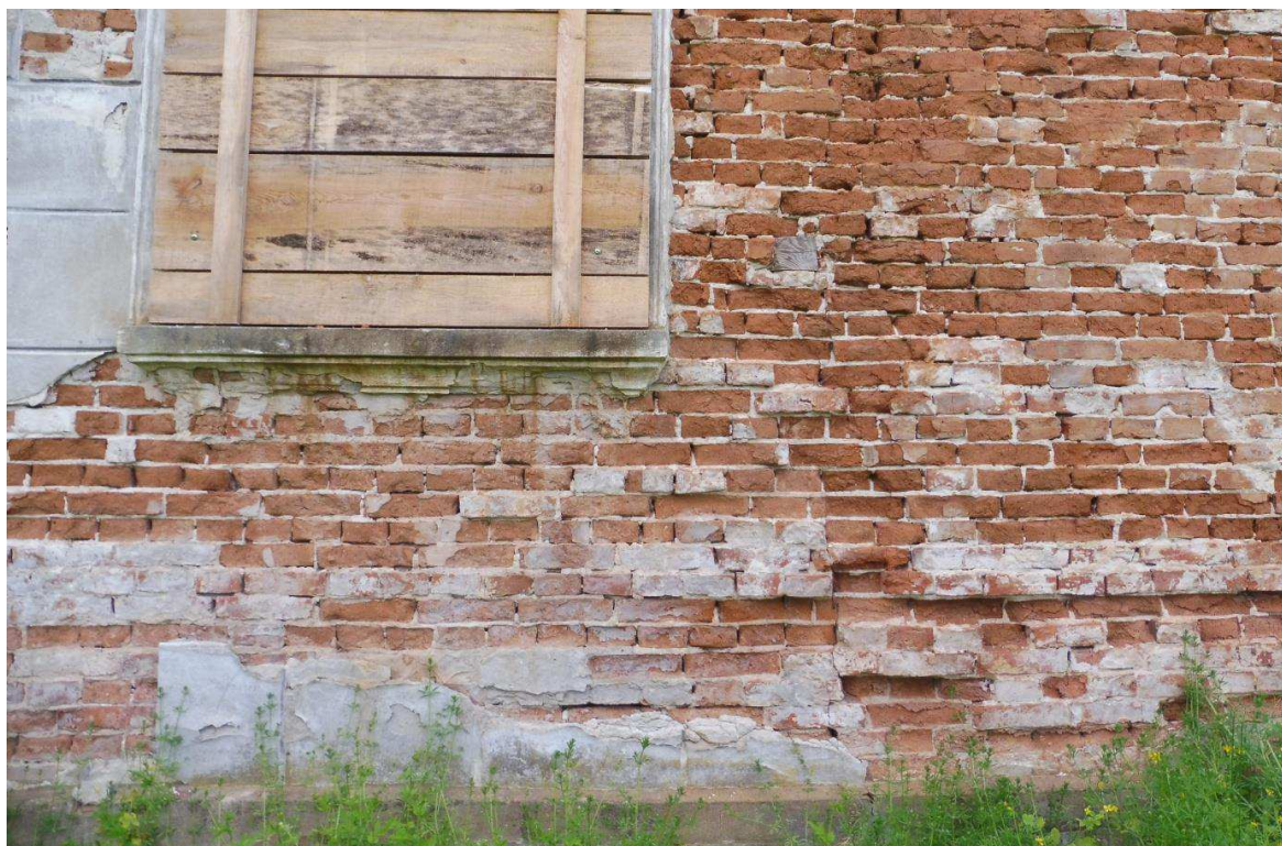
Fot. nr 9. Fragment elewacji północnej, widoczne odsłonięte i zdekonstruowane wątki ceglane, oraz pęknięcia ścian na prawo od otworu okiennego, lipiec 2023 r.
