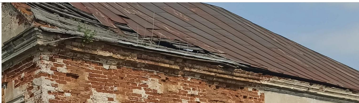
Rysunek 8 Brak orynnowania, płotków przeciwśnieżnych, ław kominiarskich
