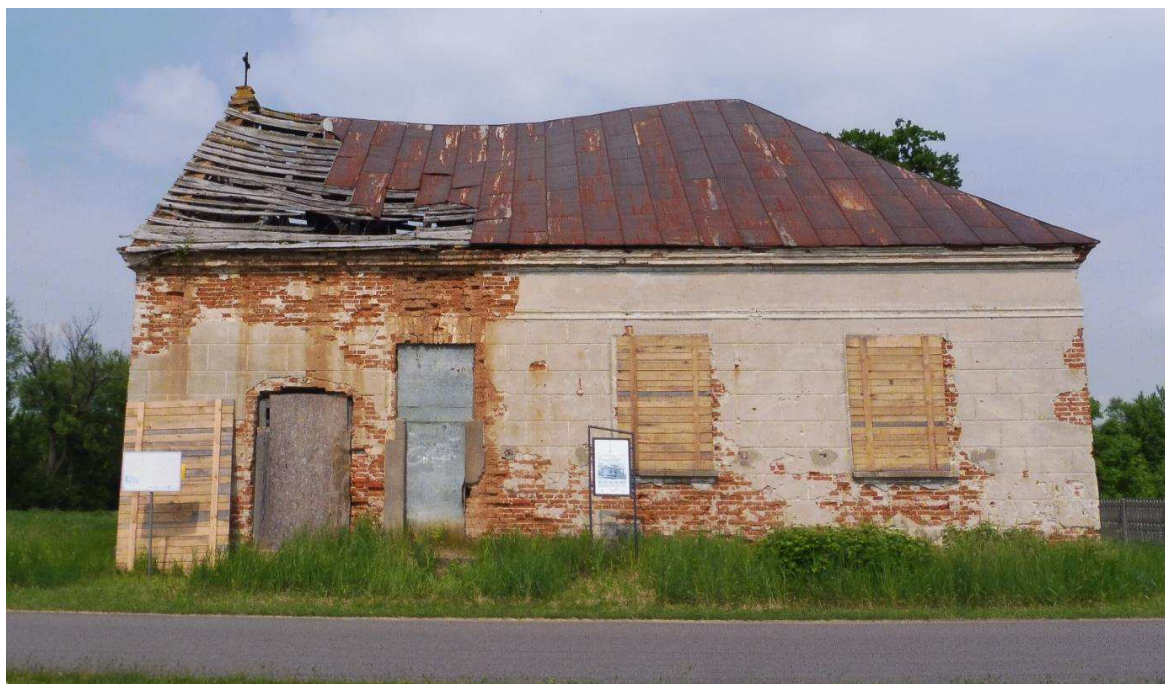
Fot. nr 13. Uszkodzona konstrukcja dachowa i pokrycie dachu, elewacja południowa, lipiec 2023 r.
