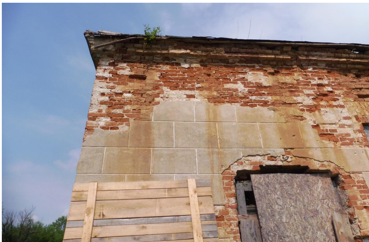
Fot. nr 14, Uszkodzony gzyms wieńczący, oraz zdekonstruowane wątki ceglane, elewacja południowa, czerwiec 2023 r.
