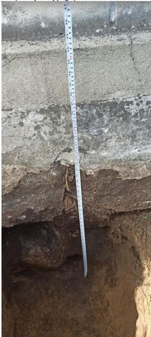
Rysunek 15 Głębokość posadowienia fundamentów
