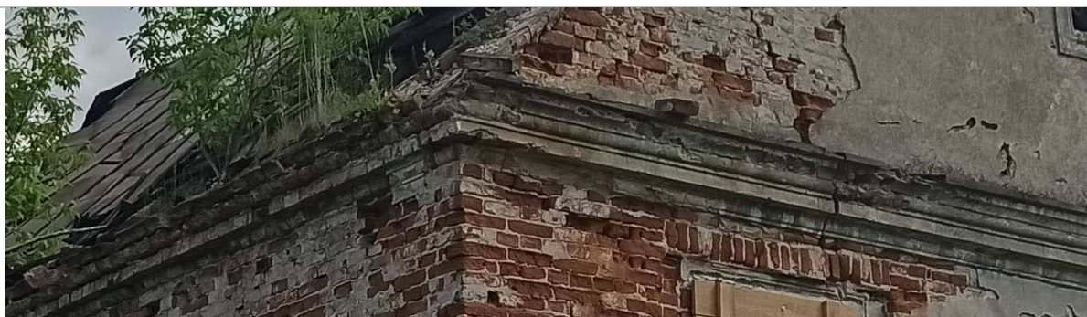
Rysunek 9 Uszkodzenie gzymsu
