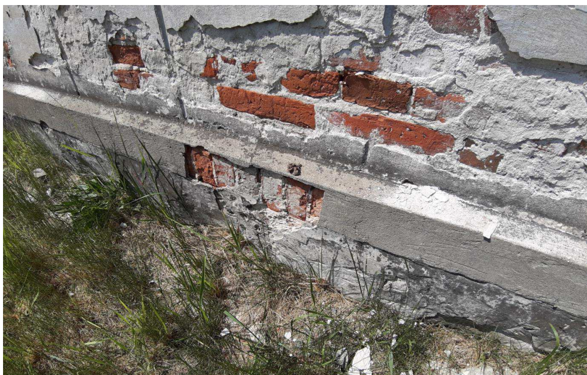
Fot. nr 10. Fragment partii przyziemia z uszkodzonym cokołem, elewacja północna, lipiec 2023 r.
