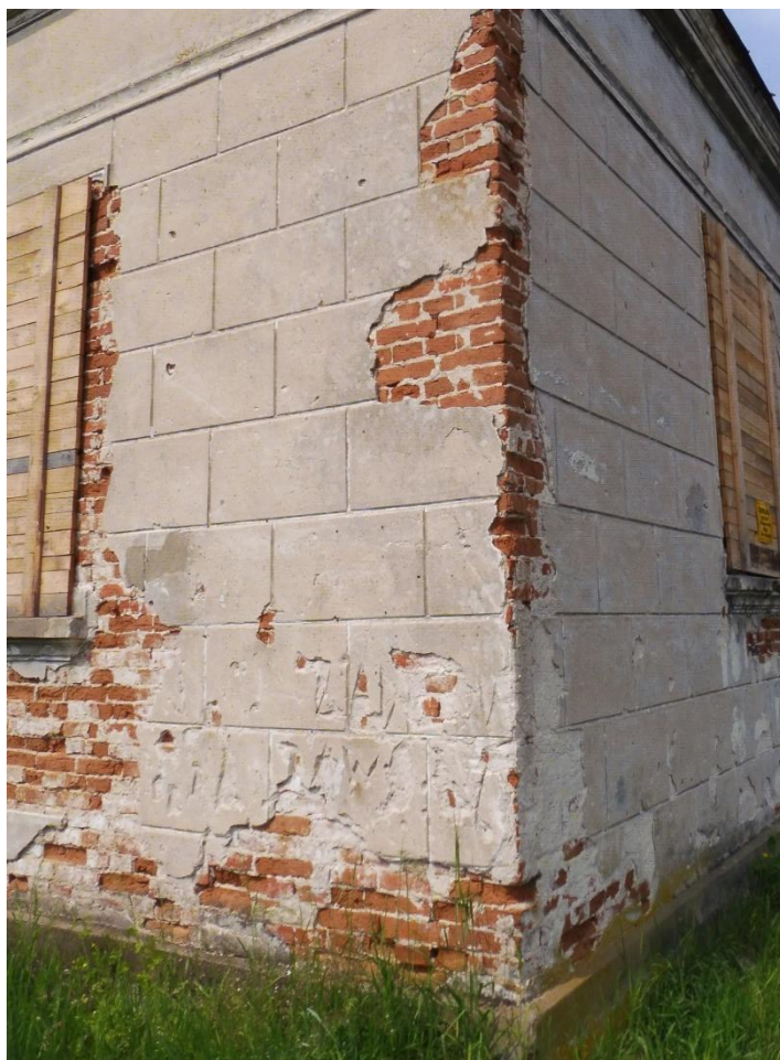
Fot. nr 12 , narożnik wschodnio-południowy, widoczne ubytki wypraw tynkarskich, czerwiec 2023 r.
