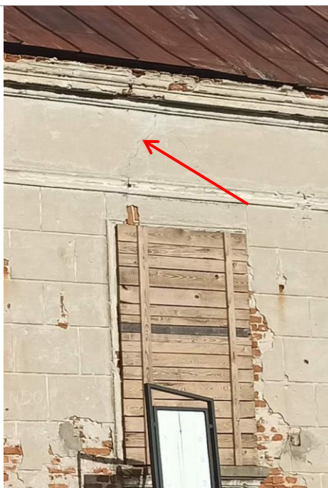
Rysunek 13 Pęknięcie muru na frontowej
