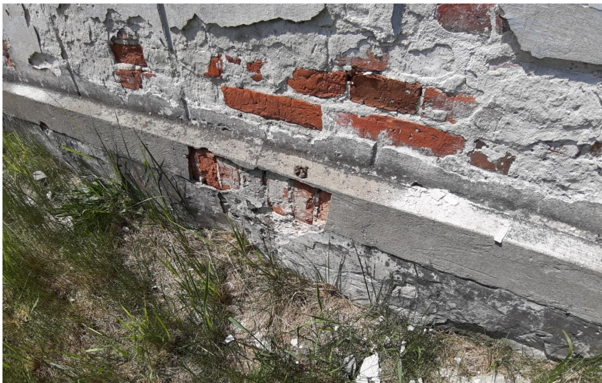
Fot. nr 10 , fragment partii przyziemia z uszkodzonym cokołem, elewacja północna, czerwiec 2023 r.
