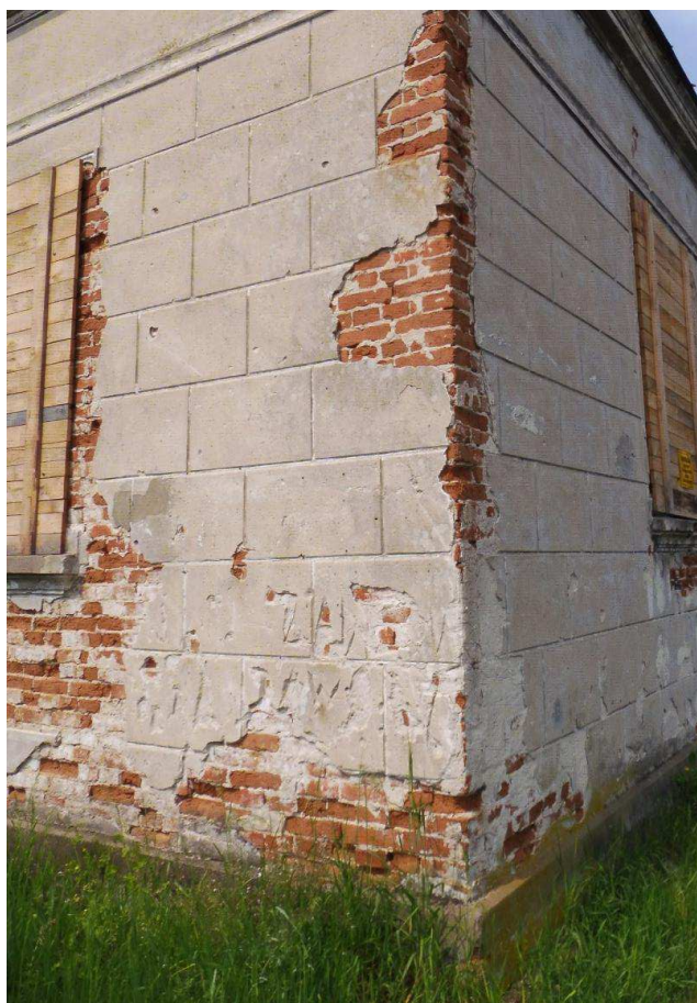
Fot. nr 12. Narożnik wschodnio-południowy, widoczne ubytki wypraw tynkarskich, lipiec 2023 r.
