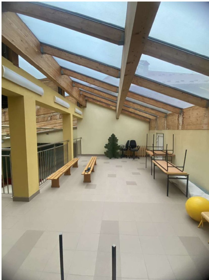
Rys. 1 Konstrukcja nośna dachu nad atrium
