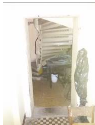
Zdjęcie nr 18. Obniżenie nad schodami do 1,73 m (zdjęcie z lewej strony), układ schodów (zdjęcie środkowe), obniżenie drogi ewakuacyjnej na poziomie przyziemia (zdjęcie z prawej strony).
