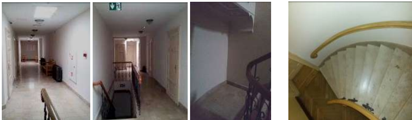
Zdjęcie nr 11. Przykładowe zdjęcia komunikacji 9: komunikacja na poddaszu (2 zdjęcia z lewej strony); spocznik międzypiętrowy schodów SW1 z obniżeniem (zdjęcie w części środkowej); schody zabiegowe o szerokości 5 cm i spocznik o szerokości 1,18 m schodów SW1 (zdjęcie z lewej strony).
