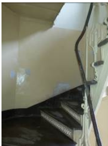
Zdjęcie nr 18. Obniżenie nad schodami do 1,73 m (zdjęcie z lewej strony), układ schodów (zdjęcie środkowe), obniżenie drogi ewakuacyjnej na poziomie przyziemia (zdjęcie z prawej strony).
