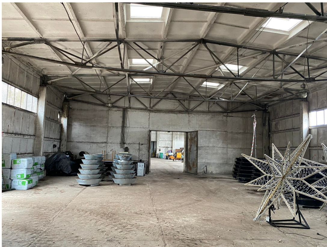
Fot. 11. Widok od środka części niskiej – ściana szczytowa z konstrukcją dachu.
