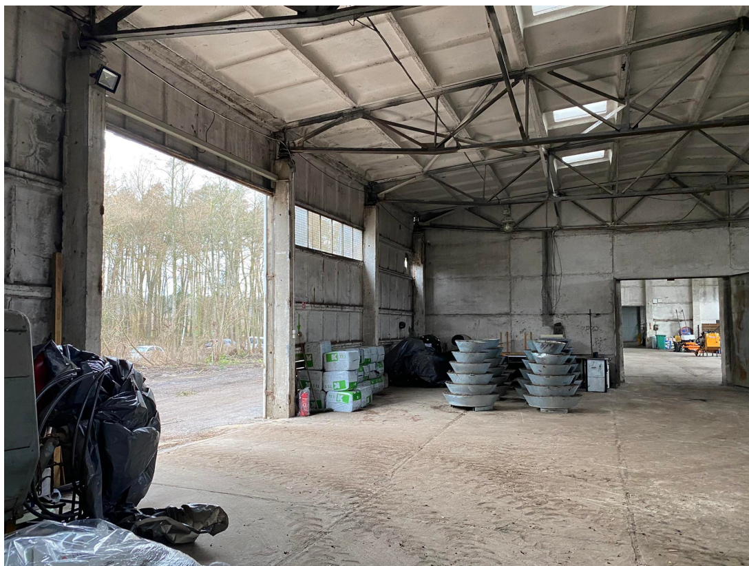
Fot. 12. Widok od środka części niskiej – ściana szczytowa i boczna z bramą oraz konstrukcją dachu.
