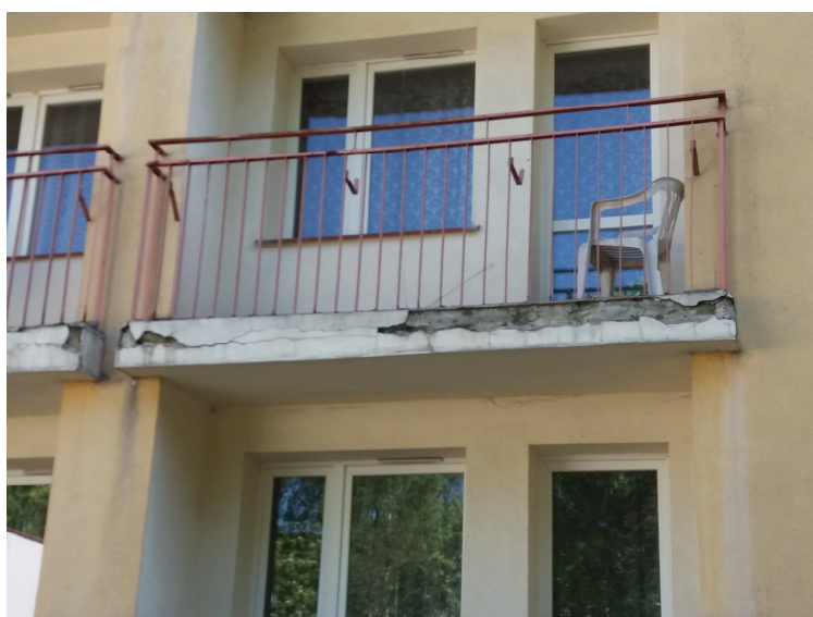
Zdjęcie nr 7: Widok brzegu płyty balkonu segmentu 'D', widoczne rozwarstwienie płyty
