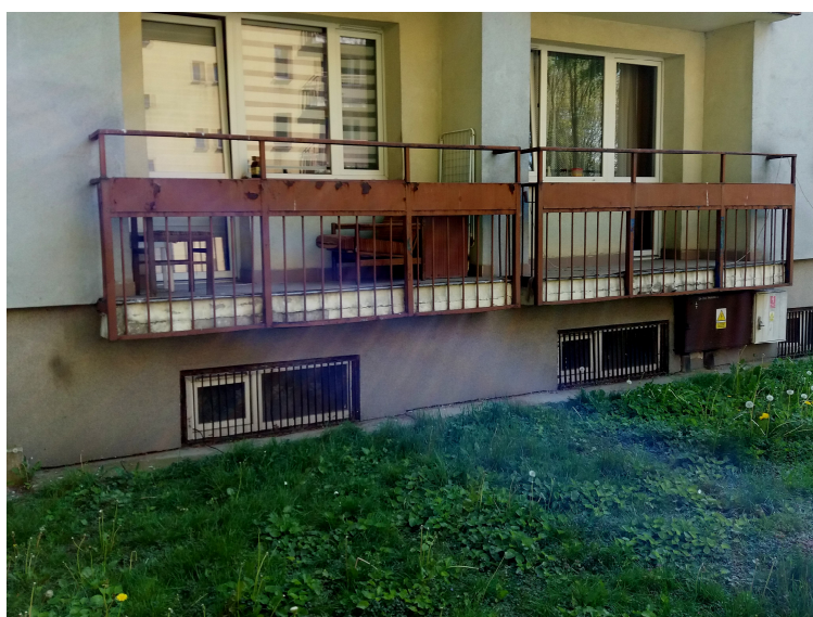
Zdjęcie nr 4: Widok brzegu płyty balkonu segmentu 'C', widoczne rozwarstwienie płyty oraz korozja i odkształcenie balustrady stalowej
