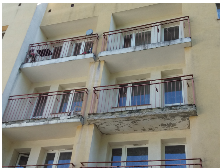
Zdjęcie nr 6: Widok brzegu płyty balkonu segmentu 'D', widoczne rozwarstwienie płyty oraz stan jej powierzchni
