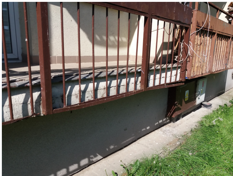
Zdjęcie nr 9: Widok balustrady stalowej balkonu segmentu 'B', widoczne rozwarstwienie płyty oraz korozja i odkształcenie balustrady stalowej
