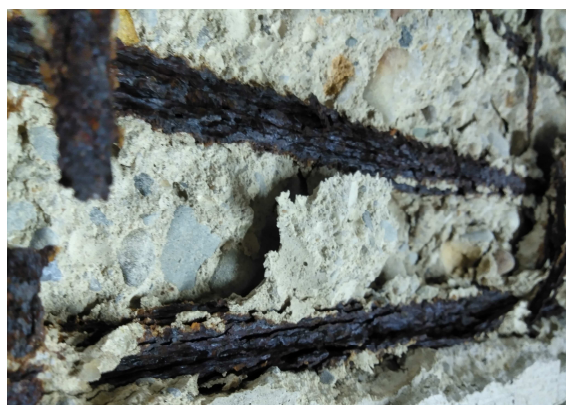
Zdjęcie 14. Korozja zbrojenia belek
