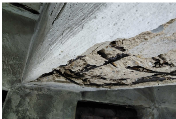
Zdjęcie 16. Uszkodzenia zbrojenia belek 2
