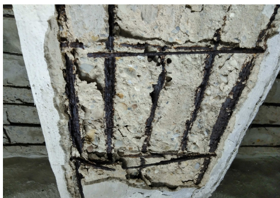
Zdjęcie 13. Uszkodzenia zbrojenia belek
