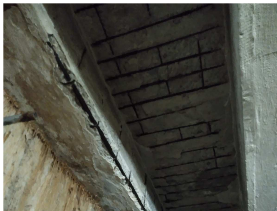
Zdjęcie 12. Odsłonięte zbrojenie stropu
