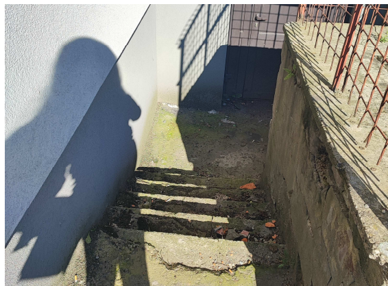
Zdjęcie 7. Uszkodzenia schodów zewnętrznych 2
