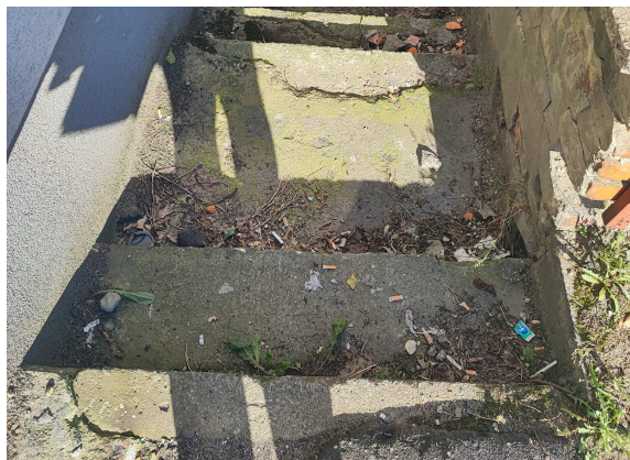
Zdjęcie 6. Uszkodzenia schodów zewnętrznych 1
