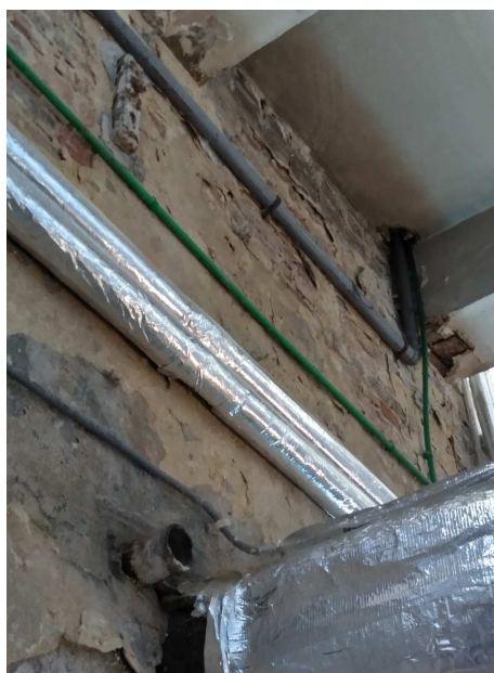
Zdjęcie 4. Ubytki w tynku ściany
