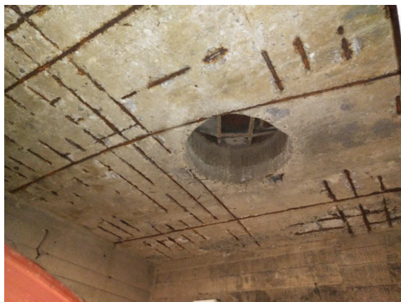
Zdjęcie 11. Korozja zbrojenia stropu
