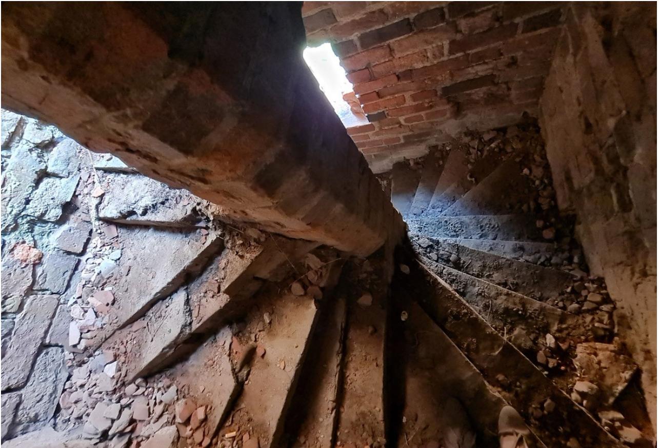
36. Zamek Dybowski. Klatka schodowa w murze, prowadząca na wieżę i koronę murów. Rekonstrukcja. Stan w sierpniu 2022 r. (Fot. E. Płocińska.)
