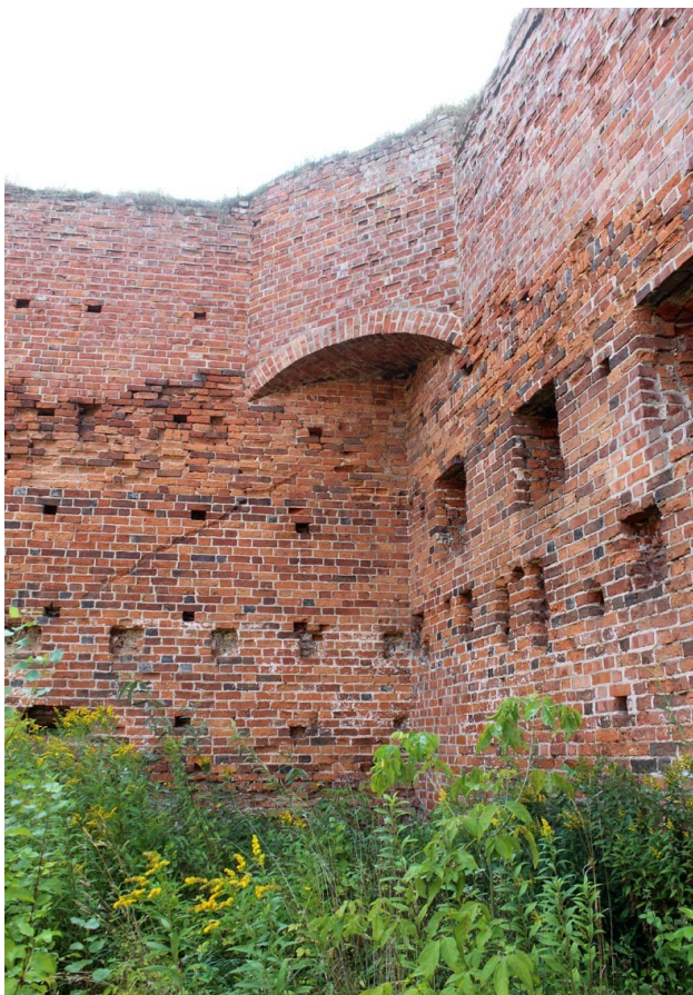
95. Zamek Dybowski. Zniszczenia cegły w obrębie lica murów. Sierpień 2022 r. (Fot. E. Płocińska)
