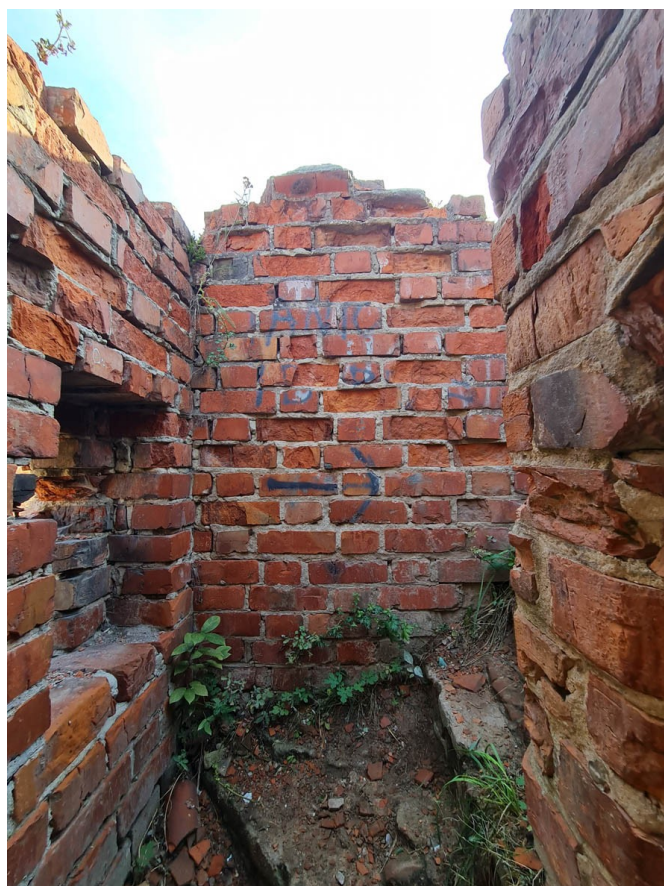
102. Zamek Dybowski. Zniszczenia cegły w obrębie lica murów. Widoczne białe wykwyty będące skutkiem wyłukiwania rozpuszczonych w wodzie składników zapraw. Destrukcja cegieł w partii korony i izolacji poziomej muru. Stan w sierpniu 2022 r. (Fot. E. Płocińska)
