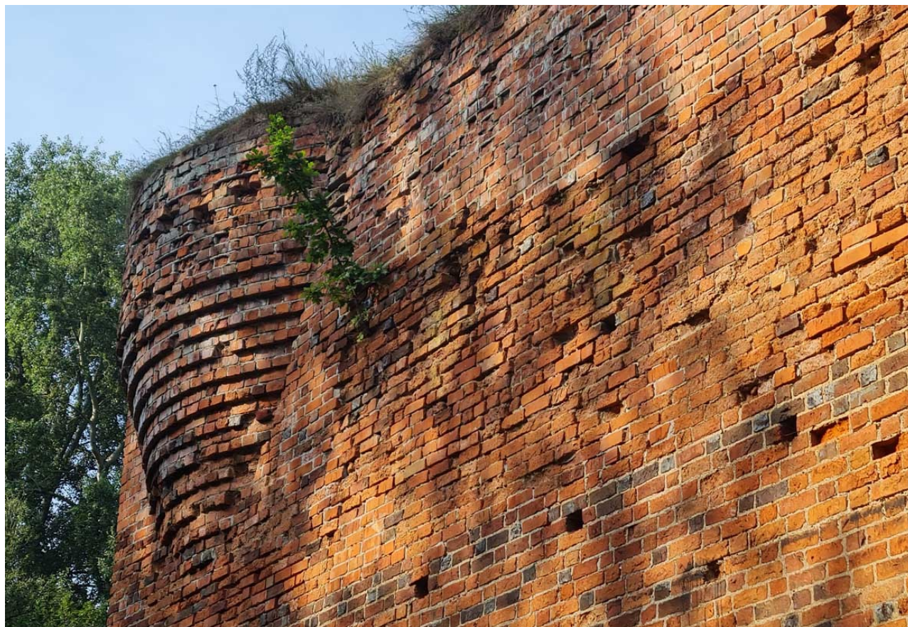
92. Zamek Dybowski. Zniszczenia cegły w obrębie lica murów. Sierpień 2022 r. (Fot. E. Płocińska)
