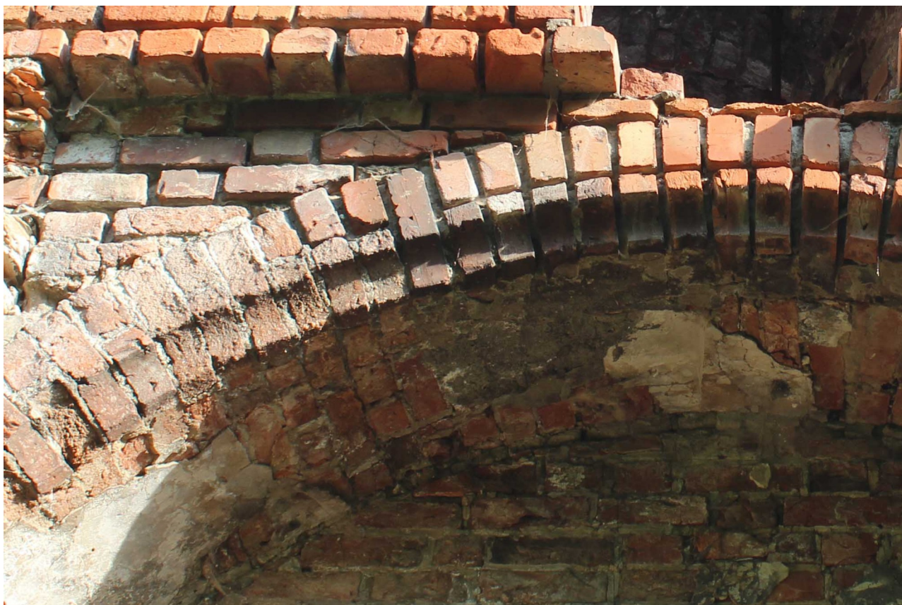
45. Zamek Dybowski. Kształtki ceramiczne profilowanie w formie wklęsły. Północna ściana wieży bramnej. Stan w sierpniu 2022 r. (Fot. E. Płocińska.)
