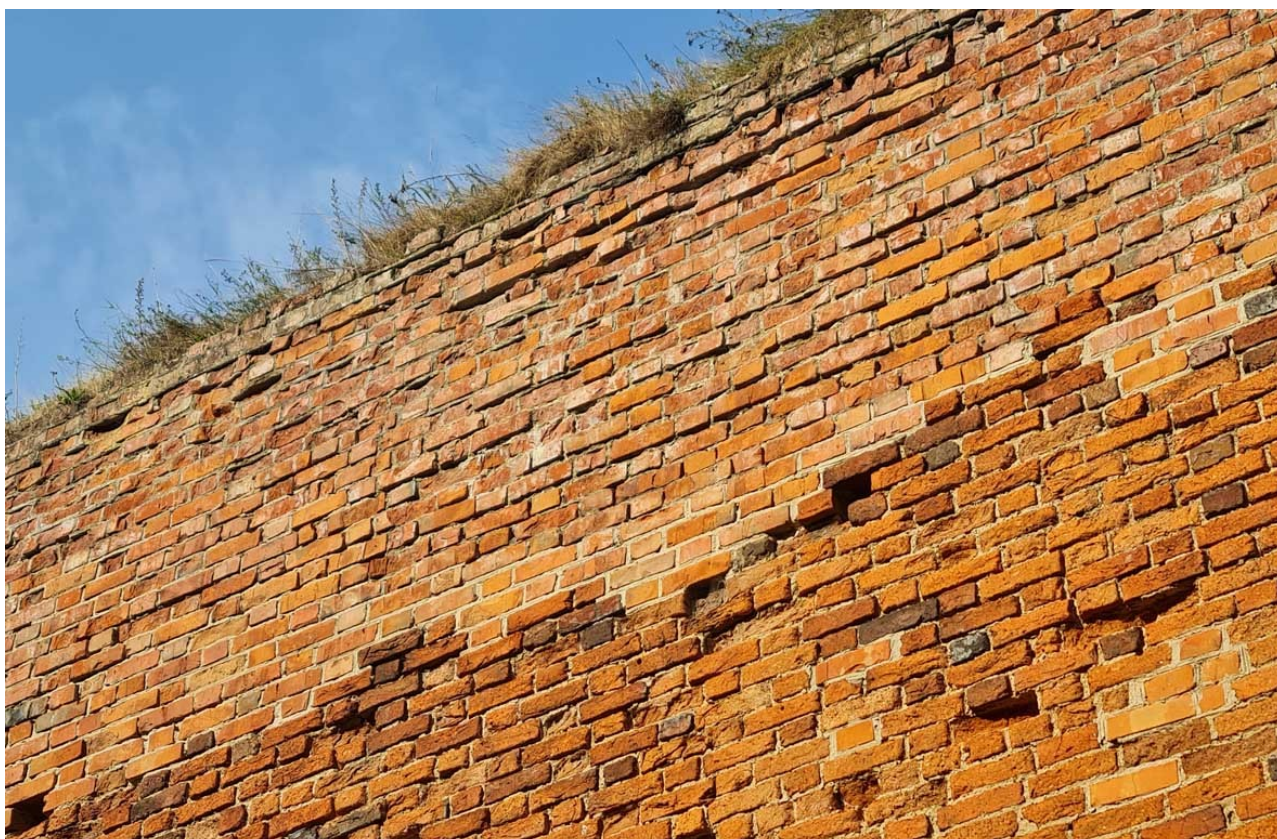
101. Zamek Dybowski. Zniszczenia cegły w obrębie lica murów. Widoczne białe wykwyty będące skutkiem wypłukiwania rozpuszczonych w wodzie składników zapraw. Destrukcja cegieł w partii korony i izolacji poziomej muru. Stan w sierpniu 2022 r. (Fot. E. Płocińska)
