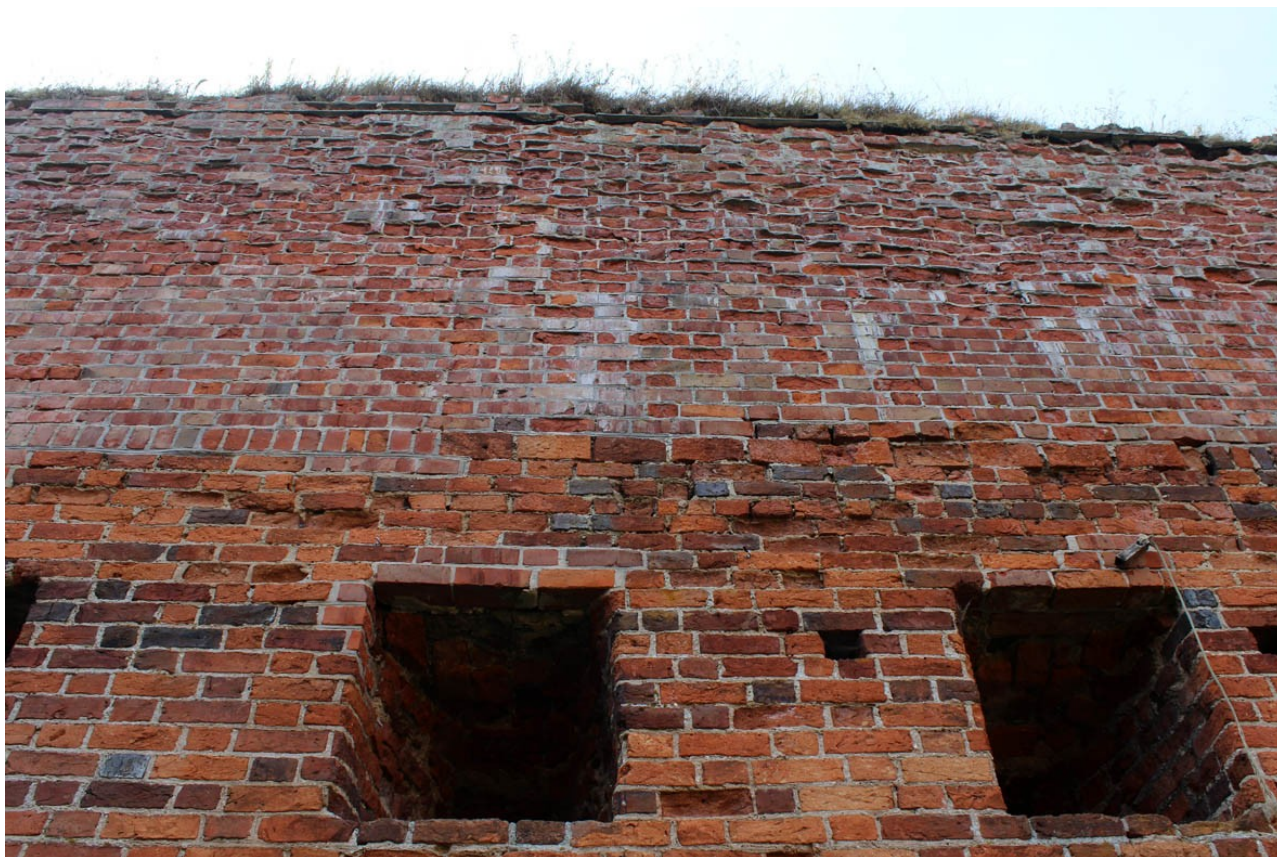
102. Zamek Dybowski. Zniszczenia cegły w obrębie lica murów. Widoczne białe wykwyty będące skutkiem wyłukiwania rozpuszczonych w wodzie składników zapraw. Destrukcja cegieł w partii korony i izolacji poziomej muru. Stan w sierpniu 2022 r. (Fot. E. Płocińska)
