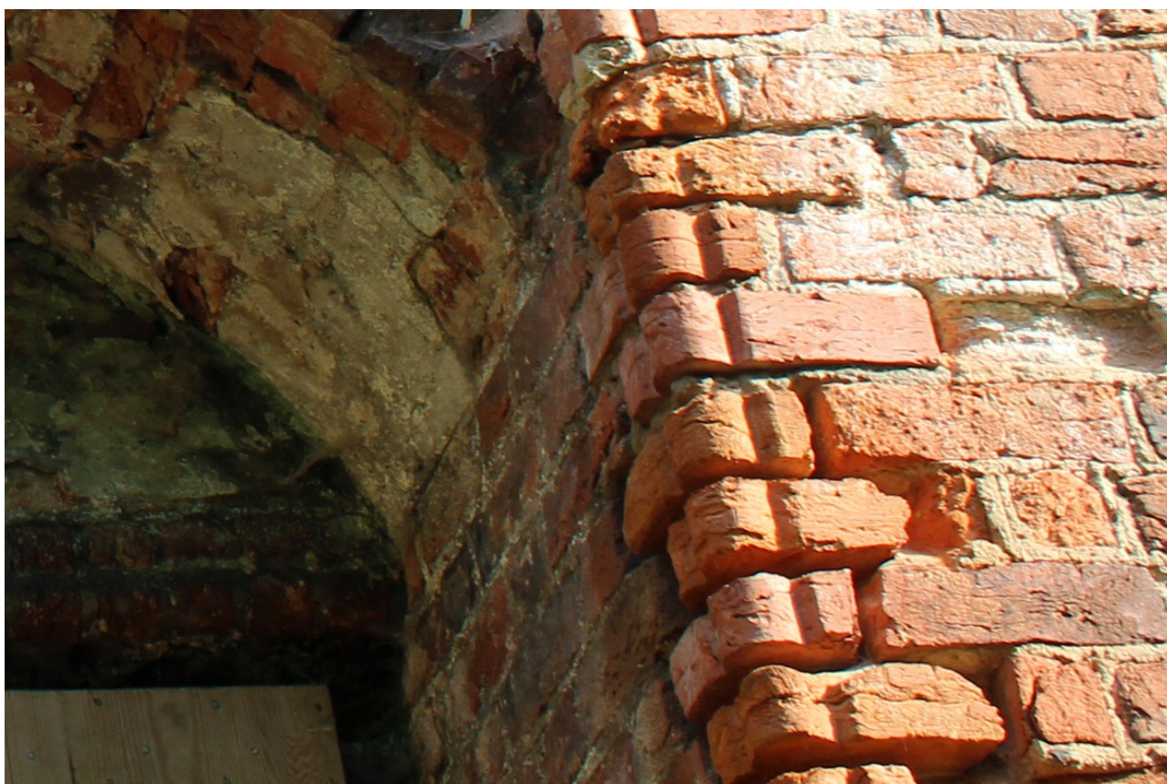
46. Zamek Dybowski. Kształtki ceramiczne profilowanie w formie włók. Północna ściana wieży bramnej. Stan w sierpniu 2022 r. (Fot. E. Płocińska.)
