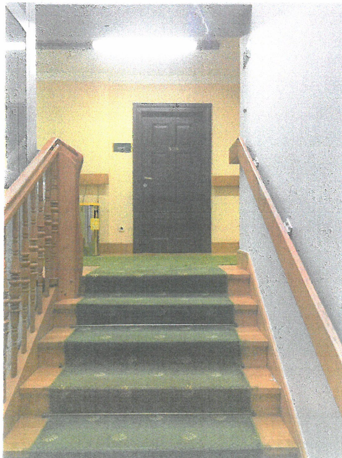
Zdjęcie 24 Przewężenie schodów na końcu biegu
