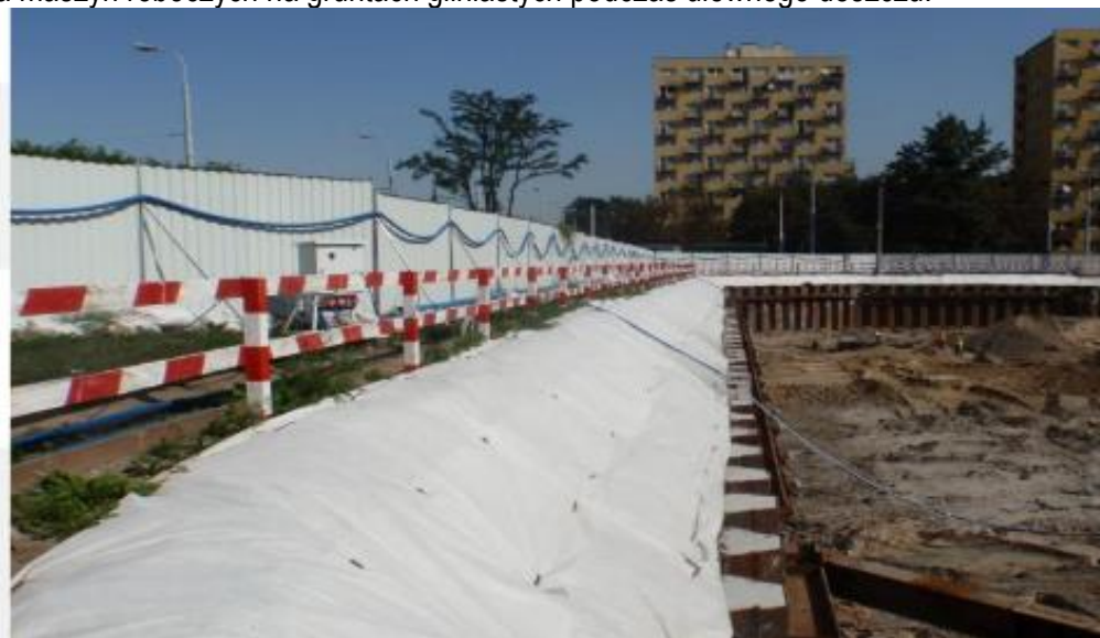
Fot. 59. Zaleca się stosowanie zabezpieczanie powierzchniowe skarpy za pomocą folii lub geowłókniny
