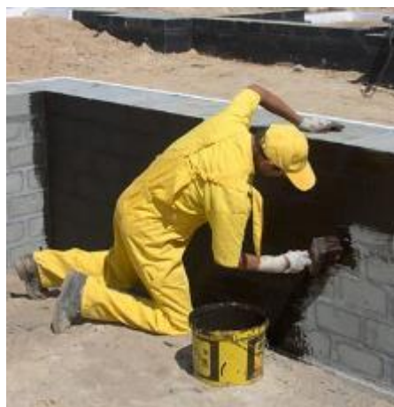
Fot. 52. Wykonanie izolacji pionowej.
