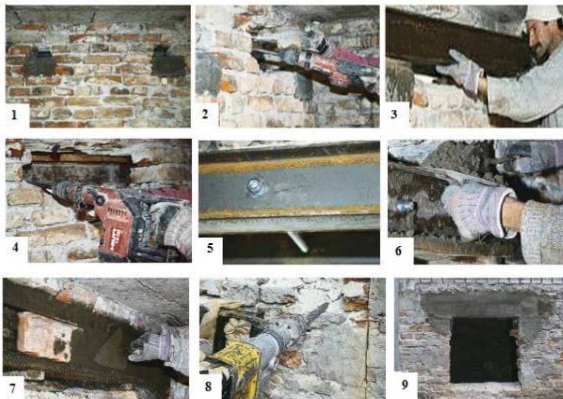
Fot. 54. Przykładowy sposób wykonania nadproża z zastosowaniem belek stalowych (materiały pochodzą z bazy strony muratordom.pl).
