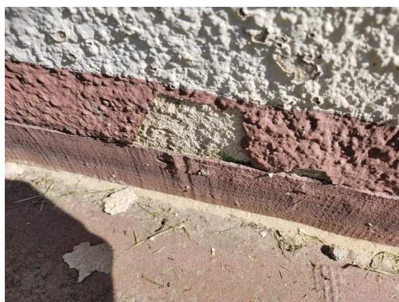
Fot. 11. Miejscowe uszkodzenia tynku zewnętrznego.
