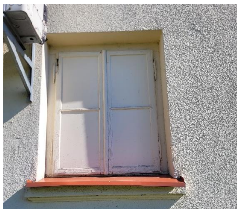
Fot. 13. Uszkodzenia parapetów zewnętrznych oraz stan techniczny części stolarki okiennej.
