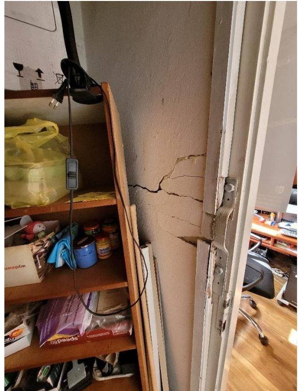
Fot. 19. Stan wykończenia pomieszczeń parteru. Zarysowania ścian wewnętrznych.
