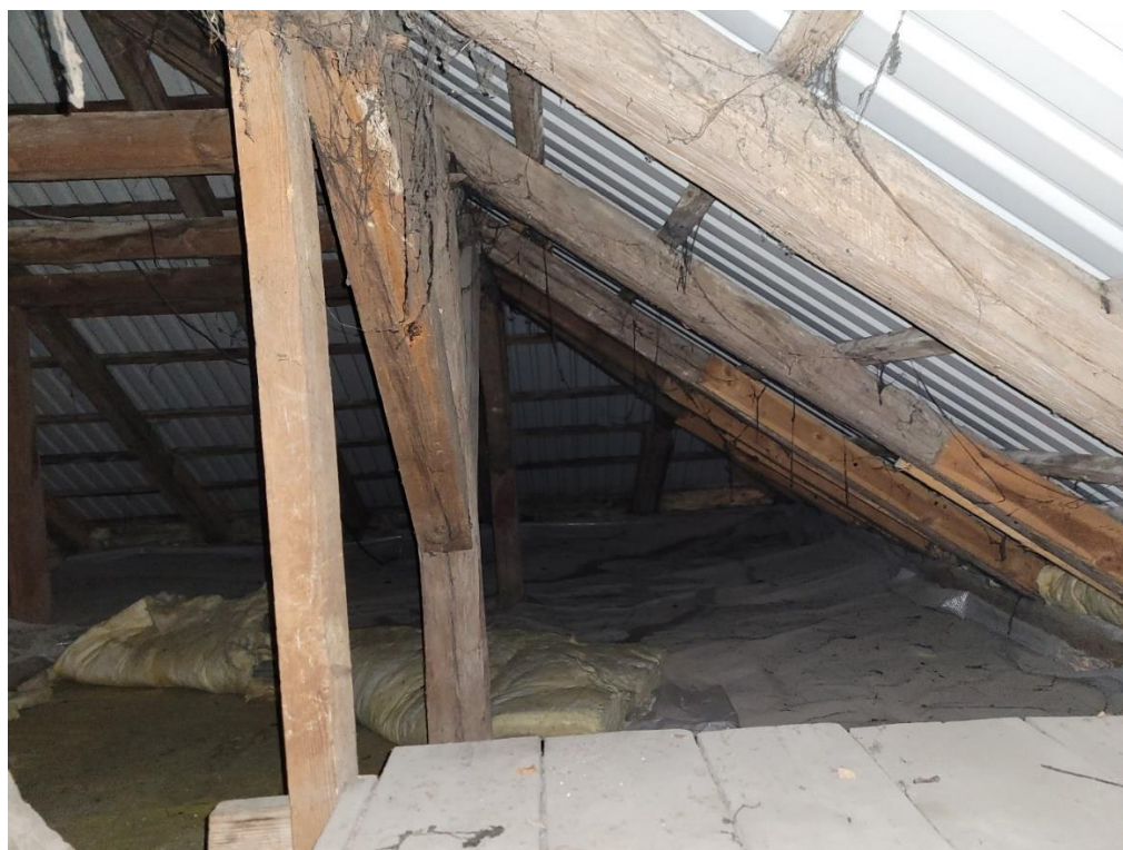
Fot. 50. Stan wykończenia konstrukcji dachowej. Wzmocnienia konstrukcji.
