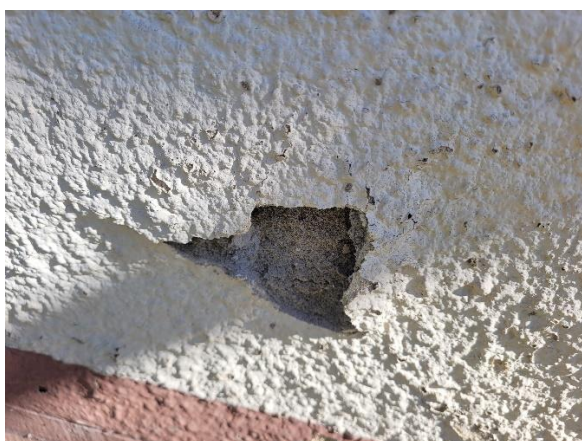
Fot. 10. Miejscowe uszkodzenia tynku zewnętrznego.
