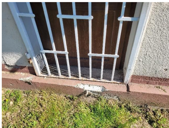
Fot. 12. Miejscowe uszkodzenia ocieplenia ścian fundamentowych. Błędnie wykonane ocieplenie.
