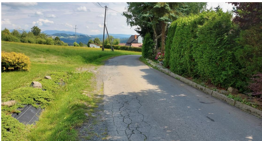
Fot. 2 Uszkodzona nawierzchnia i pochylone obramowanie jezdni
