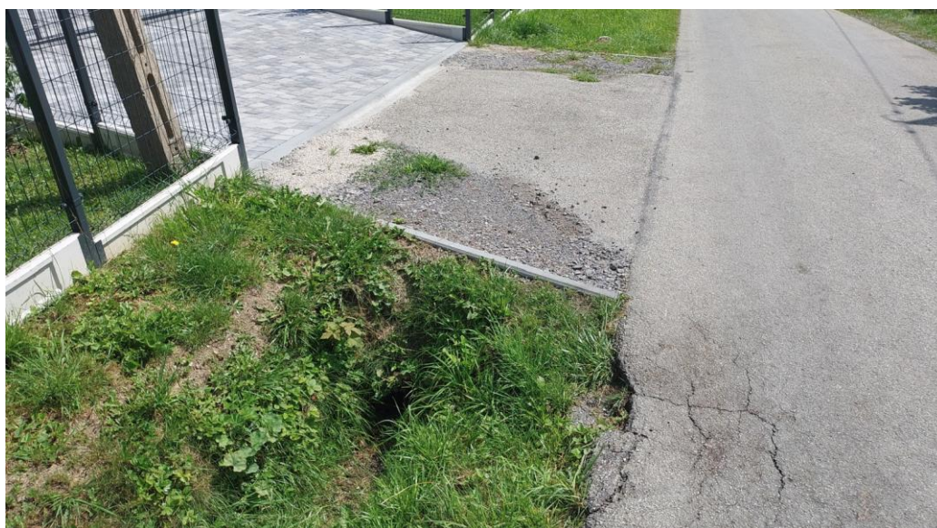
Fot. 3 Zdegradowana ścianka czołowa przepustu pod zjazdem
