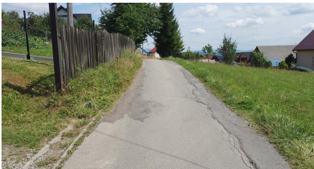
Fot. 4. Zamulone, spękane elementy odwodnienia
