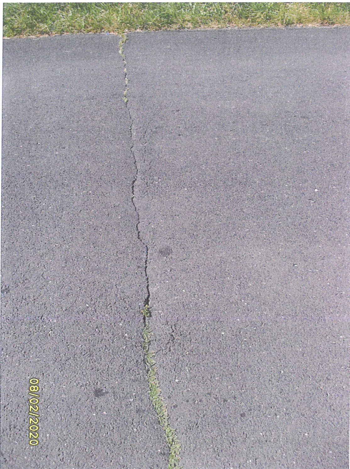
Foto. nr 3 – Poprzeczne spękanie nawierzchni.
