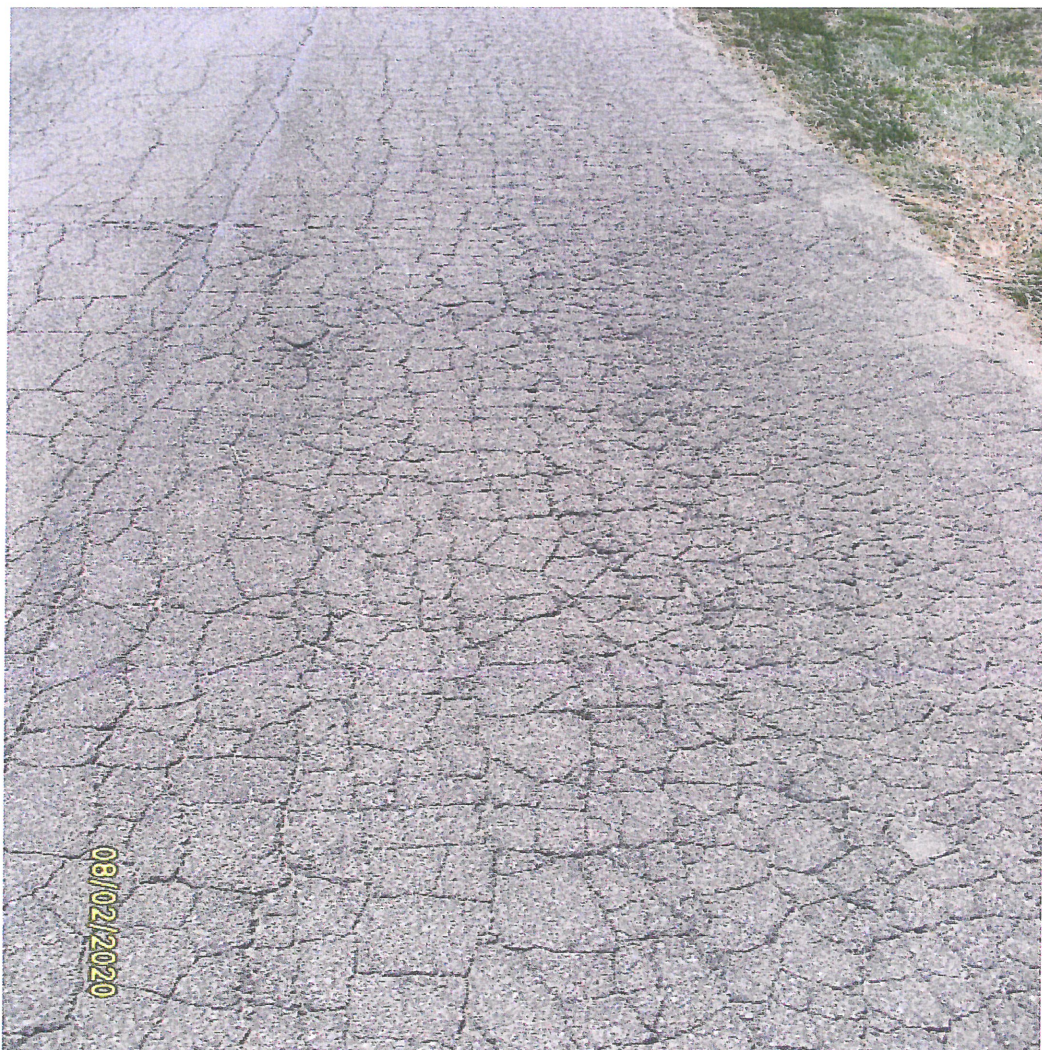
Foto. nr 1 – Liczne spękania siatkowe nawierzchni.
