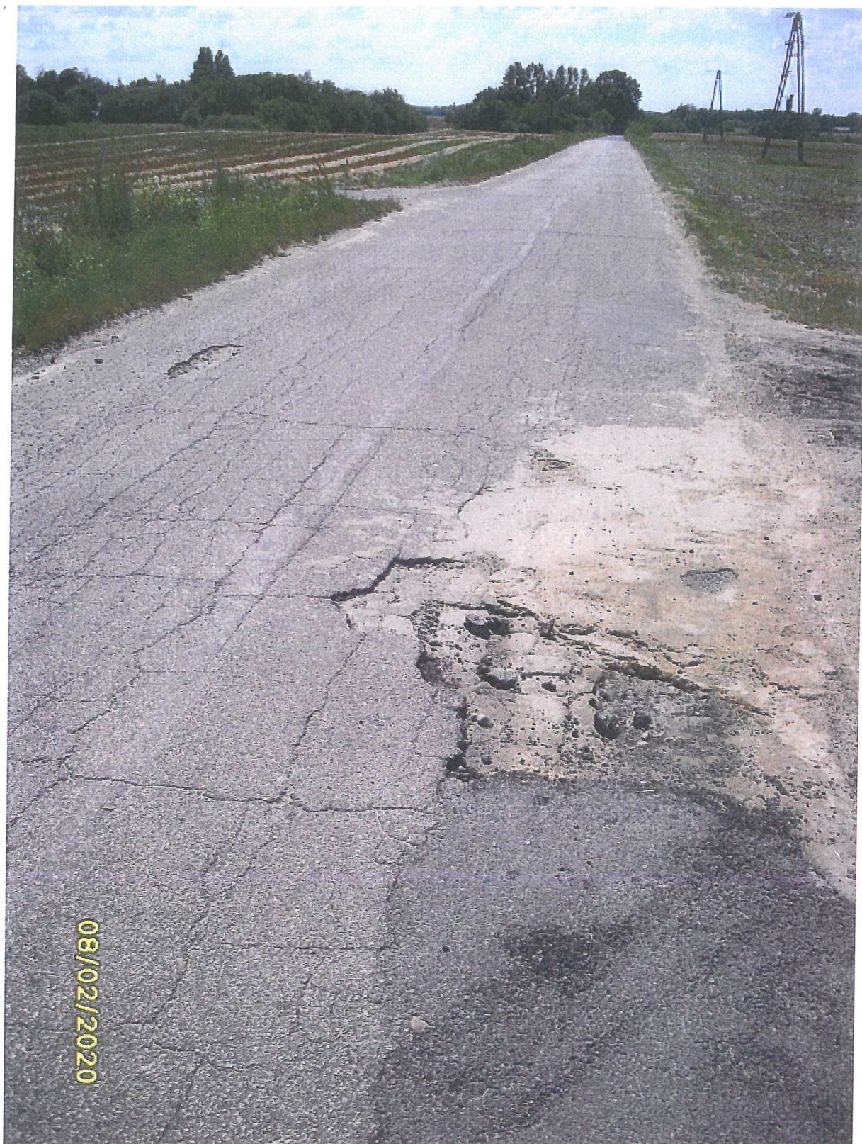
Foto. nr2 – Ubytki w warstwie ścieralnej.
