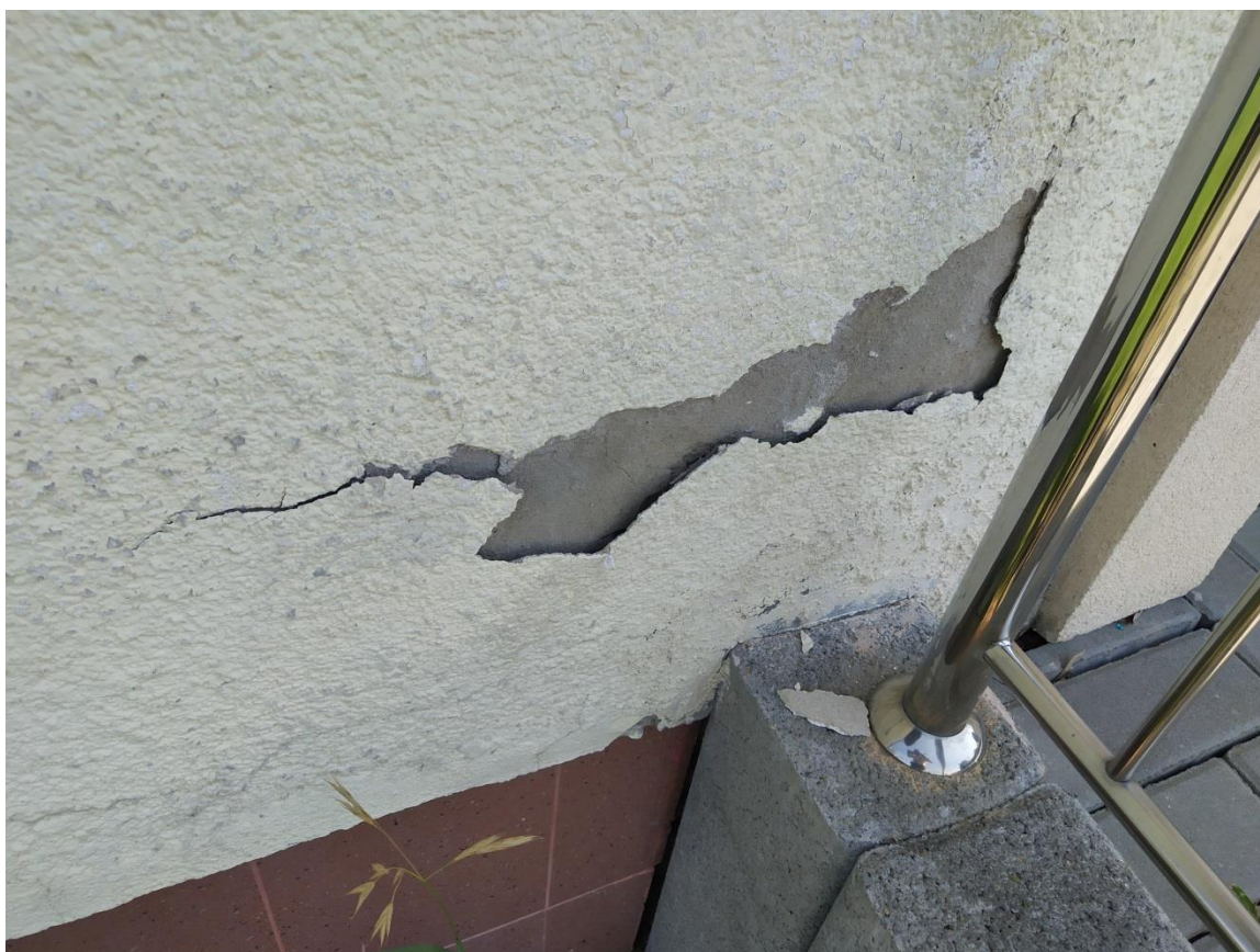
Zdj. nr 7 _ Ściana zachodnia budynku _ uszkodzony tynk na elewacji.
