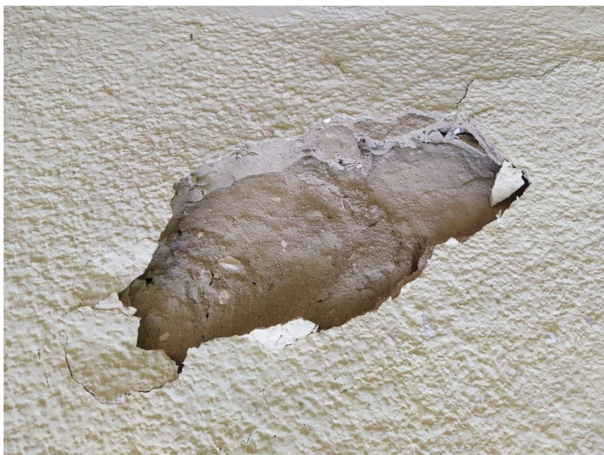
Zdj. nr 8 _ Ściana wschodnia budynku _ uszkodzony tynk na elewacji.
