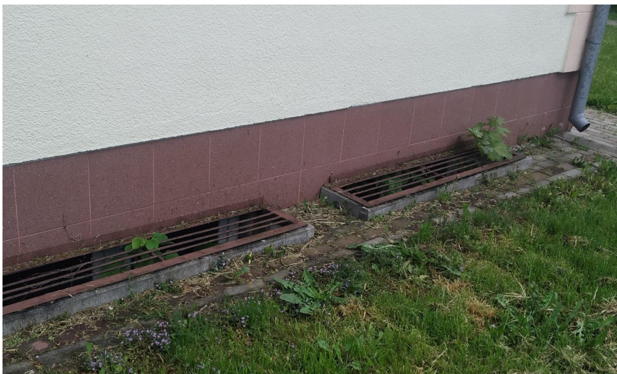
Zdj. nr 15 _ Elewacja zachodnia_ zabezpieczenie okien piwnicznych kratami stal.
