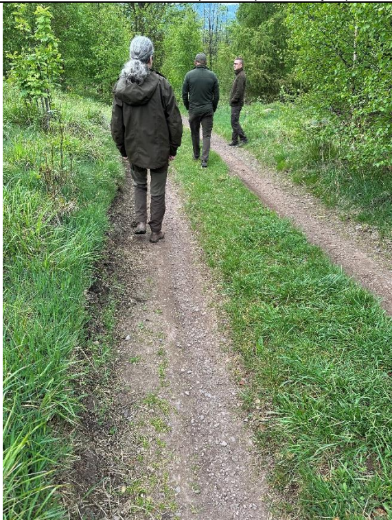
Degradacja nawierzchni przez jej wymycie, zawyżone pobocza- brak odwodnienia
