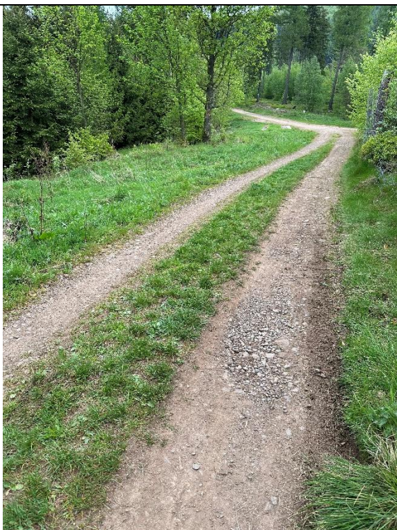
Widoczne koleinowanie, brak poboczy, zarośnięte pobocza
