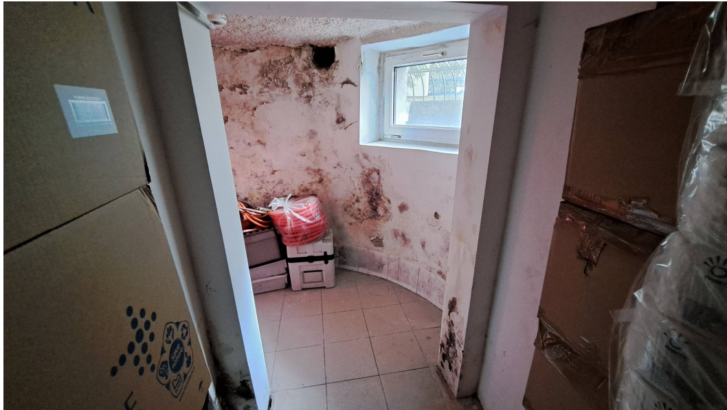
Zdj. 6 – Pomieszczenie magazynowe 0.7 – zawilgocenie ściany zewnętrznej
