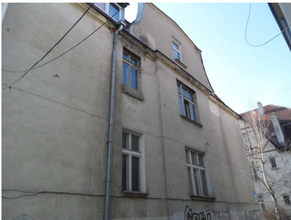
Fragment elewacji wschodniej – widoczne okna na 1 piętrze należą do mieszkania nr 3. Okno po lewej stronie (patrzac na fotografię) znajduje się w otworze podmurowanym w części dolnej
