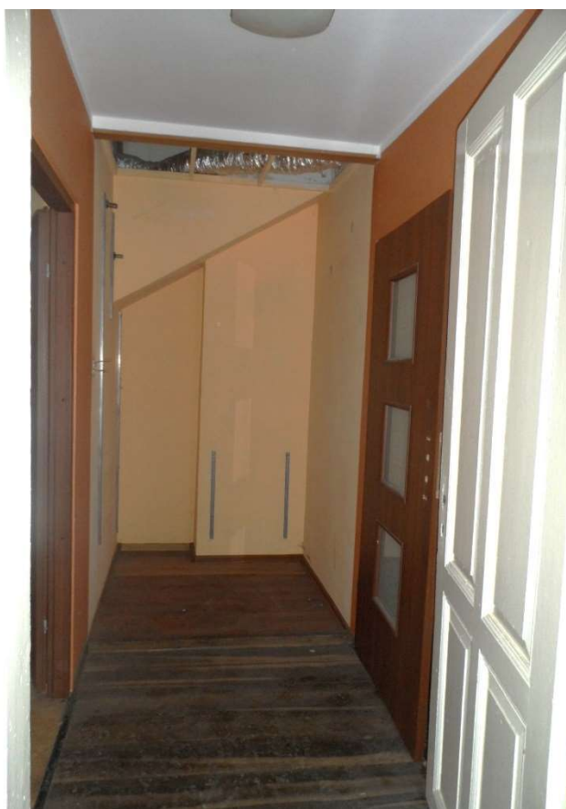
Korytarz (I-08) – powyżej sufitu podwieszonego widoczna rura wentylacyjną – elastyczna rozprawadzenia ciepłego powietrza z kominka
