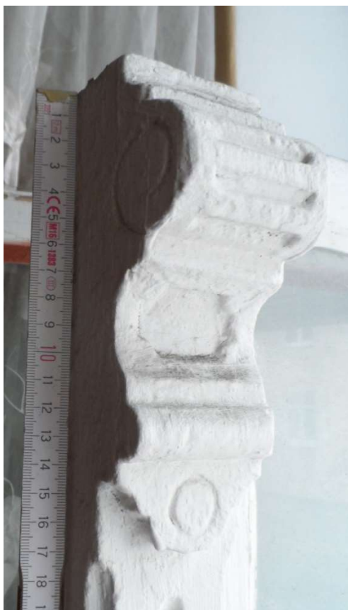
Ozdobna główka na zewnętrznej ramie okiennej (zachowały się na 3 oknach spośród 7 drewnianych okien skrzynkowych)
