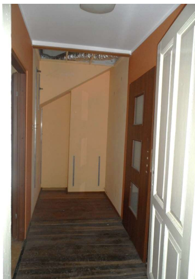
Korytarz (I-08) – powyżej sufitu podwieszonego widoczna rura wentylacyjną – elastyczna rozprowadzenia ciepłego powietrza z kominka
