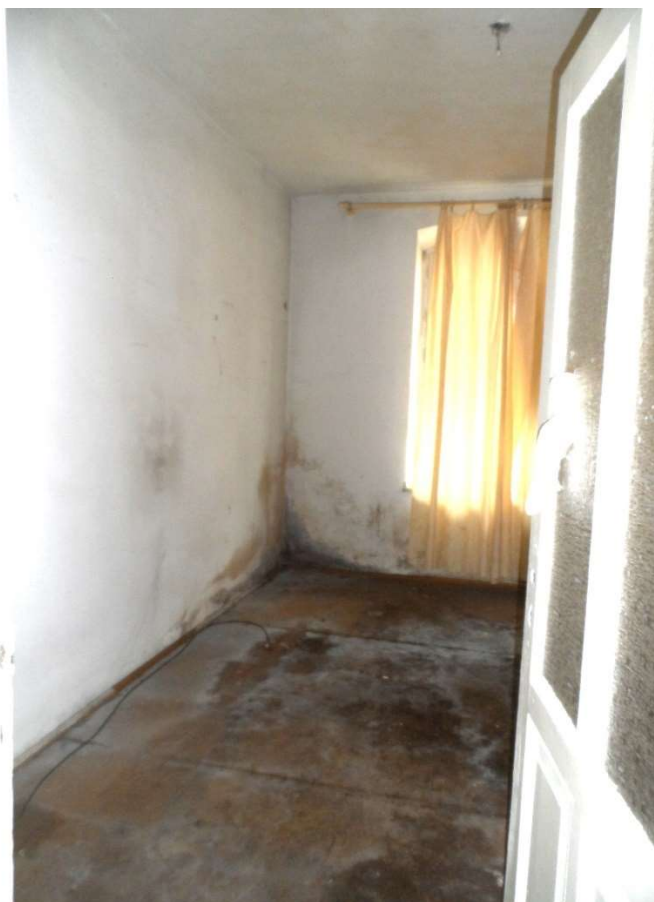
Pokój (I-06) od strony ul. Lelewela – zalany w wyniku awarii wodociągowej na II piętrze budynku na przełomie stycznia i lutego 2024 r.
