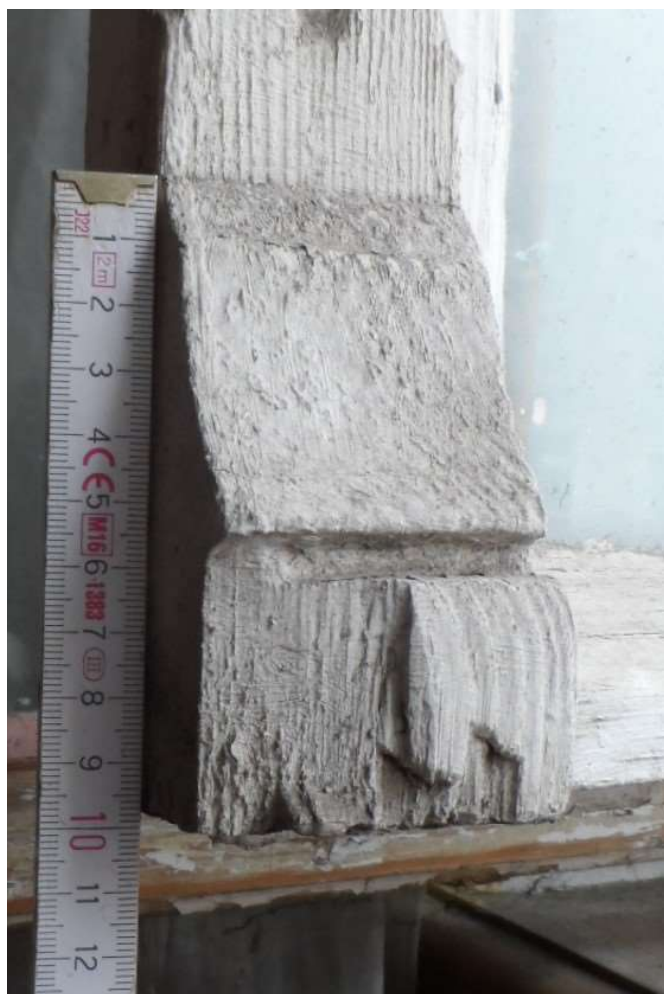
Ozdobna stopka na ramie zewnętrznej okien skrzynkowych (zachowały się na 3 oknach spośród 7 drewnianych okien skrzynkowych)
