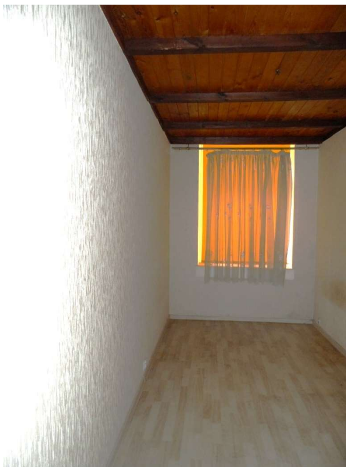
Pokój (I-11) – widoczny sufit podwieszony z desek z ozdobnymi belkami (do rozbiórki)
