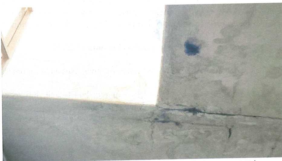
Fot. 11 widoczne stare zacieki w okolicy wyłazu dachowego. Widoczne są ślady czarnej pląśni.
