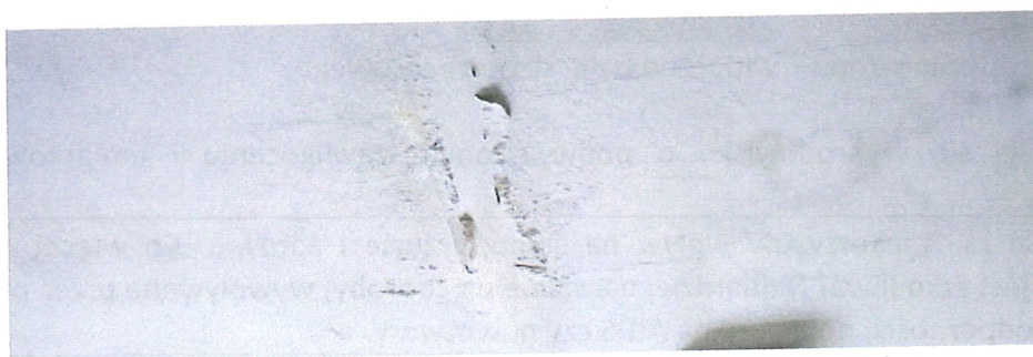
Fot. 10 widoczne zacieki, które spowodowały degradację tynku;
