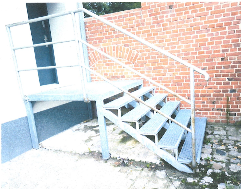
Fot.3 Zewnętrzne schody stalowe – wodoczne ślady korozji;
