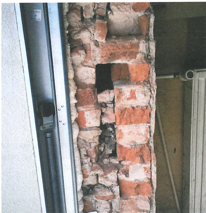
Fot. 8 widok prostopadły na otwór bramy garażowej parteru. Niepoprawnie wykonane powiększenie, poszarpana cegła pozostawiona na działanie czynników atmosferycznych ;
