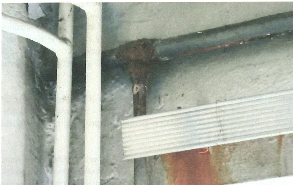
Fot. 13 W pomieszczeniu parteru stwierdzono występowanie awarii instalacji C.O.
