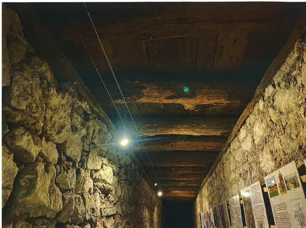
Fot. 8. Drewniany strop w piwnicy, stan przed konserwacją.
