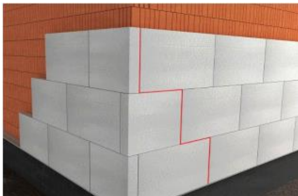
Fot. 6. Układ płyt termoizolacyjnych w narożniku wypukłym
