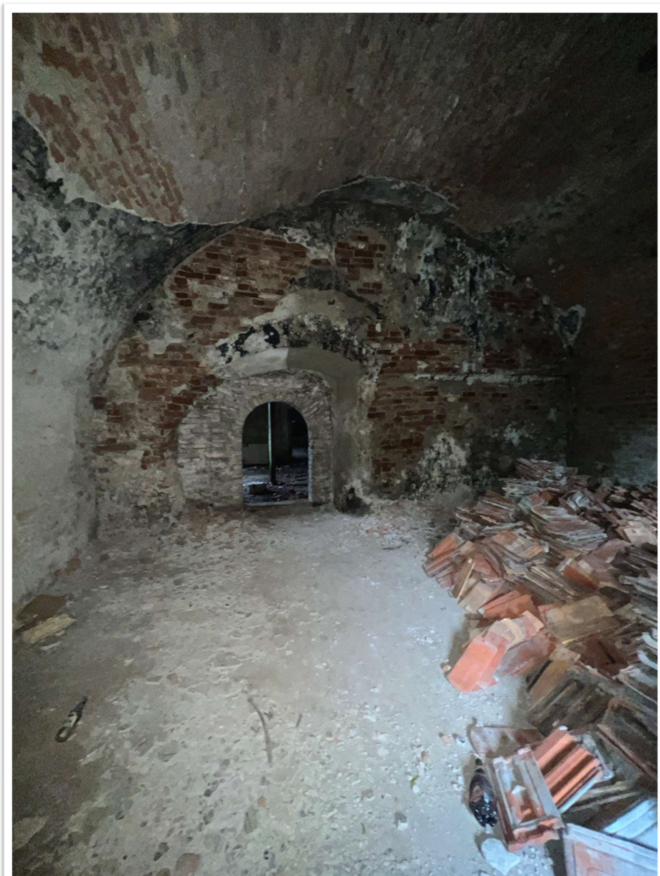
Przejście pomiędzy pomieszczeniem nr 5, a pomieszczeniem nr 4, strop łukowy ceglany.
