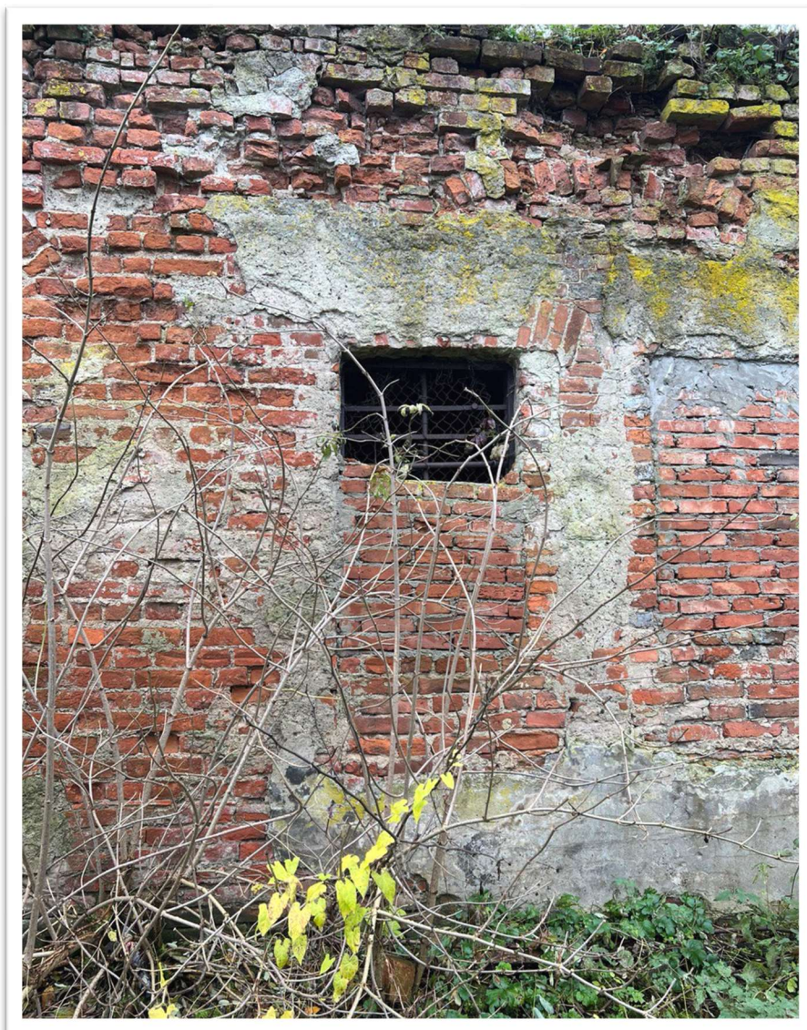
Część elewacji północnej (zamurowane otwory okienne pomieszczenia nr 3)
