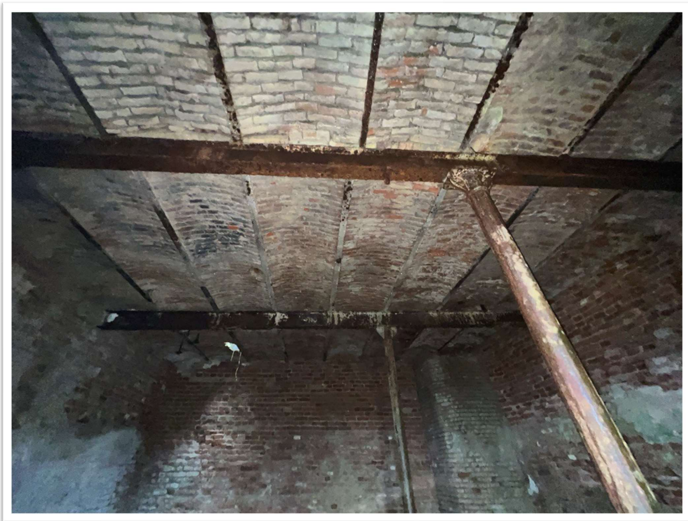
Strop łukowy Kleina na belkach stalowych podparty metalowymi okrągłymi słupami.
