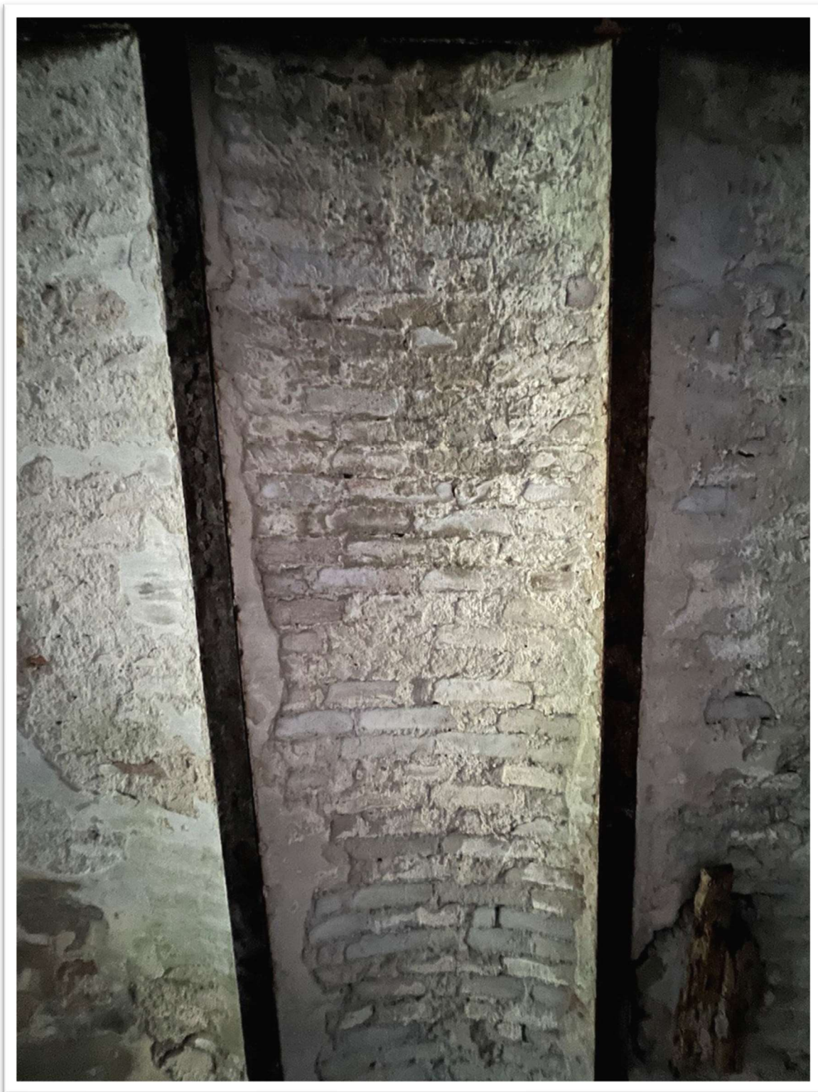
Strop łukowy Kleina na belkach stalowych podparty metalowym okrągłym słupem.
