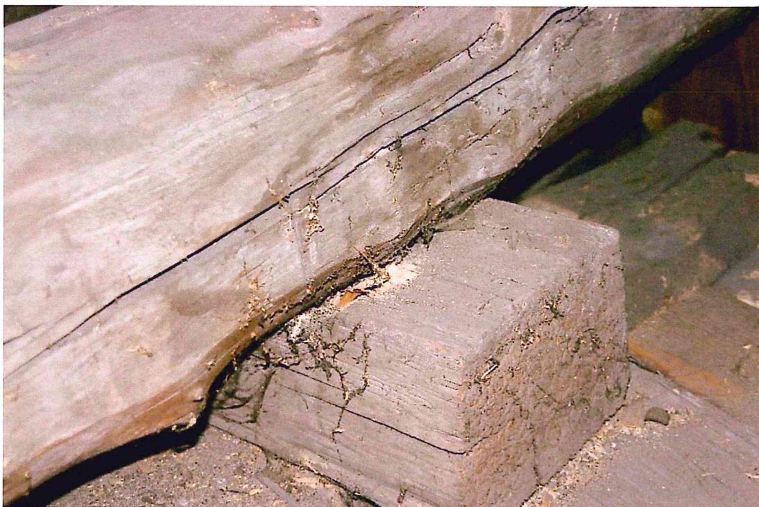
Fot.16a. Elementy drewniane więźby dachowej. Świeża mączka drzewna, ślad żerowania drewnojadów.
