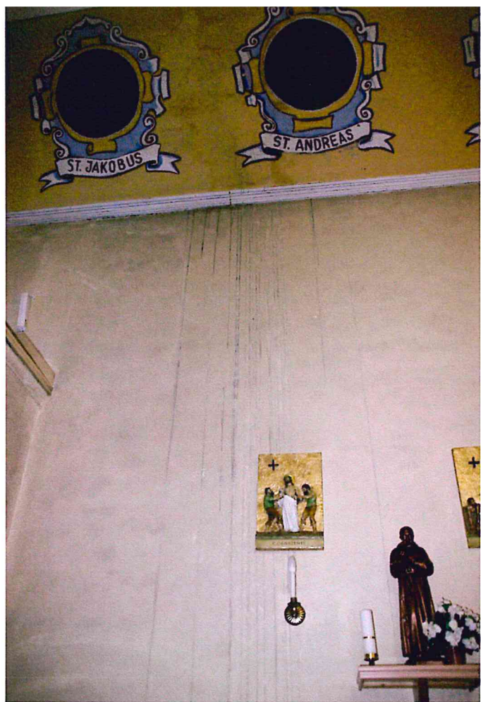
Fot. 13. Zacieki na ścianie świątyni.
