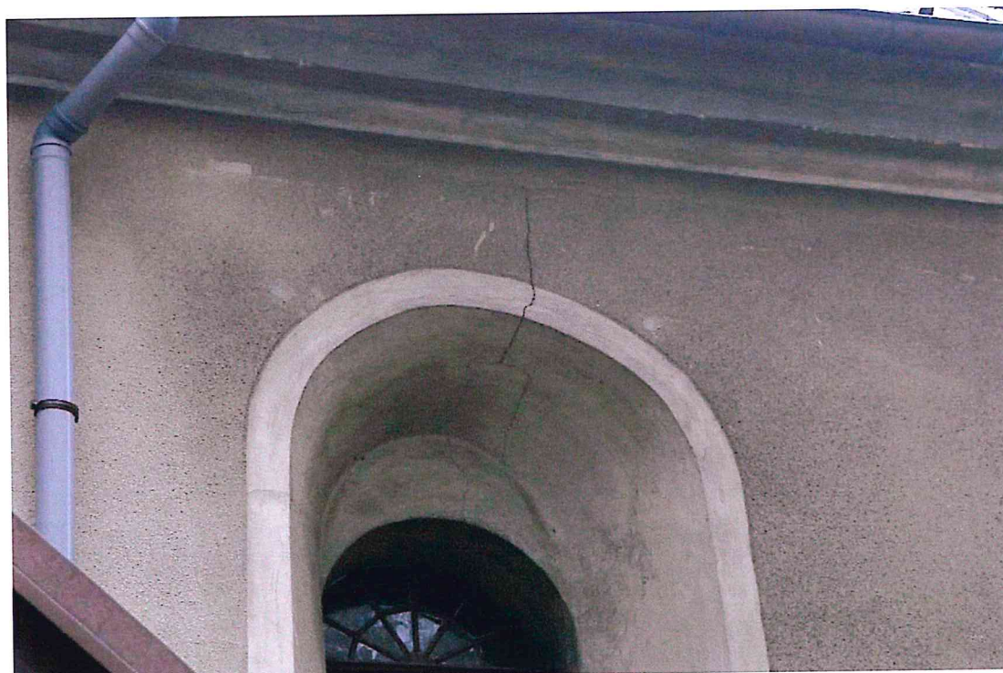
Fot. 4. Elewacja kościoła. Pęknięcie strukturalne w podniebiu łuku okiennego.
