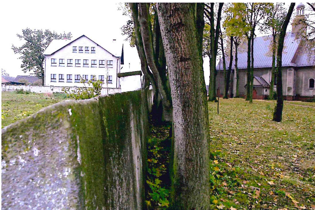
Fot.17. Mur okalający kościół i plebanię, przechylony odcinek.
