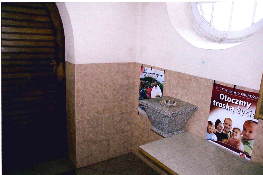
Fot.9. Kruchta. Zawilgocenia ściany oraz wysolenia widoczne ponad płytkami.
