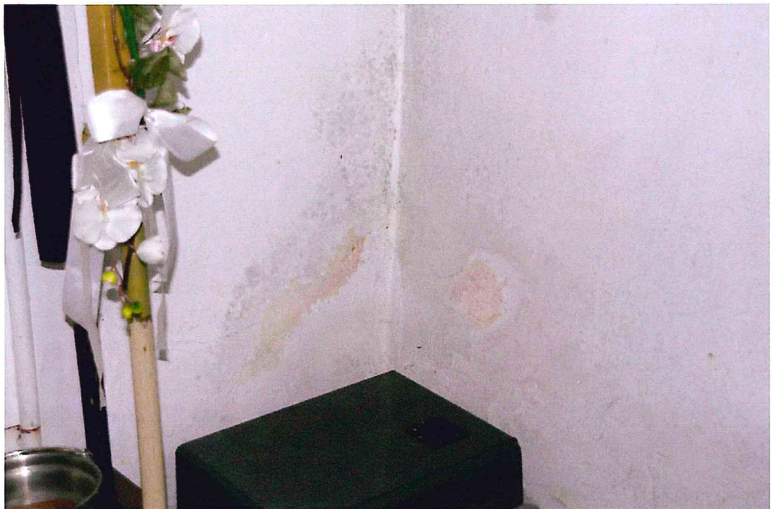
Fot. 12. Wnętrze kościoła. Zawilgocona, zagrzybiona ściana w zakrystii.
