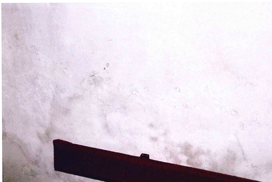
Fot. 8. Wnętrze kościoła. Spęcherzenia powierzchniowej warstwy tynku.
