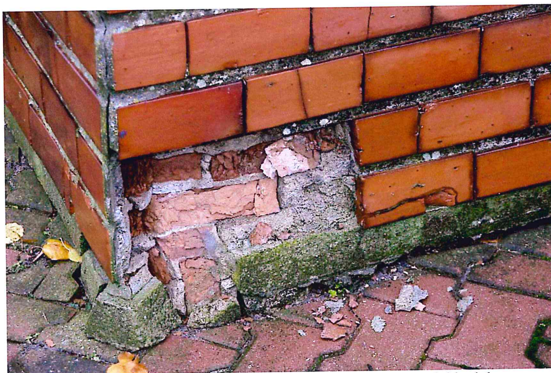
Fot. 2. Cokół kościoła. Ubytki w okładzinie oraz odsłonięty materiał budulcowy.
