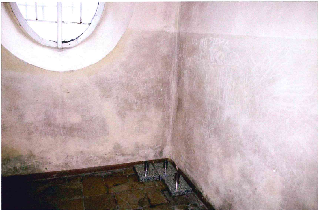
Fot. 11. Wnętrze kościoła. Szary nalot na ścianach.
