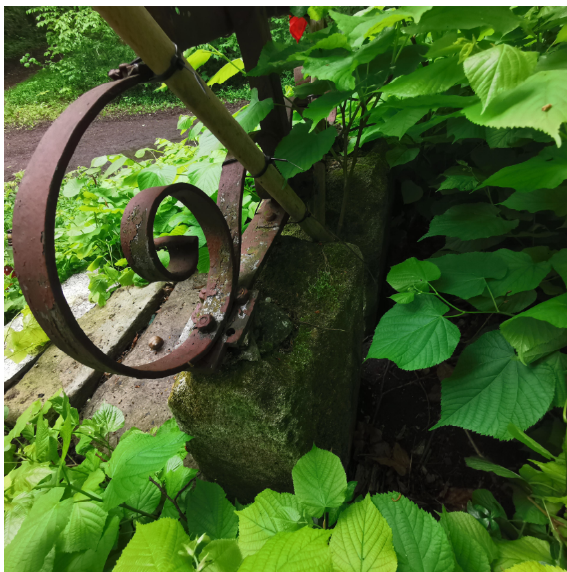
Fot. 10 Widok podstawy krzyża, ubytków cokołów oraz mocowania krzyża.
