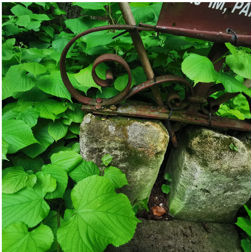
Fot. 9 Widok podstawy krzyża, ubytków cokołów oraz mocowania krzyża.
