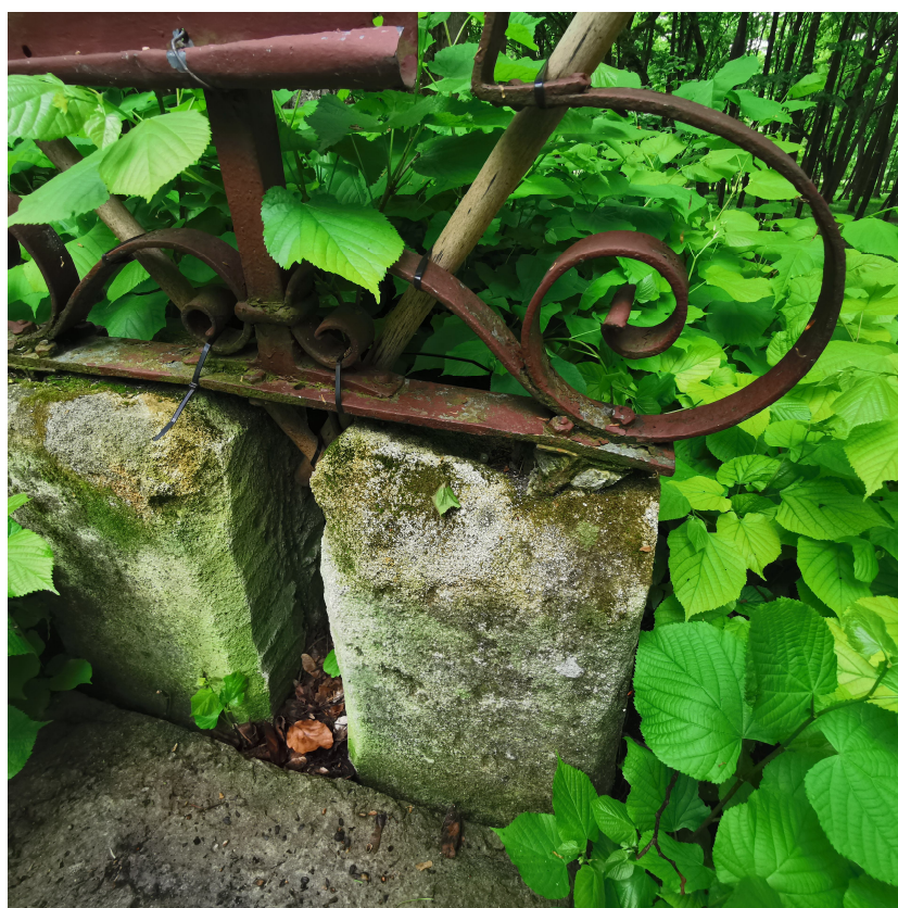
Fot. 8 Widok podstawy krzyża, ubytków cokołów oraz mocowania krzyża.
