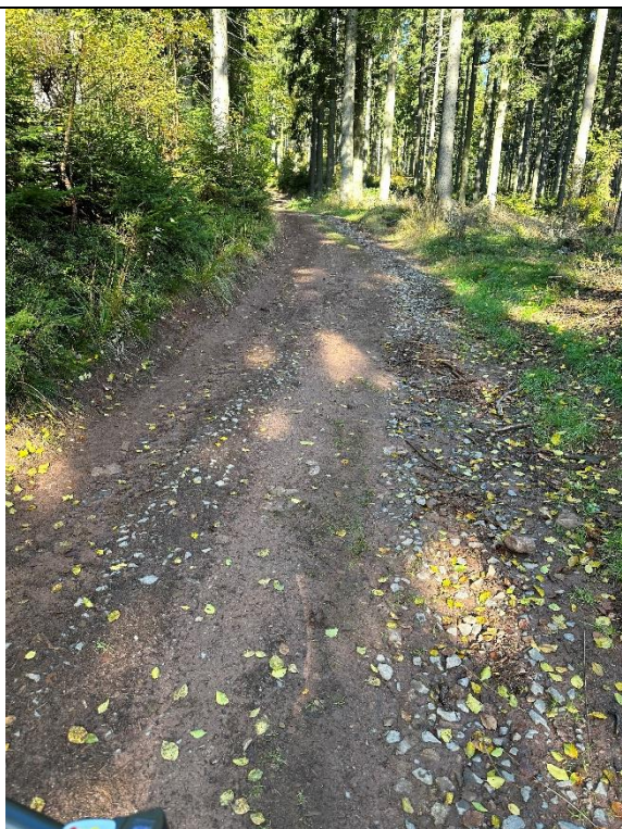
Degradacja nawierzchni przez jej wymycie, zawyżone pobocz- brak odwodnienia
