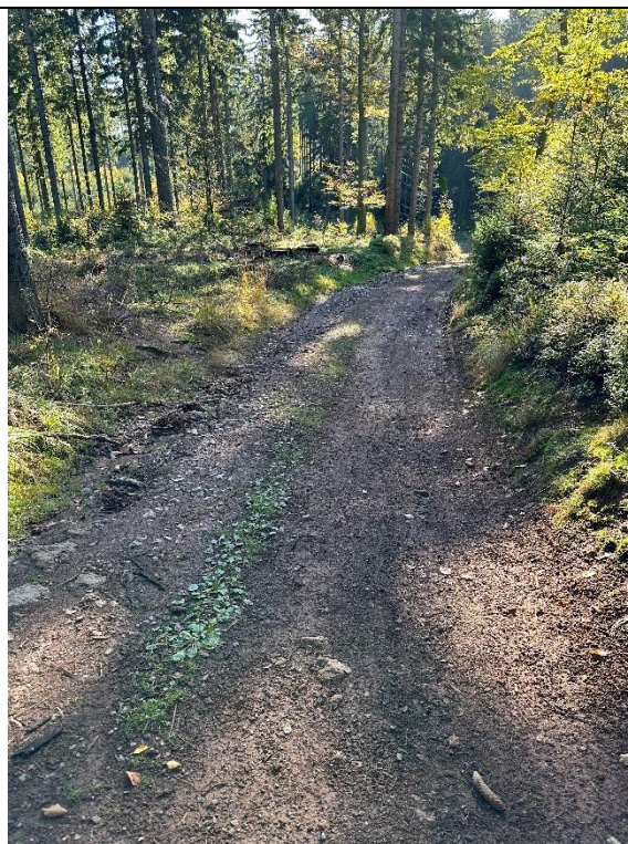
Koleinowanie, zastoiska wody, degradacja nawierzchni
