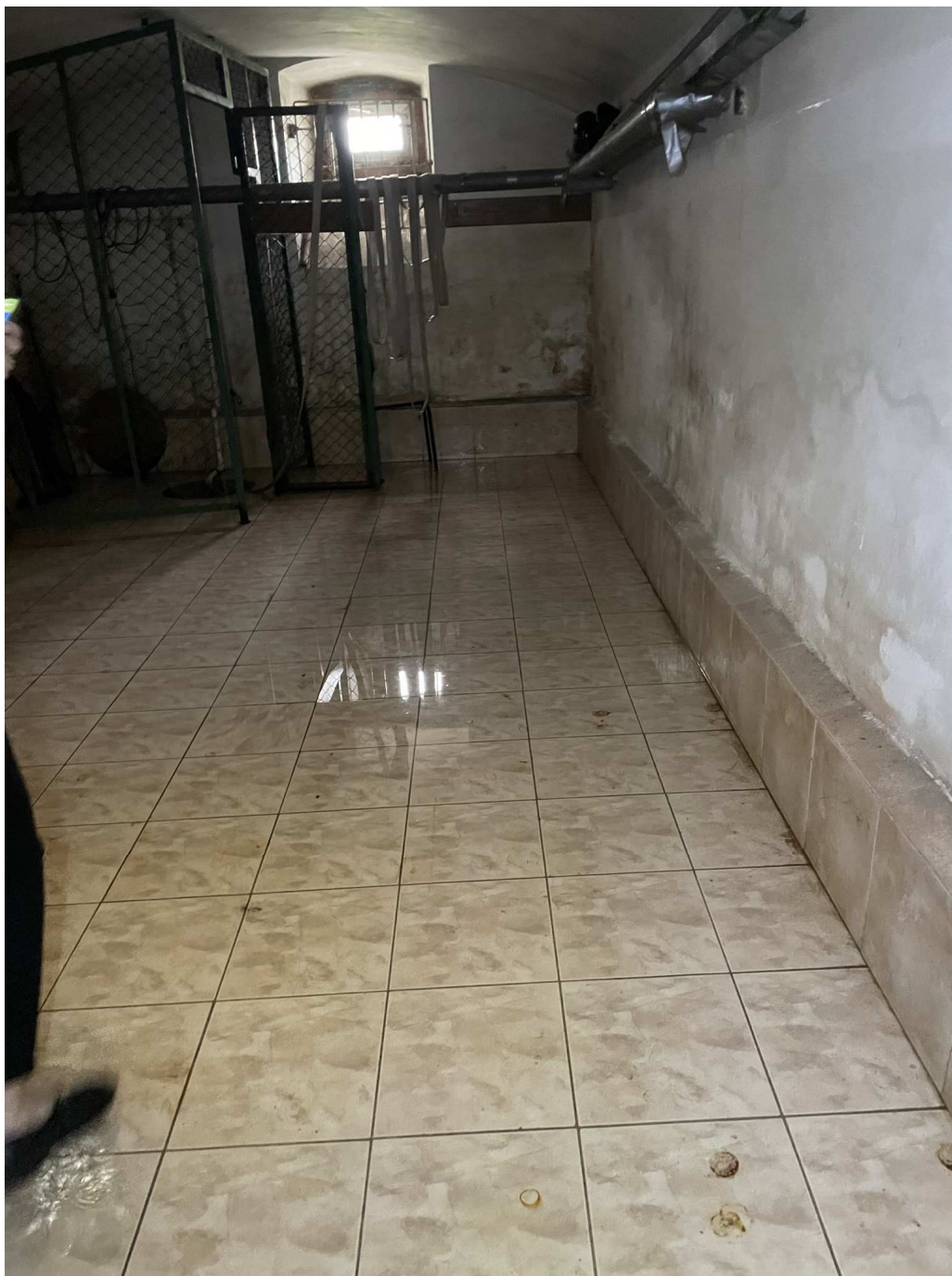
Woda gruntowa wybija przez studzienkę piwniczną.
