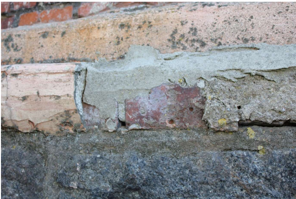
7. Elewacja frontowa, cokół- wtórne warstwy zapraw, oraz niefachowe uzupełnienia ze współczesnej zaprawy cementowej. Fot. Paulina Szczurek, 2024 r.
