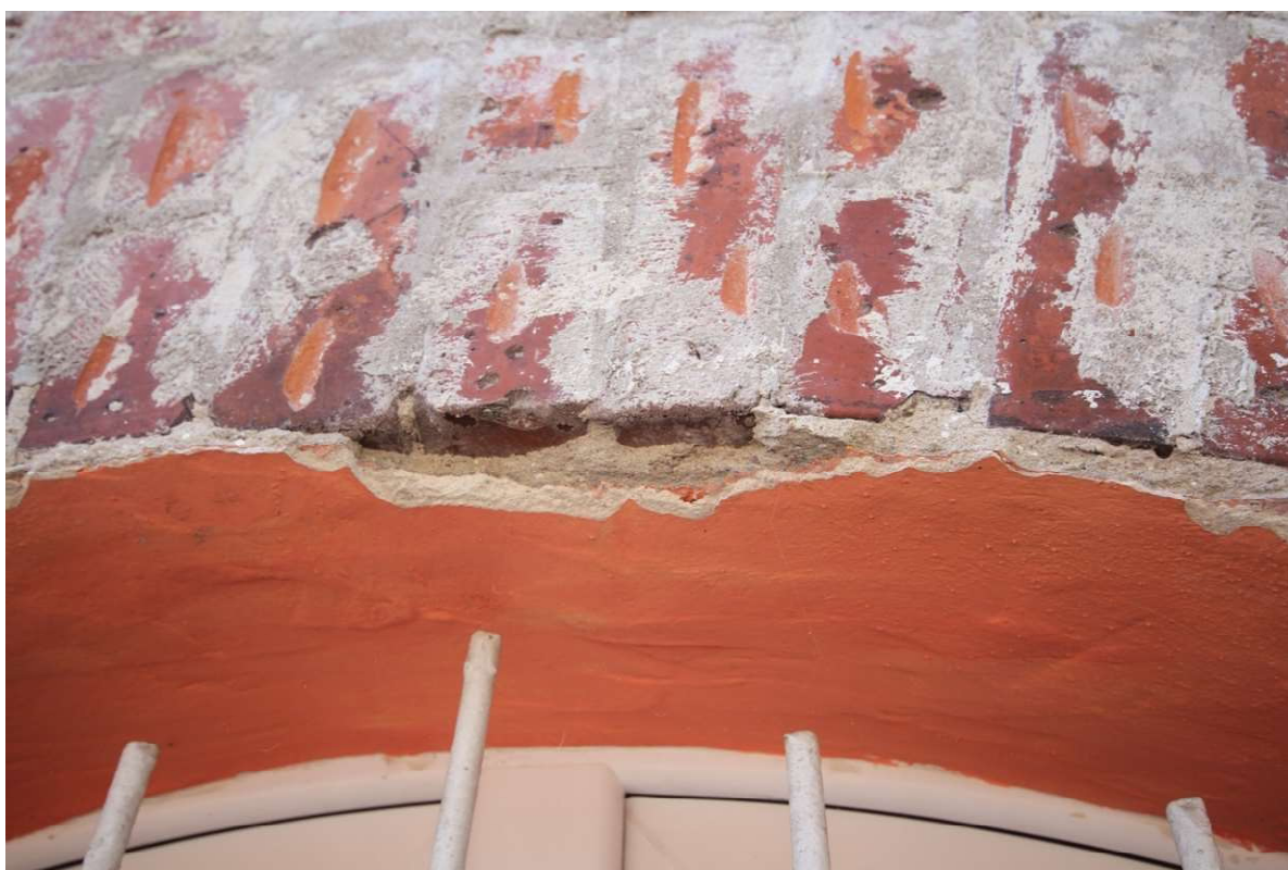
6. Elewacja frontowa, łuk okna piwnicznego; odspajające się warstwy wtórnego tynku. Fot. Paulina Szczurek, 2024 r.
