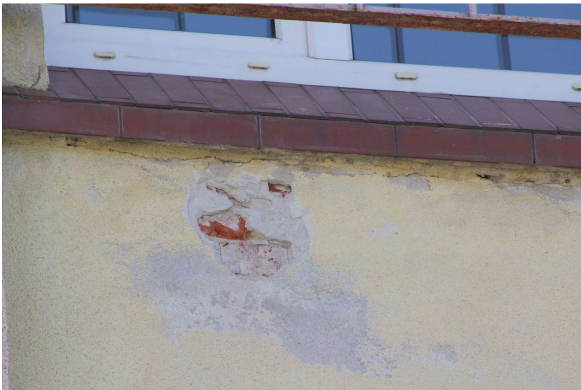
11. Elewacja frontowa, pseudoryzalit południowy, odkrywka w niszy. Spoina nie jest barwiona, co może wskazywać na otynkowanie tych partii budynku. Fot. Paulina Szczurek, 2024 r.
