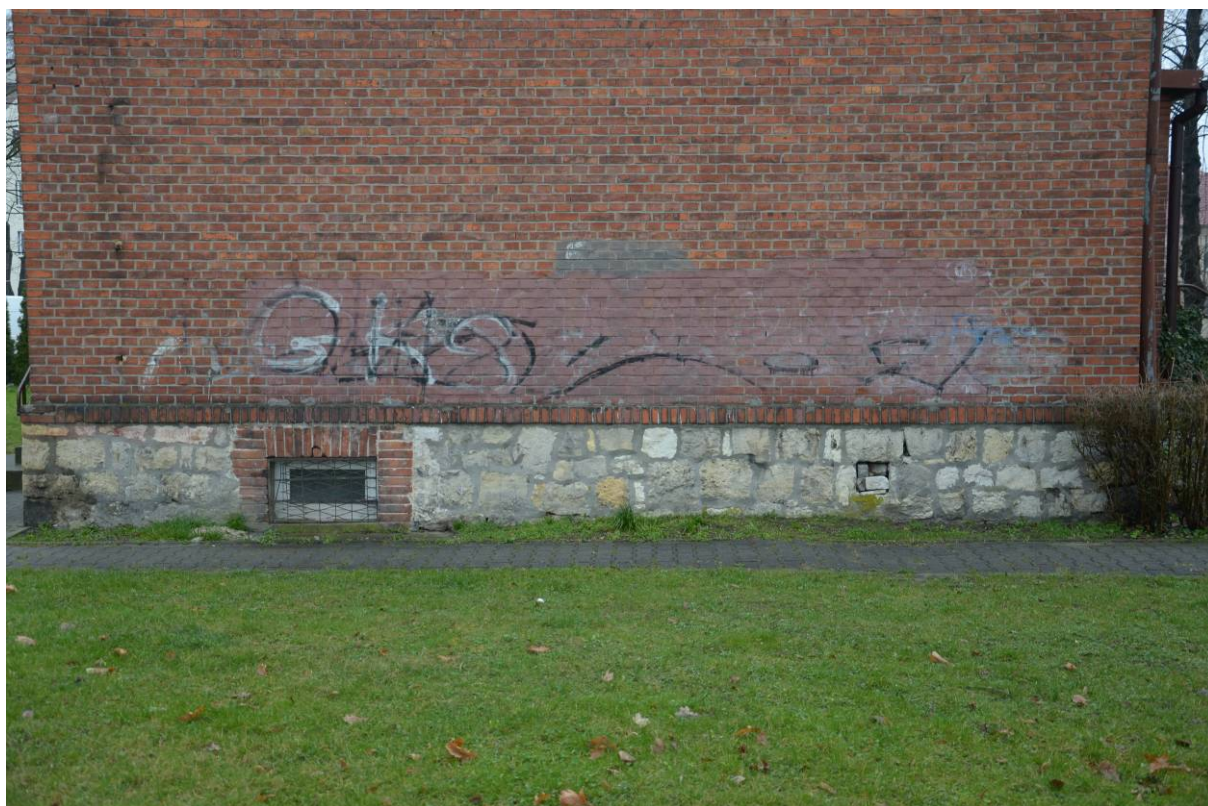
Fot. nr 21. Budynek przy ul. Klonowej 2, elewacja południowa, kamienna podmurówka cokołu oraz akty wandalizmu na ceglanej elewacji.
