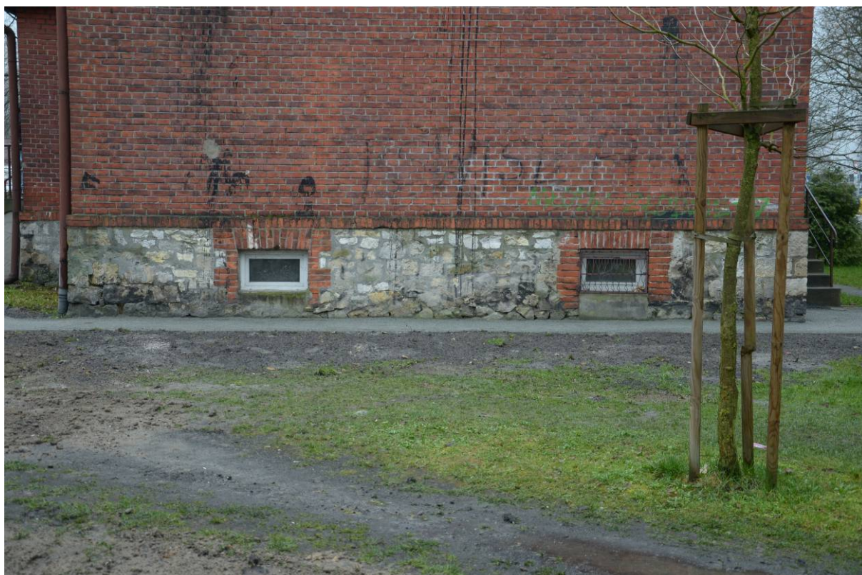
Fot. nr 14. Budynek przy ul. Klonowej 2, elewacja północna, widok kamiennej podmurówki cokołu.
