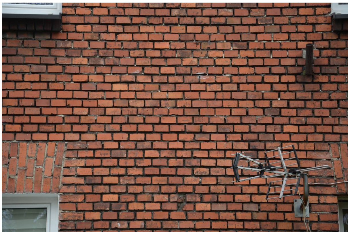
Fot. nr 38. Budynek przy ul. Klonowej 6, elewacja zachodnia, widok wątku ceglanego ściany.
