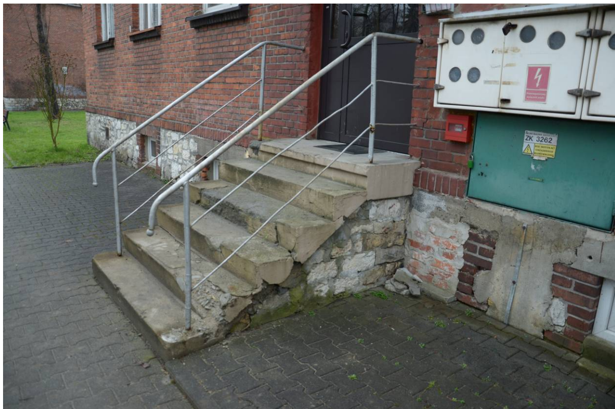
Fot. nr 24. Budynek przy ul. Klonowej 4, elewacja zachodnia, stan zachowania żelbetowych schodów.
