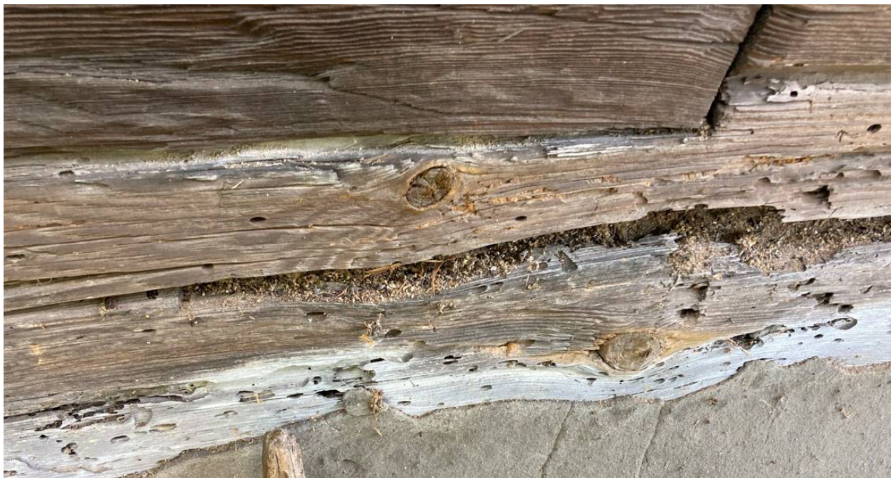
Zdjęcie nr 8 – Zniszczenia w podwalinie ściany południowej
