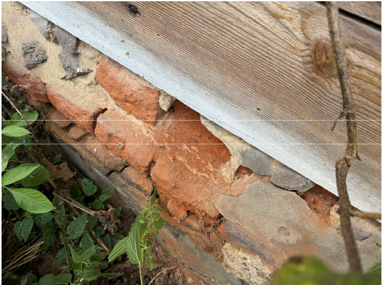
Zdjęcie nr 7 – Fragment ściany fundamentowej – elementy ceglane
