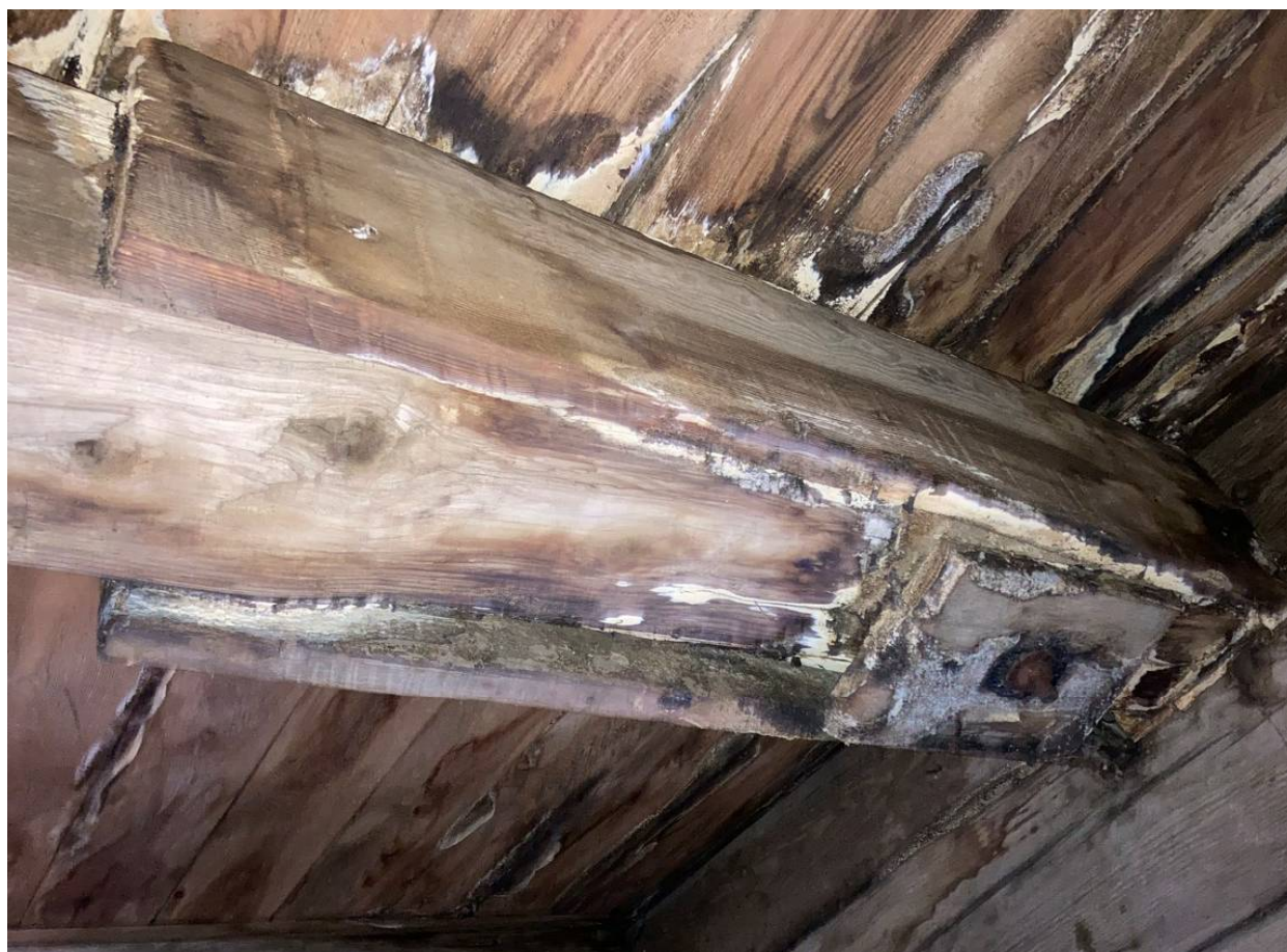
Zdjęcie nr 9 – Korozja biologiczna belki stropowej i leżącej na niej podłogi
