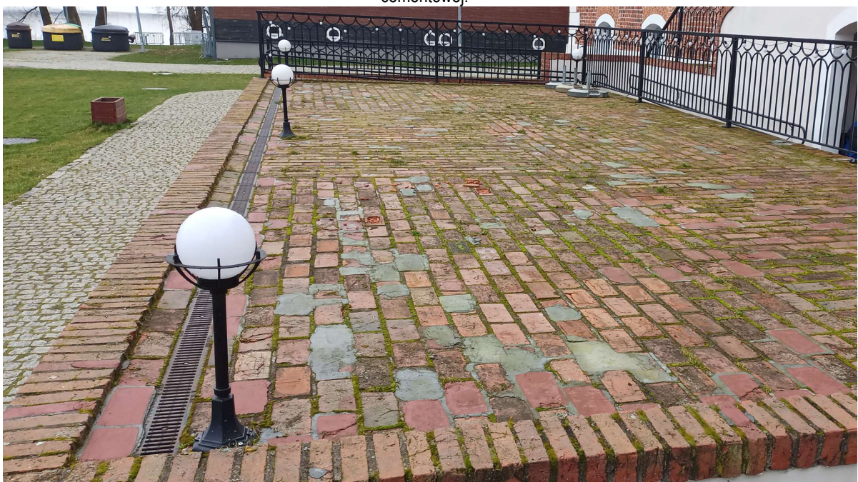
Zdjęcie nr 4.1.2. Widok powierzchni tarasu. Widoczne spękania cegieł. Uzupełnianie ubytków za pomocą zaprawy cementowej.
