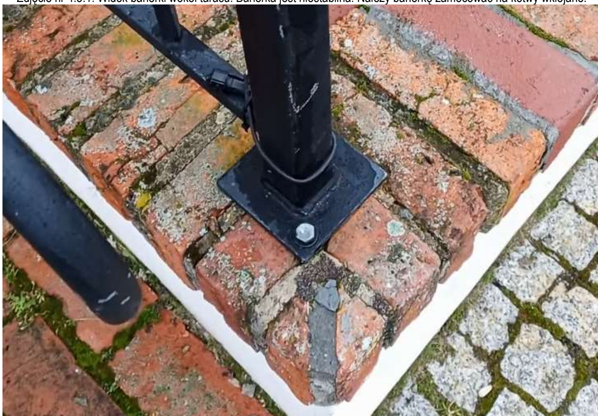
Zdjęcie nr 4.3.2. Widok mocowań bariery do cokołu. Śruby poluzowane.
