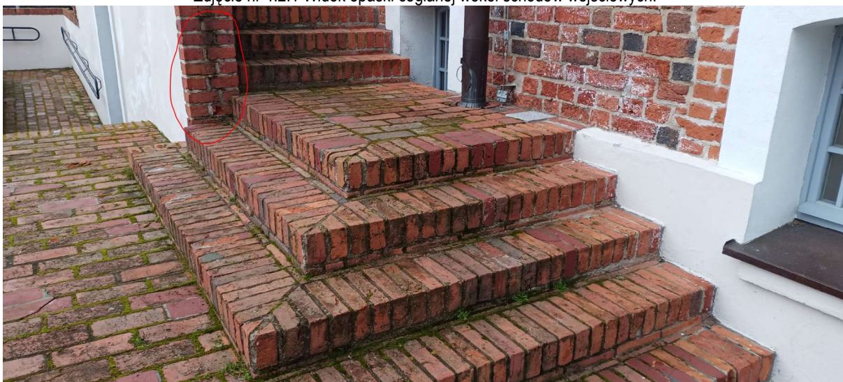
Zdjęcie nr 4.2.2. Widok na schody prowadzące do restauracji. Opaska przy murze do wymiany.
