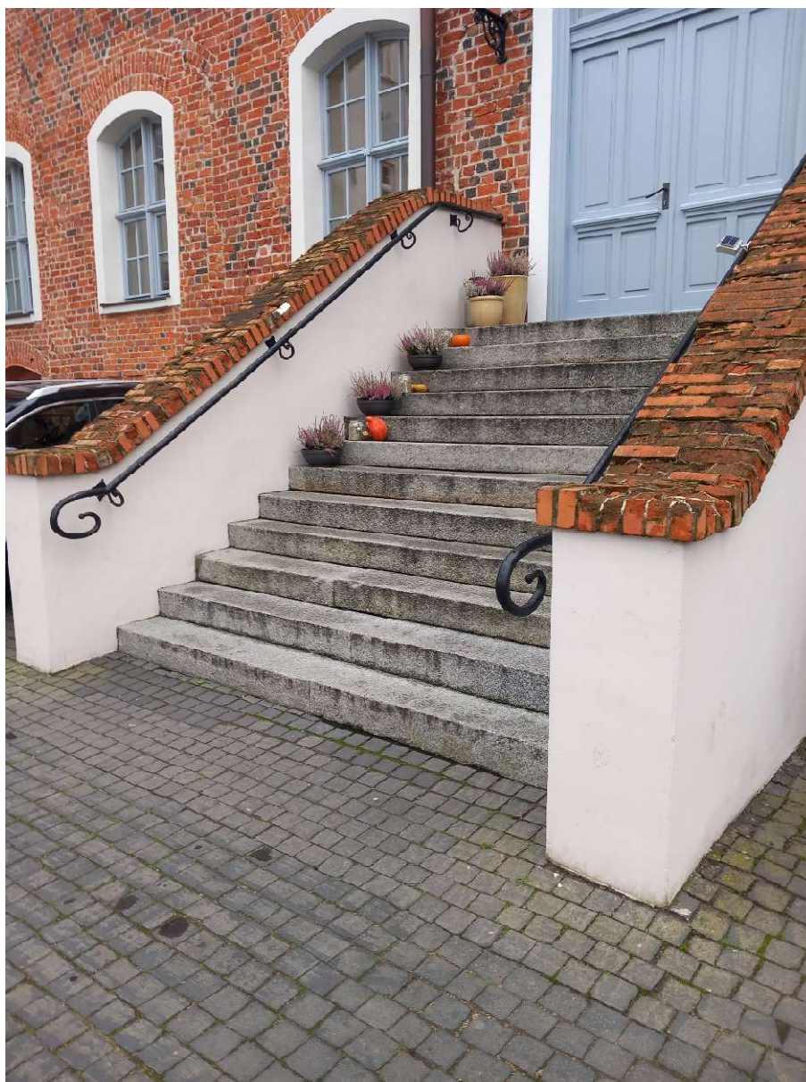
Zdjęcie nr 4.2.2. Zwierńczenie balustrady schodów do wymiany.
