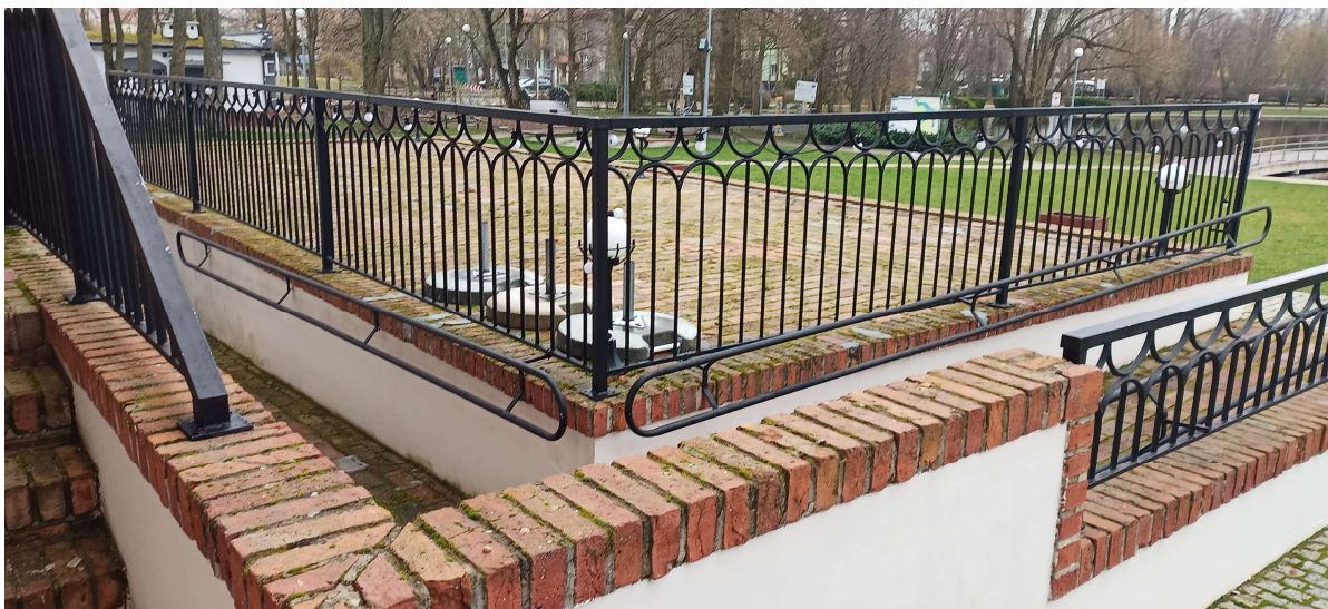
Zdjęcie nr 4.3.1. Widok barierki wokół tarasu. Barierka jest niestabilna. Należy barierkę zamocować na kotwy wklejane.
