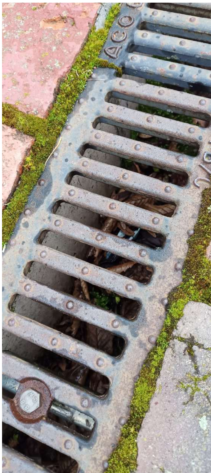
Zdjęcie nr 4.1.5. Widok odwodnienia liniowego. Odwodnienie do oczyszczzenia.
