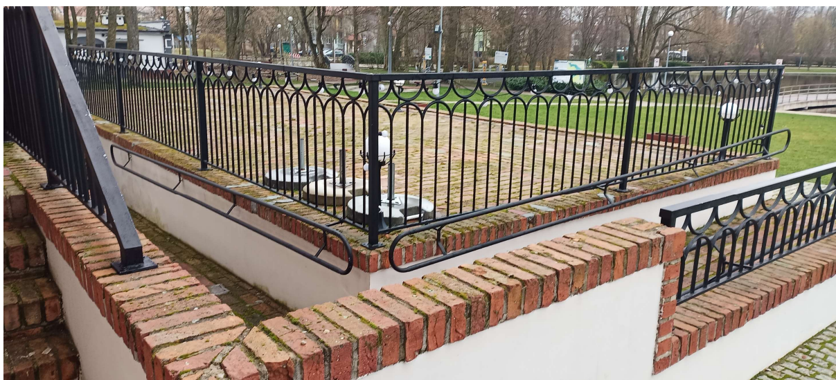
Zdjęcie nr 4.3.1. Widok bariery wokół tarasu. Bariery jest niestabilna. Należy barierę zamocować na kotwy wklejane.
