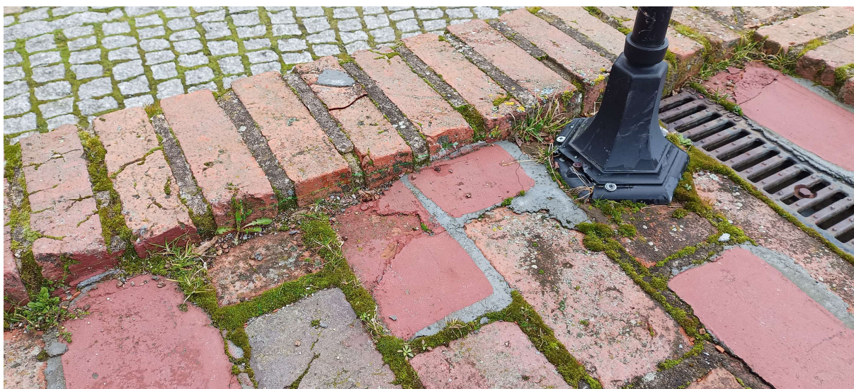
Zdjęcie nr 4.1.1. Widok narożnika tarasu. Widoczne spękania tarasu oraz spękania opaski wokół tarasu.
