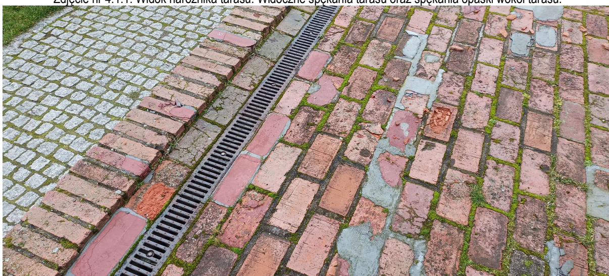
Zdjęcie nr 4.1.2. Widok powierzchni tarasu. Widoczne spękania cegieł. Uzupełnianie ubytków za pomocą zaprawy cementowej.
