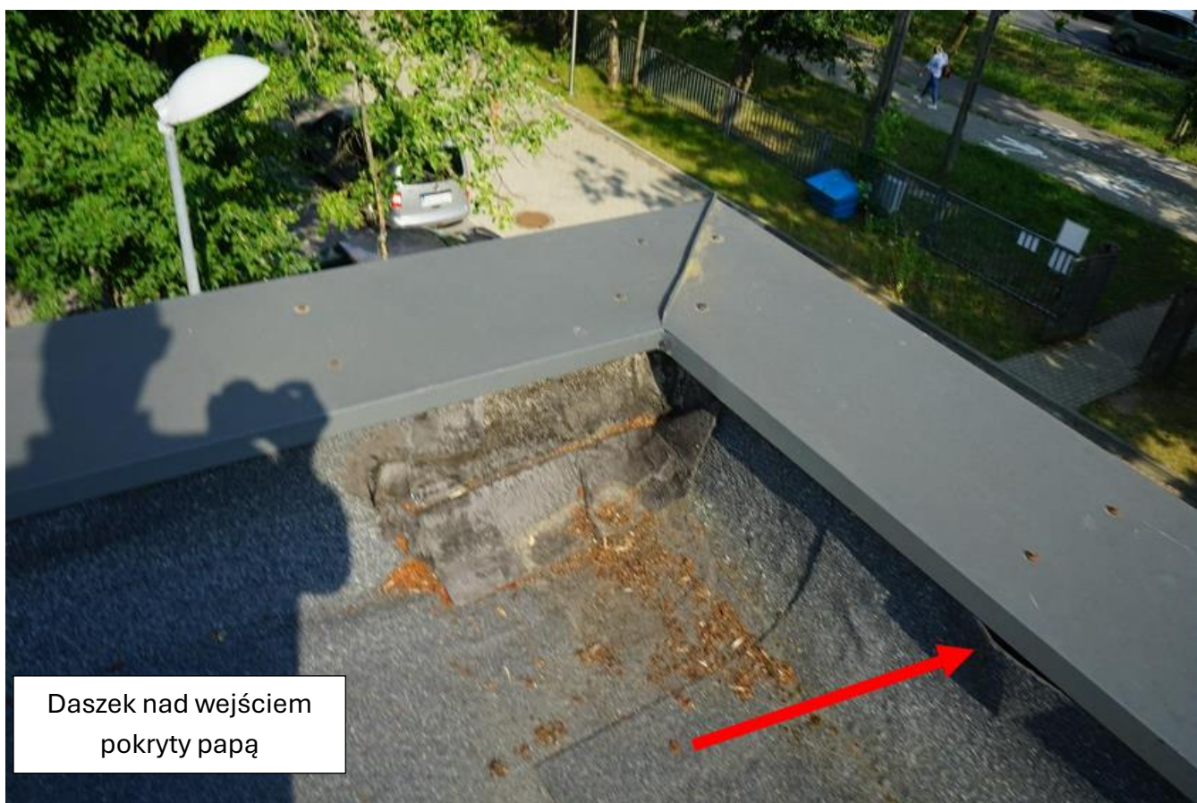
Kanał bez odpływu wody opadowej
