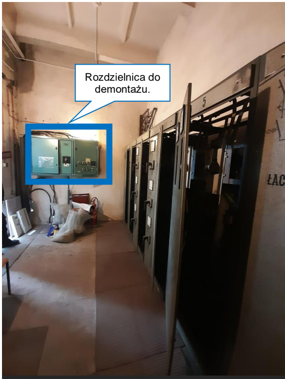
Rys. 3. Istniejąca rozdzielnica elektryczna do demontażu
