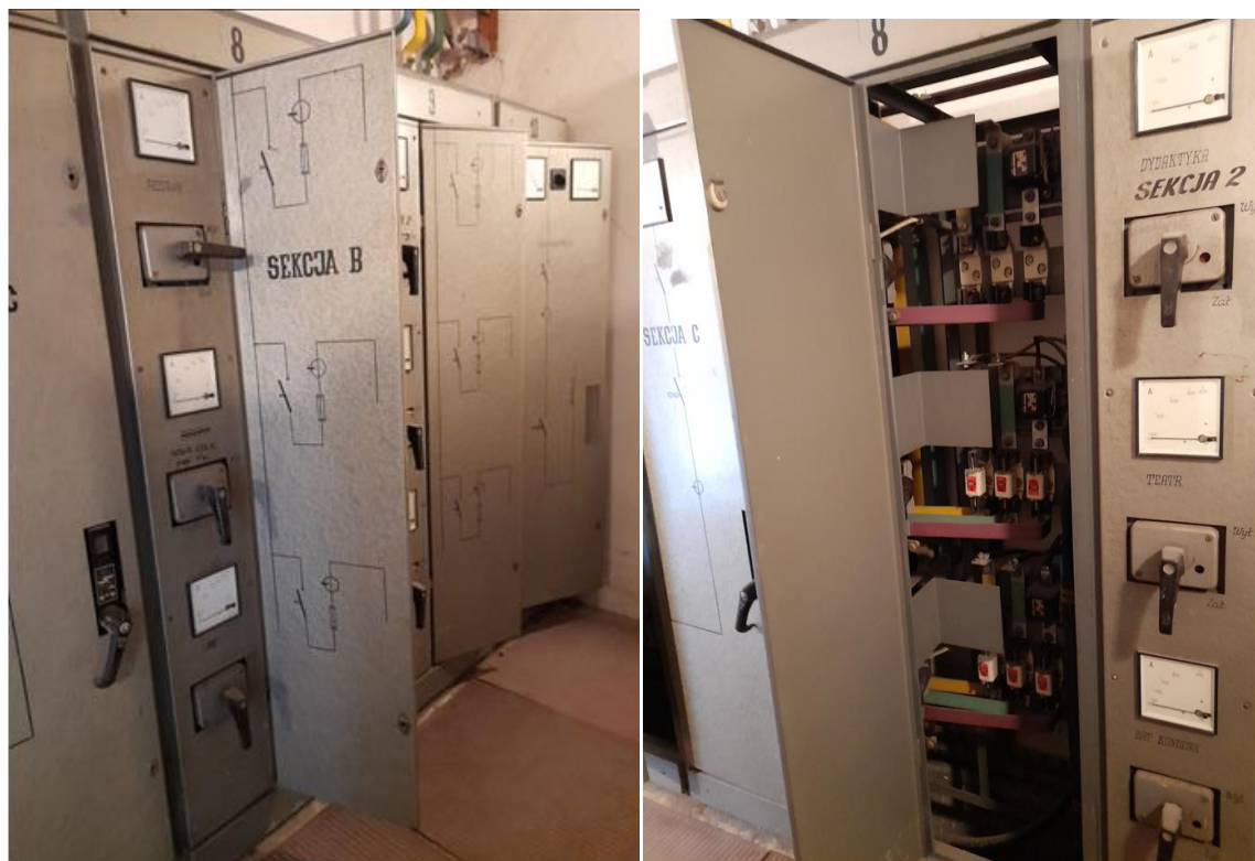
Rys. 6. Rozdzielnica główna nn – rezerwa na wyprowadzenie linii zasilającej
