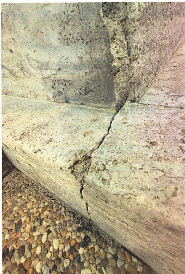
fot. 35. Wejście główne elewacji frontowej, widoczne „ześlępnienie” i dezintegracja okładzin z trawertynu.
