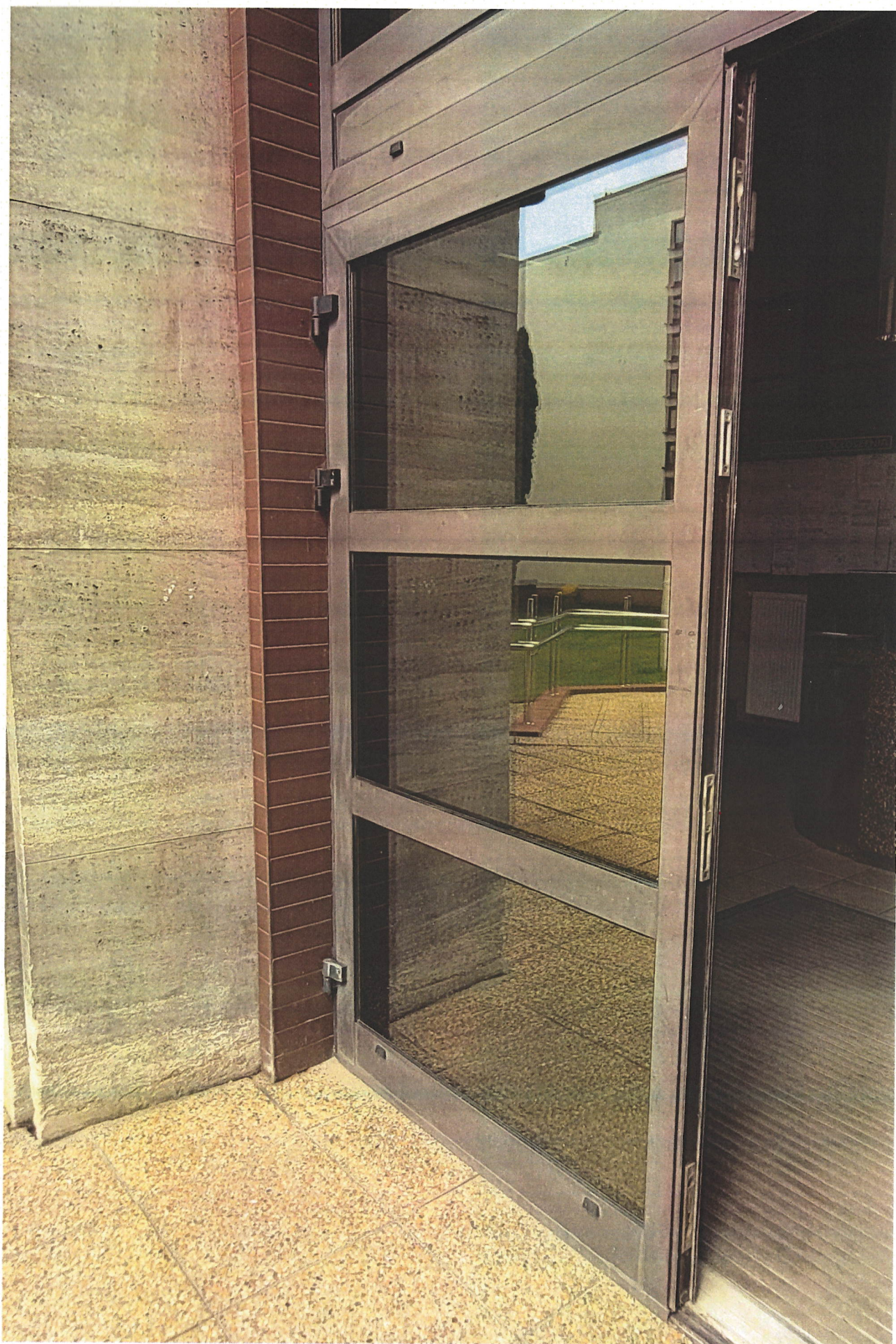
fot. 30. Budynek Sądu Okręgowego - wejście główne elewacji frontowej, stolarka drzwiowa i okienna wymieniona w 1997 roku - widoczne „ześlęgnięcie” i dezintegracja okładzin z trawertynu - stan sierpień 2024 roku.
