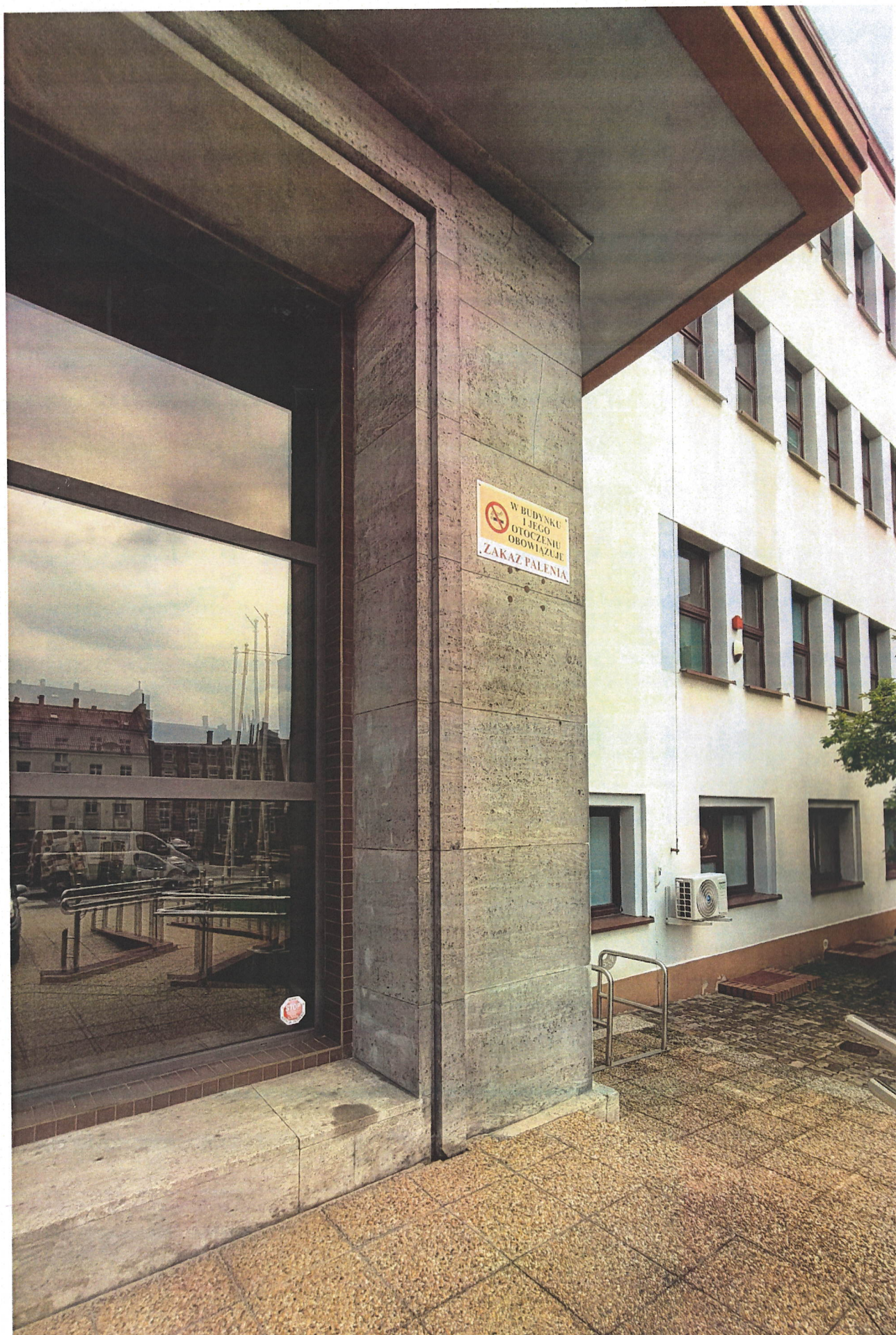
fot. 29. Budynek Sądu Okręgowego - wejście główne elewacji frontowej, stolarka drzwiowa i okienna wymieniona w 1997 roku - widoczne „ześlępięcie” okładzin z trawertynu - stan sierpień 2024 roku.
