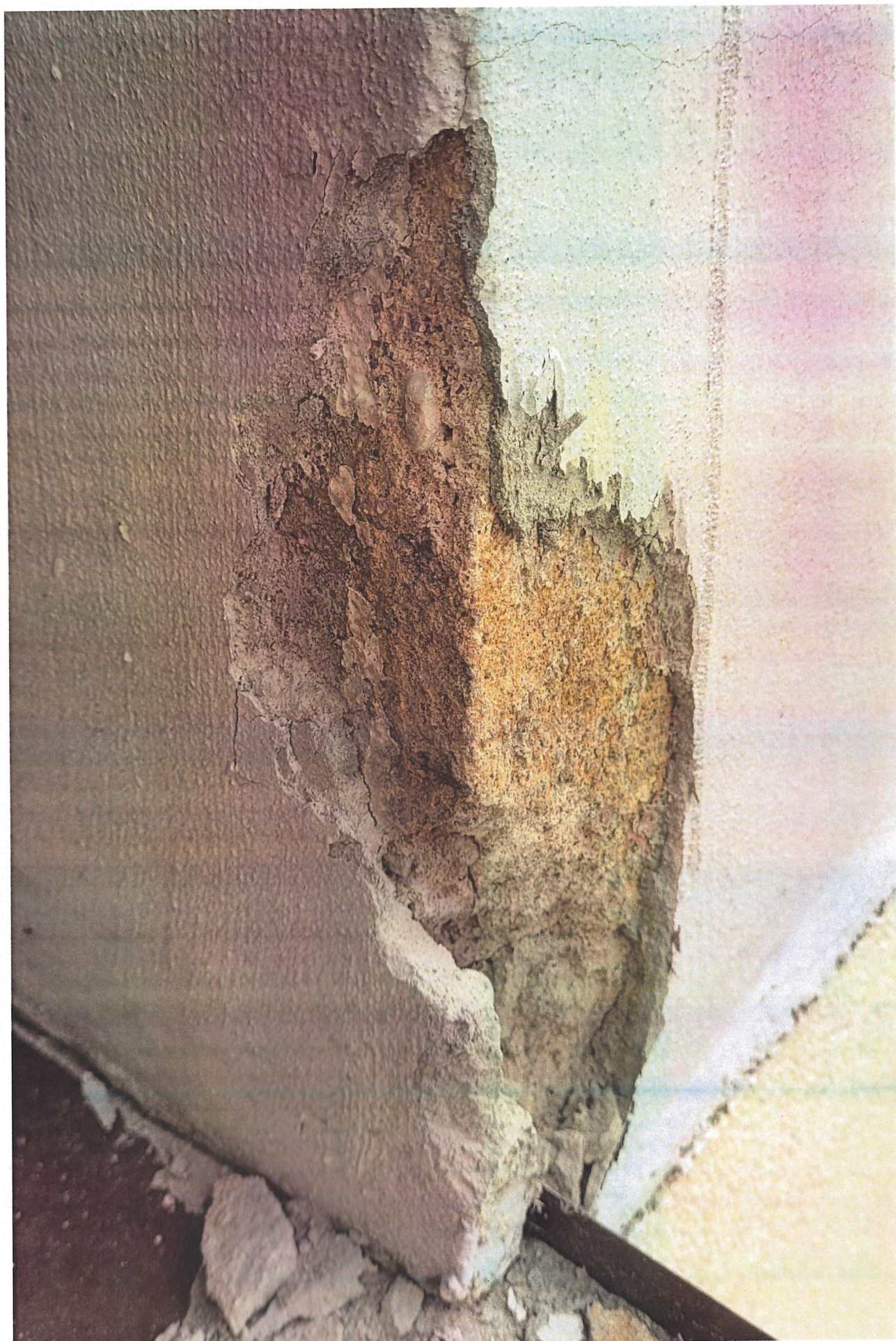
fot. 71. Ościeże okienne elewacji frontowej budynku Sądu Okręgowego w Koszalinie - widoczna okładzina ze szlachetnej wyprawy mineralnej z gruboziarnistym żółtym kruszywem klinkierowym odsłonięta spod wtórnych warstw zapraw.
