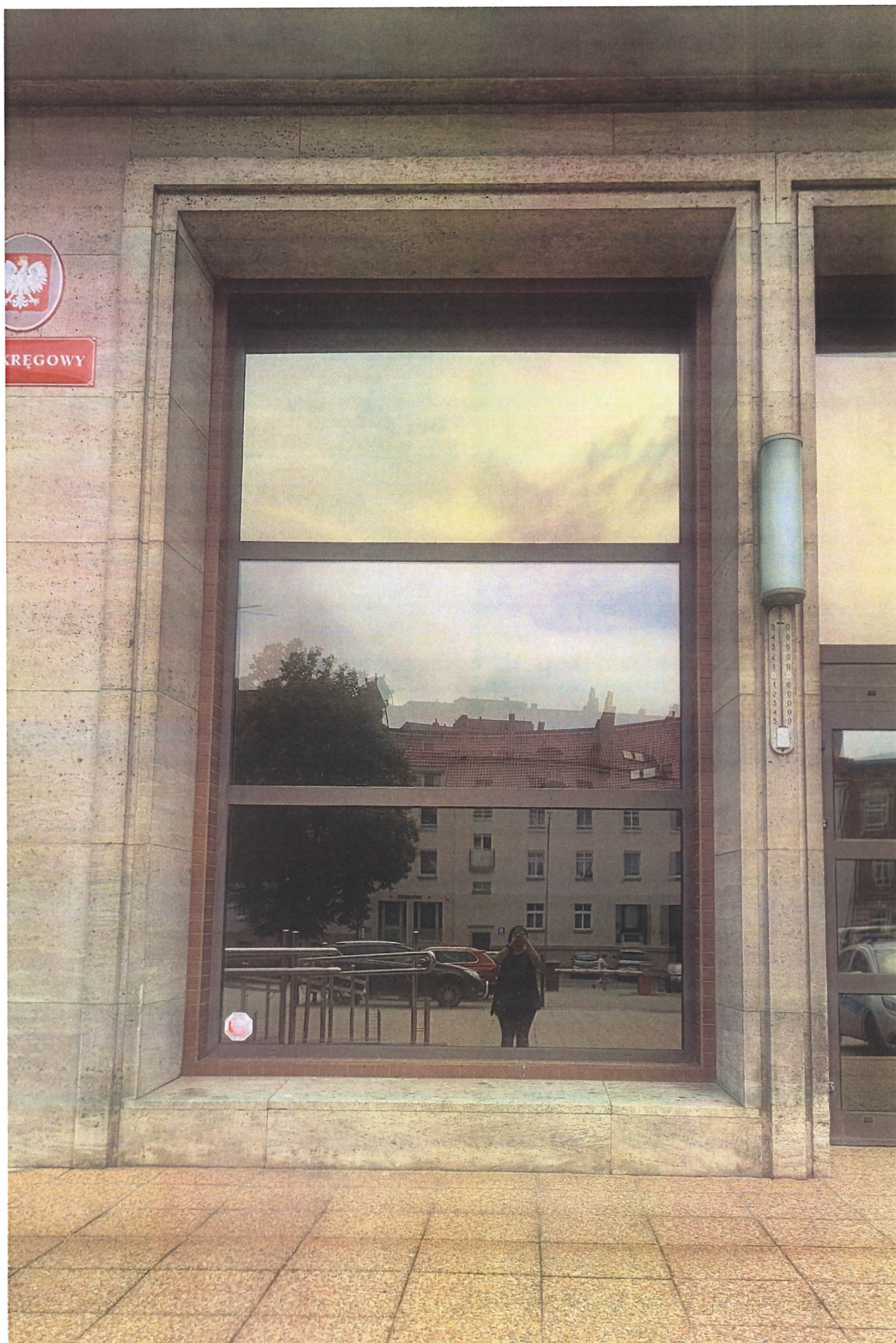
fot. 28. Budynek Sądu Okręgowego - wejście główne elewacji frontowej, stolarka drzwiowa i okienna wymieniona w 1997 roku - stan sierpień 2024 roku.
