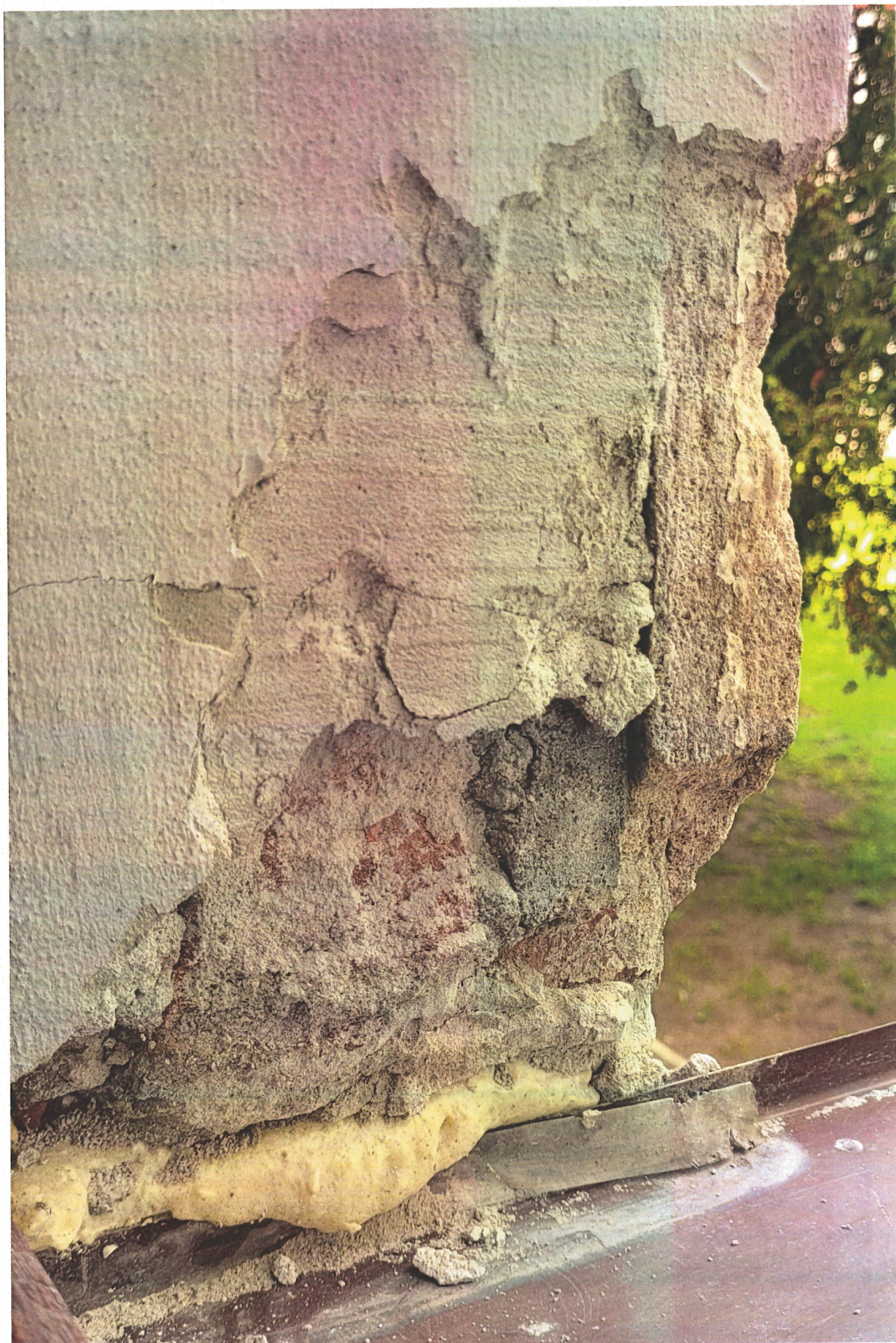
fot. 74. Ościeże okienne elewacji frontowej budynku Sądu Okręgowego w Koszalinie - widoczna okładzina ze szlachetnej wyprawy mineralnej z gruboziarnistym żółtym kruszywem klinkierowym odsłonięta spod wtórnych warstw zapraw.
