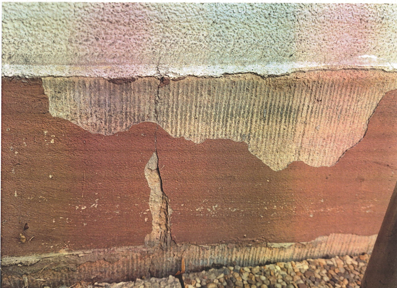
fot. 38. Budynek Sądu Okręgowego - cokół ze szlachetnej wyprawy mineralnej z gruboziarnistym żółtym kruszywem klinkierowym, zdobiony ryflowaniem, widoczne łuszczące się wtórne wyprawy nałożone na oryginalne zdobienia.
