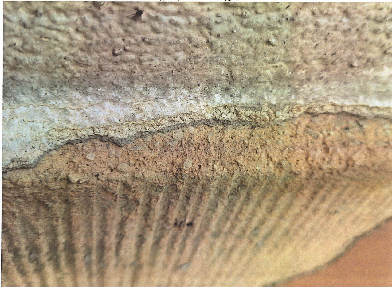
fot. 39. Budynek Sądu Okręgowego - cokół ze szlachetnej wyprawy mineralnej z gruboziarnistym żółtym kruszywem klinkierowym, zdobiony ryflowaniem.
