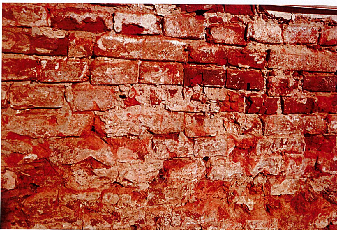
Fot. 20 Zniszczone lico cegły ścian piwnicy.
