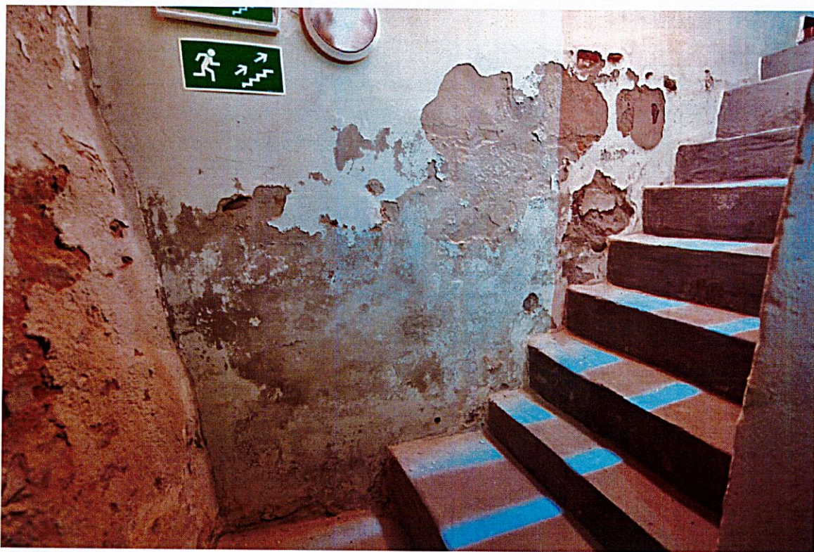
Fot. 21 Łuszcząca się farba i odparzający tynk na klatce schodowej prowadzącej do piwnicy.
