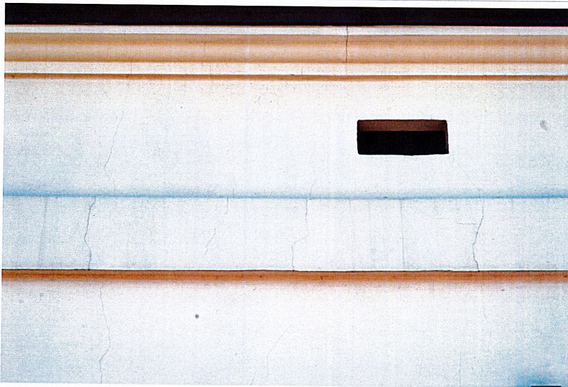
Fot. 11 Rysy skurczowe i zabrudzenia elewacji zachodniej.
