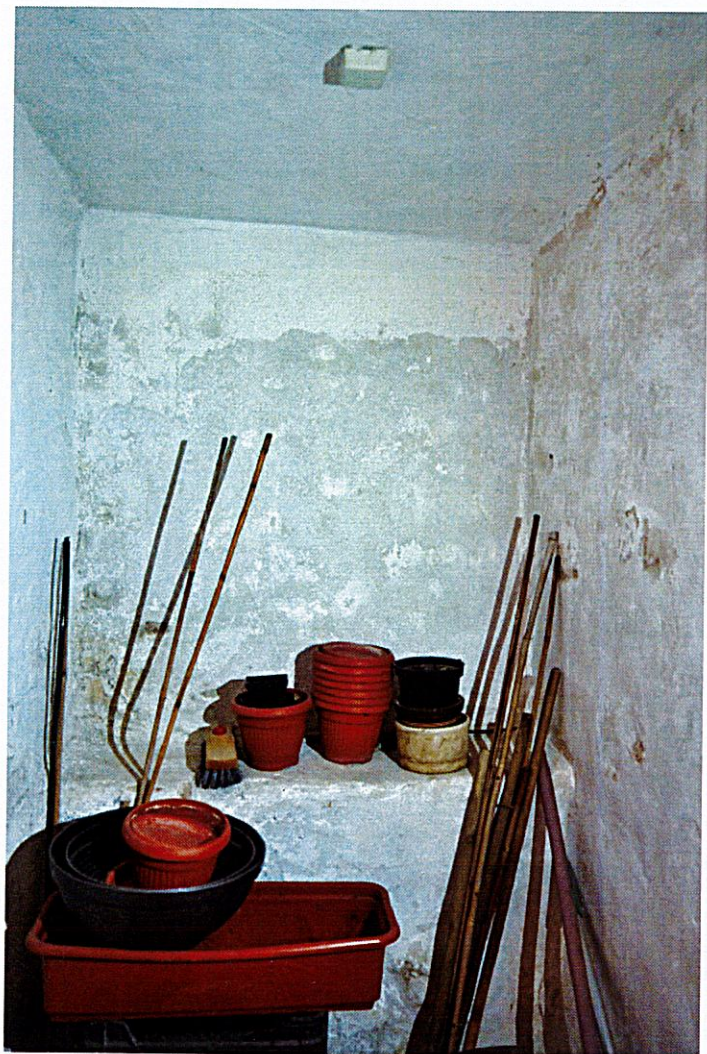
Fot. 23 Odpadająca farba w pomieszczeniu przy klatce schodowej.
