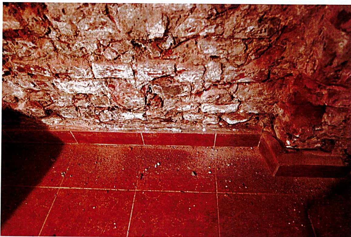
Fot. 19 Proces osypywania się lica cegły jest w dalszym ciągu czynne i widoczny na posadzkach pomieszczeń.
