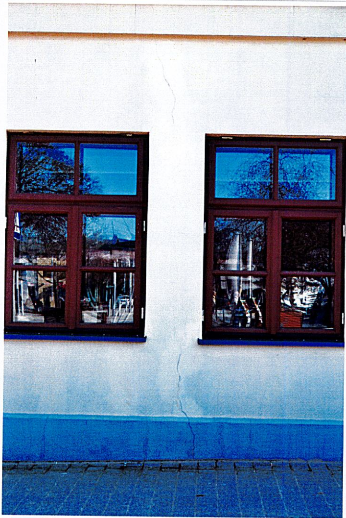
Fot. 7 Doraźnie naprawiane i zamalowywane rysy konstrukcyjne i skurczowe na elewacji zachodniej.
