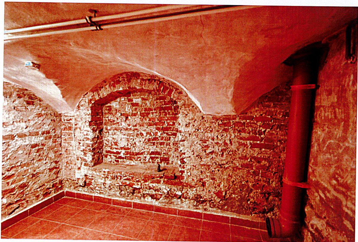
Fot. 16 Zawilgocone i zasolone ściany piwnic.
