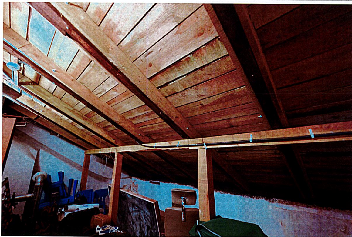
Fot. 33 Nieocieplone pomieszczenie magazynowe na poddaszu.
