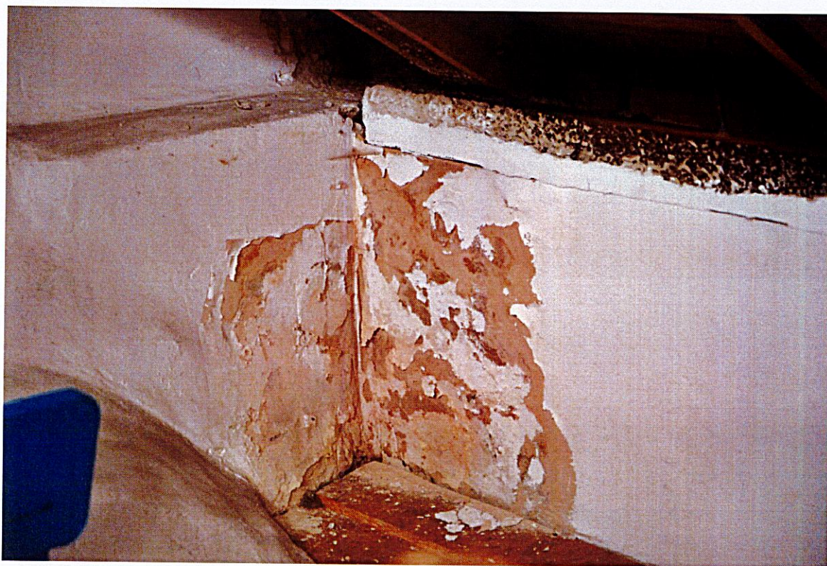
Fot. 26 Spurchlenia, odparzenia tynku i łuszcząca się farba na poddaszu budynku.
