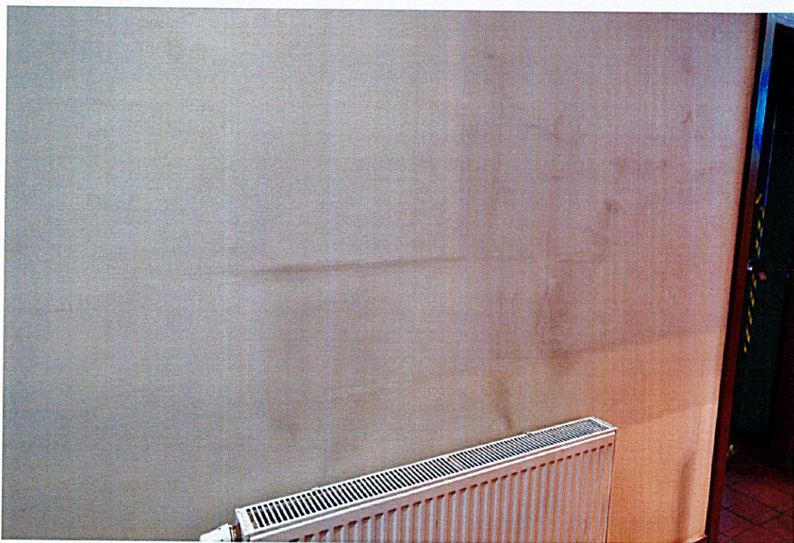
Fot. 38 Zabrudzenia ściany ponad grzejnikami konwekcyjnymi.
