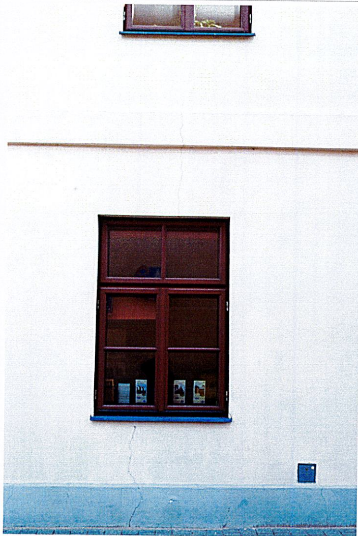
Fot. 5 Rysy na elewacji południowej będące wynikiem pracy konstrukcyjnej budynku.
