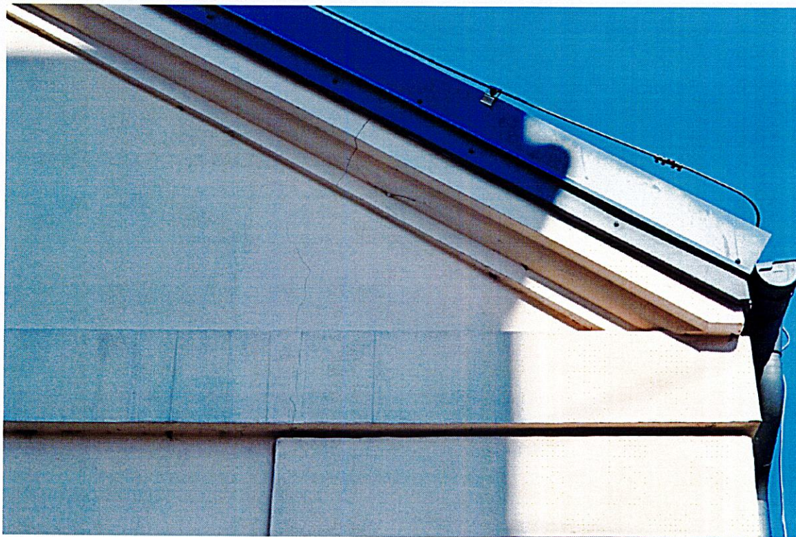
Fot. 9 Niewielkie rysy skurczowe i zabrudzenia pasa elewacyjnego na szczycie południowym budynku.
