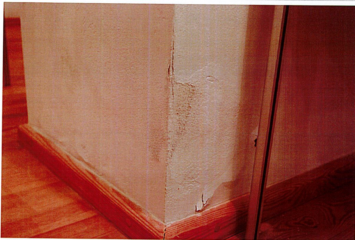
Fot. 25 Spurchlenia i odparzenia tynku na parterze budynku.
