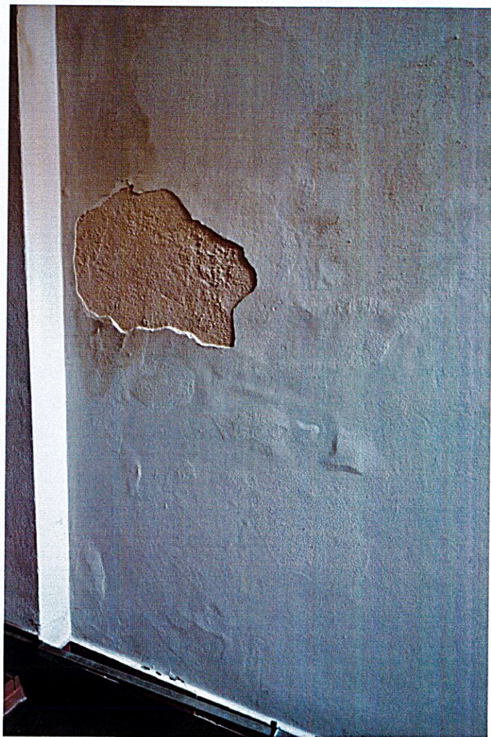
Fot. 24 Spurchlenia i odparzenia tynku występują również na parterze budynku.
