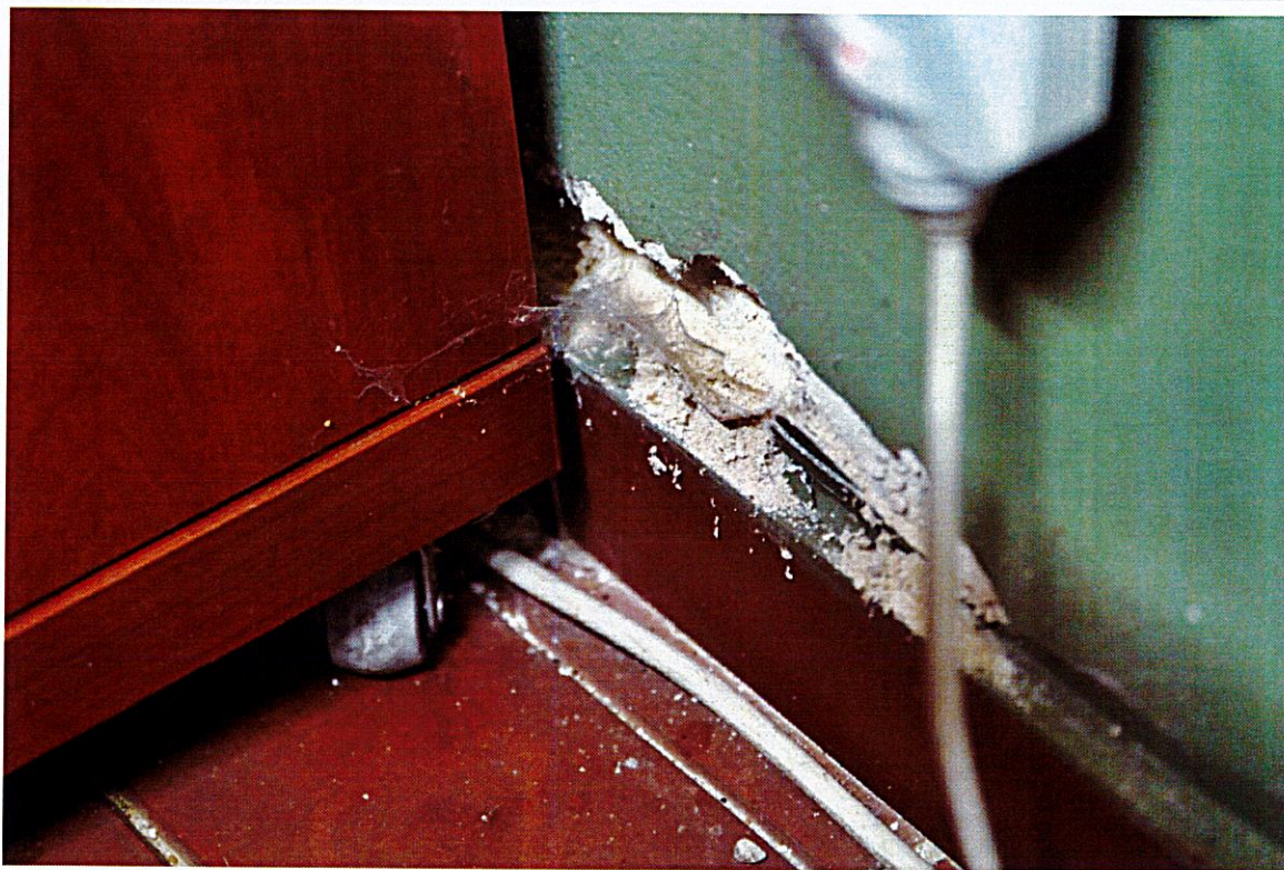
Fot. 29 Zawilgocenie i zasolenie ściany powodują destrukcję tynku w pomieszczeniu na parterze.
