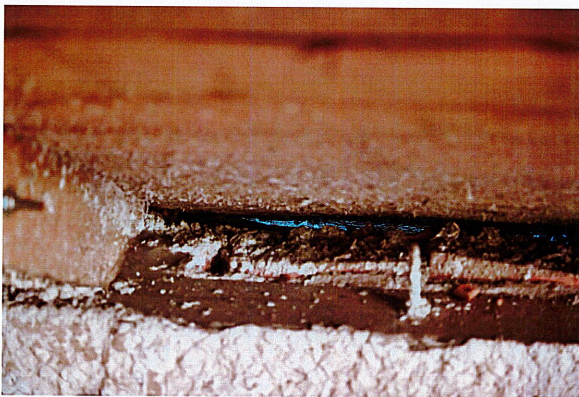
Fot. 30 Widoczna szczelina między deskowaniem a ścianą kolankowa na poddaszu.
