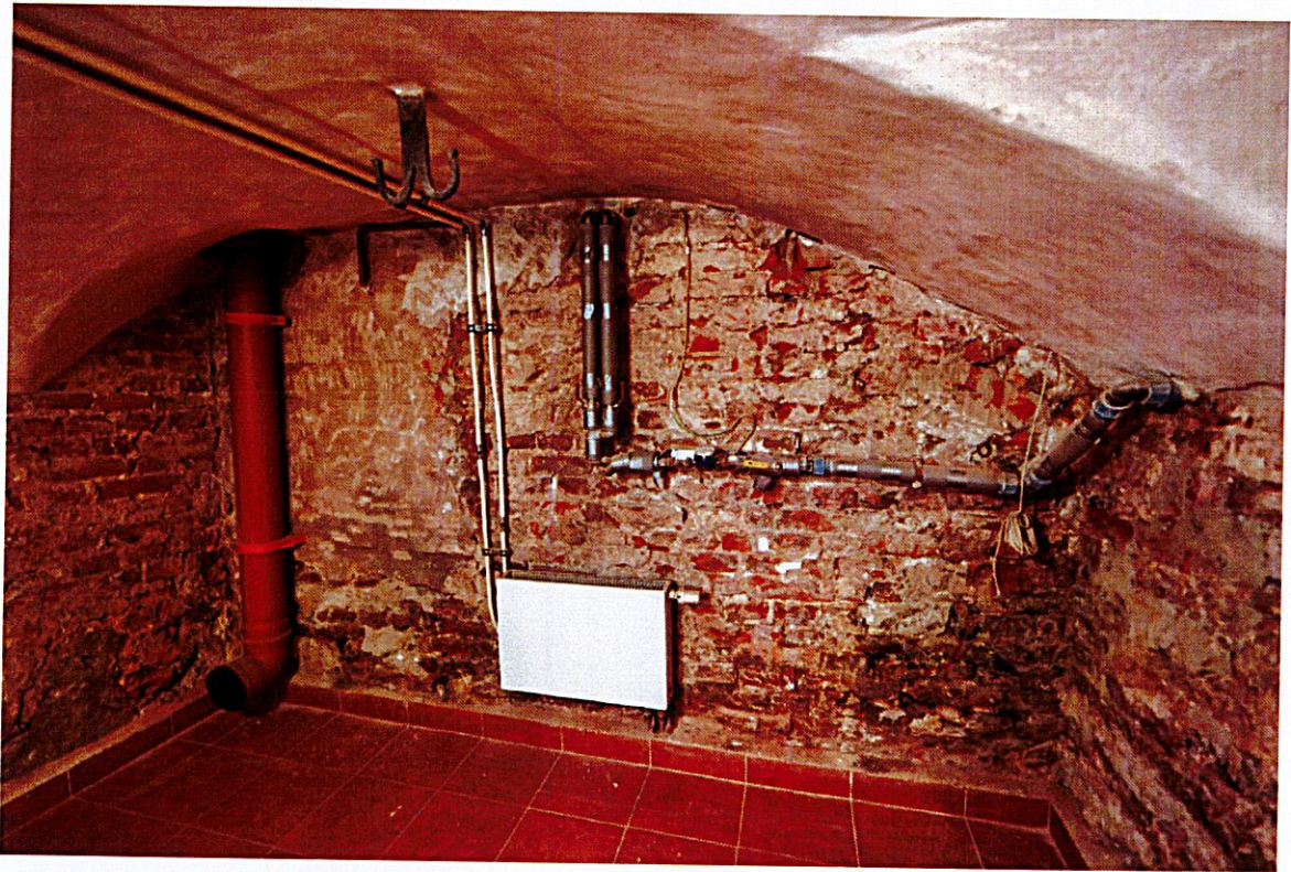
Fot. 15 Zawilgocone i zasolone ściany piwnic.
