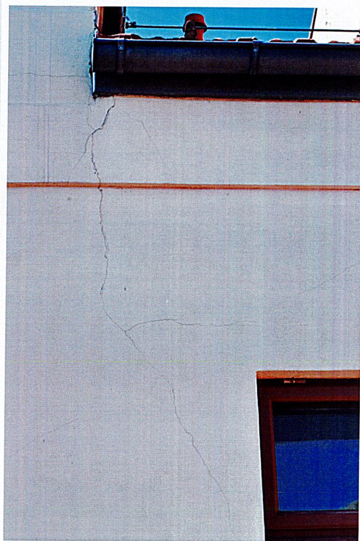
Fot. 6 rysa przy facjacie elewacji zachodniej. będąca wynikiem pracy konstrukcyjnej budynku.
