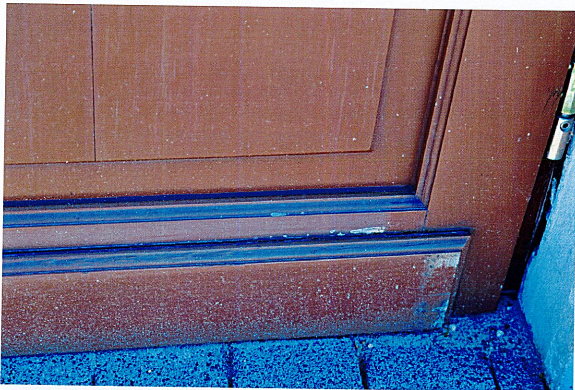
Fot. 43 Zniszczenia powłoki malarskiej w okolicach progu drzwi (listwy odbojowej).
