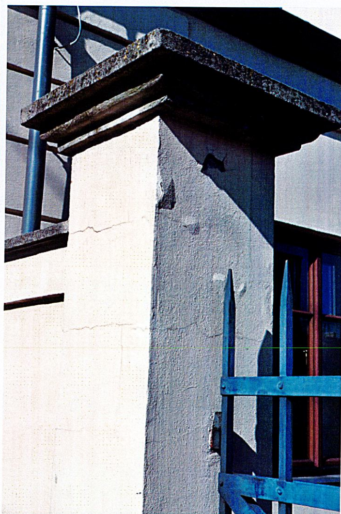
Fot. 8 Rysy skurczowe i spurchlenia farby na słupku przy bramie ogrodzenia od strony południowej.
