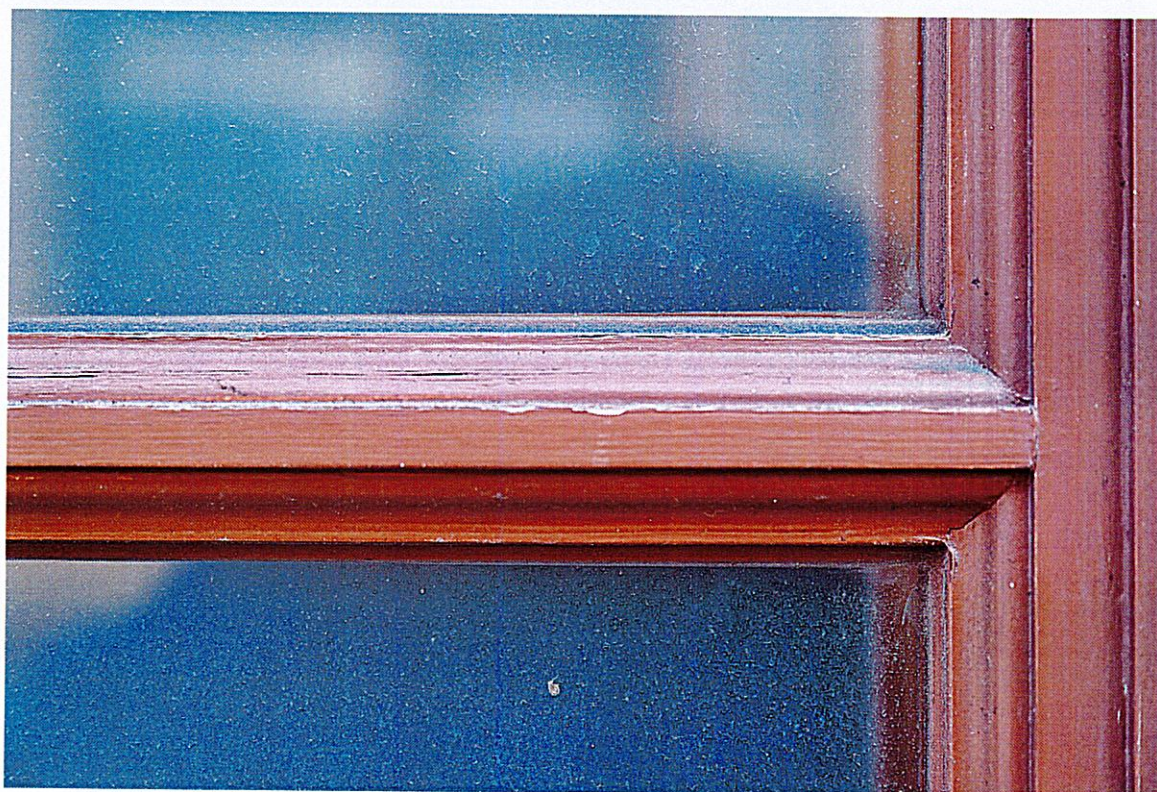
Fot. 42 Proces odpadania powłoki malarskiej na stolarce rozpoczyna się od krawędzi profili.
