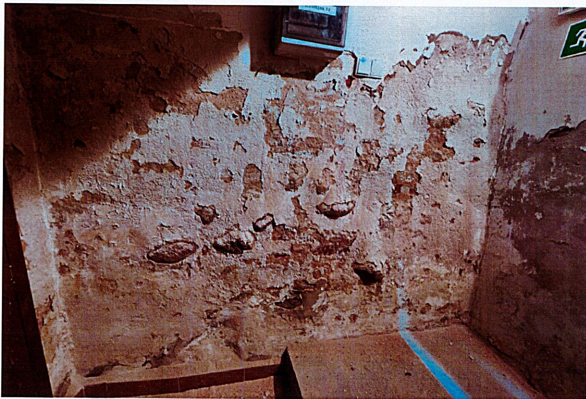
Fot. 22 Łuszcząca się farba i odparzający tynk na spoczniku klatki schodowej w piwnicy.
